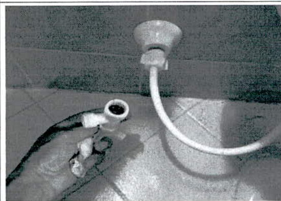
INSTALACION DE ACOPLER
