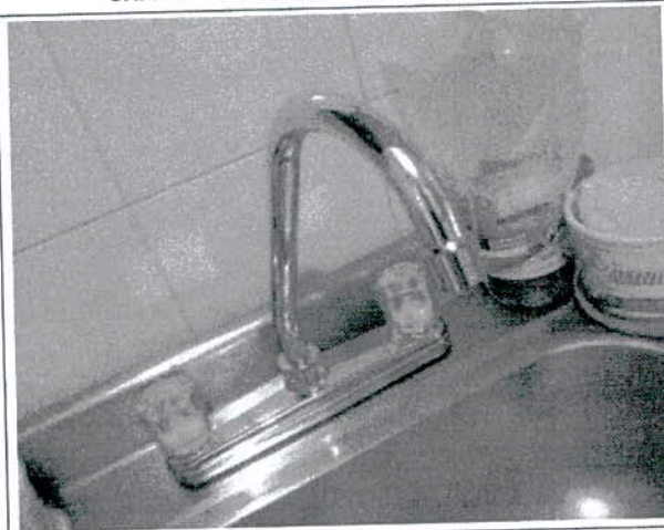
CAMBIO DE GRIFERIA DE LAVAPLATOS
