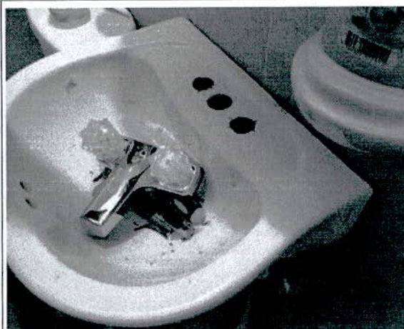
CAMBIO DE GRIFERIA DE LAVAMANOS
