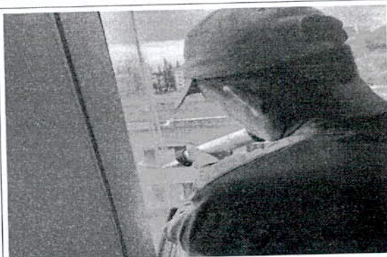
APLICACIÓN DE SILICONA EN VENTANA
