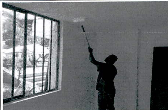
APLICACIÓN DE PINTURA
