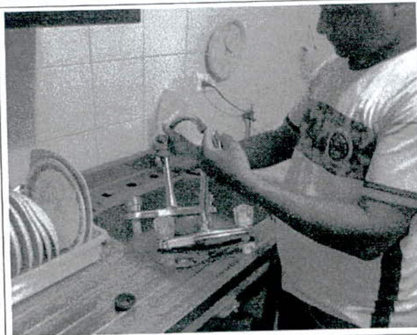
CAMBIO DE GRIFERIA DE LAVAPLATOS
