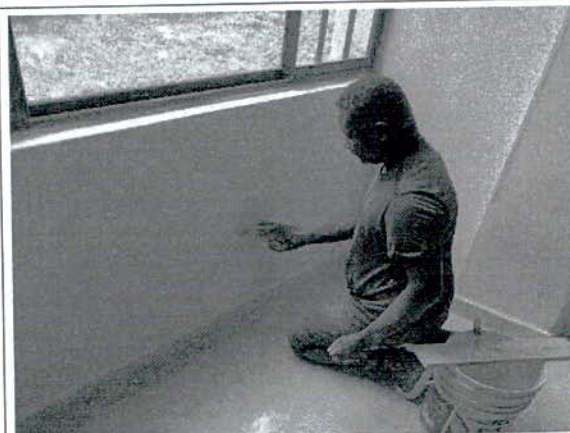
APLICACIÓN DE ESTUCO
