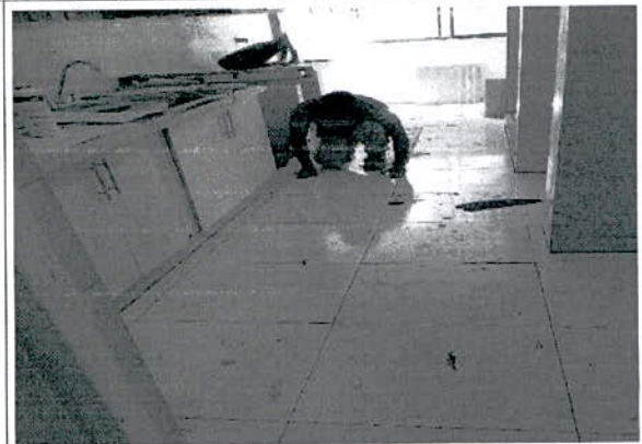
INSTALACION DE PISO
