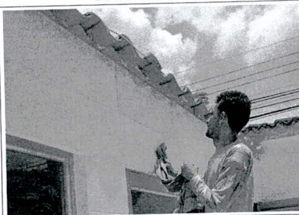
APLICACIÓN DE BOQUILLA
