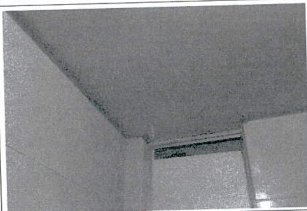
APLICACIÓN DE PINTURA
