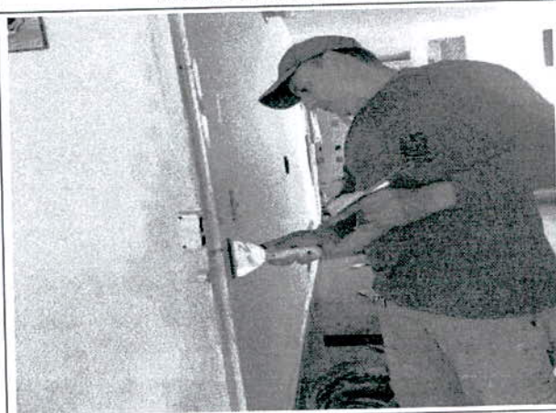
APLICACIÓN DE ESTUCO EN MARCO
