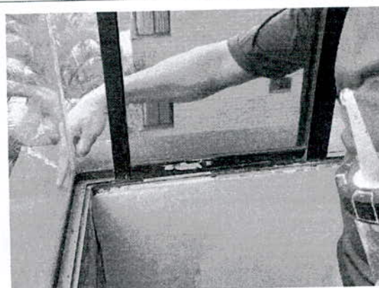
APLICACIÓN DE SILICONA EN VENTANA
