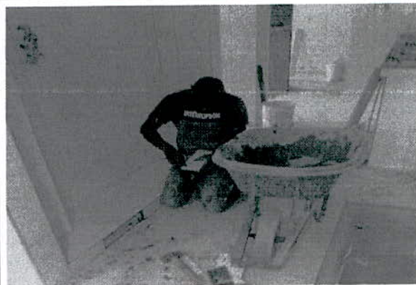
INSTALACION DE PISO
