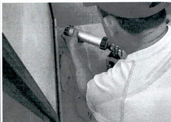
APLICACIÓN DE SILICONA EN DIVISION DE BAÑO
