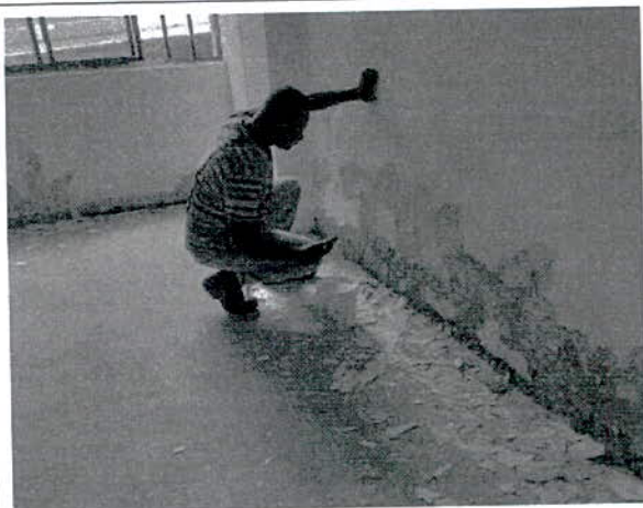
ARREGLO DE HUMEDADES
