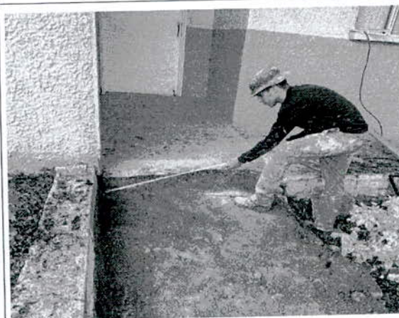
LEVANTAMIENTO DE PISO
