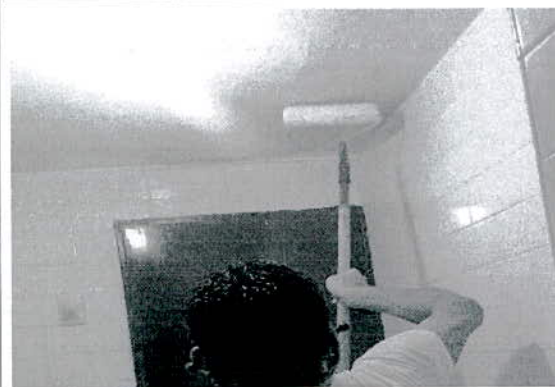
APLICACIÓN DE PINTURA
