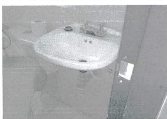
SIFON INSTALADO
