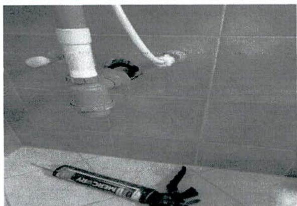
INSTALACION DE ACOPLER
