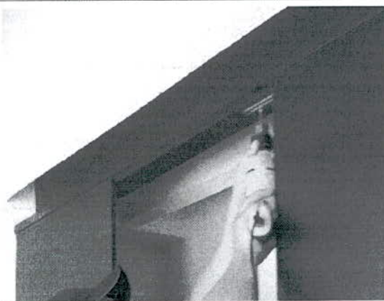
INSTALACION DE RIEL EN CLOSET
