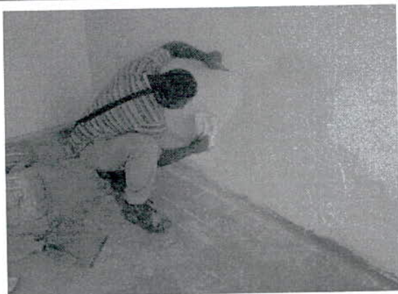
APLICACIÓN DE ESTUCO
