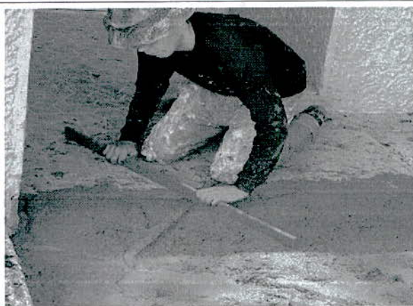
APLICACIÓN DE CEMENTO
