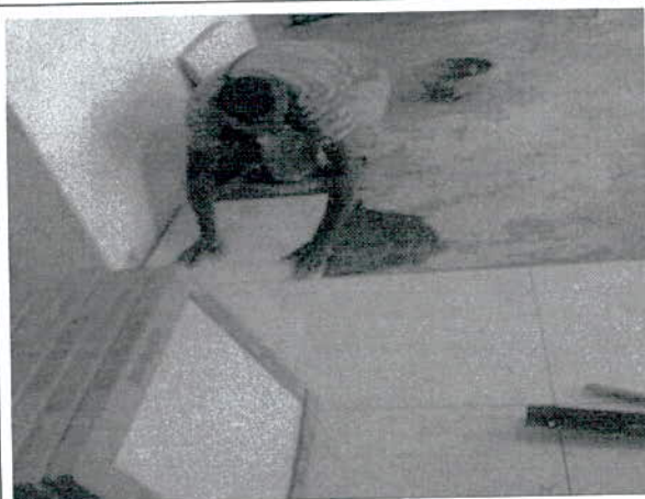
INSTALACION DE PISO
