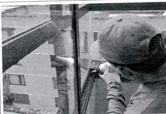
APLICACIÓN DE SILICONA EN VENTANA
