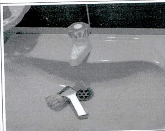
CAMBIO DE GRIFERIA DE LAVAMANOS
