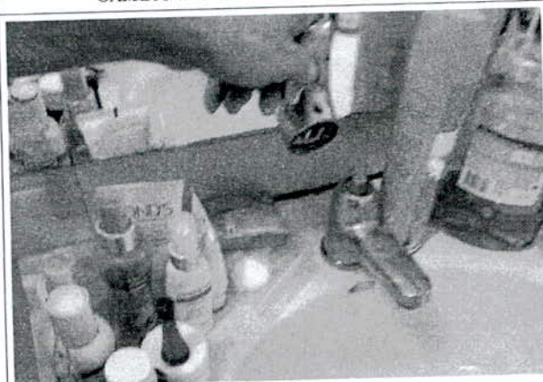
CAMBIO DE GRIFERIA DE LAVAMANOS
