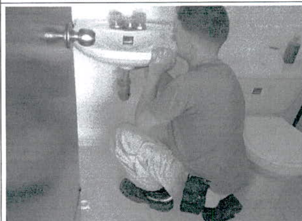
CAMBIO DE GRIFERIA DE LAVAMANOS
