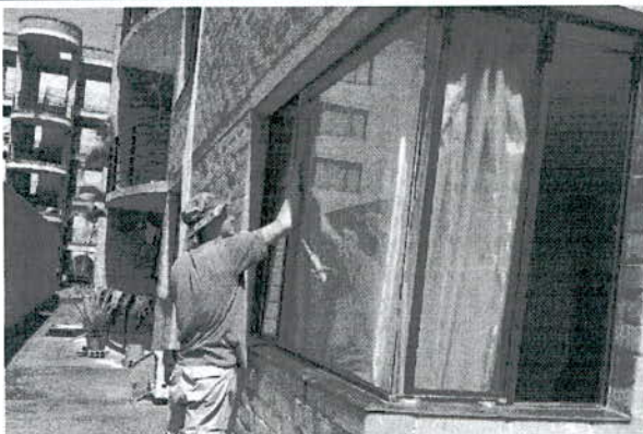
APLICACIÓN DE SILICONA EN VENTANA
