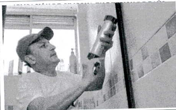
APLICACIÓN DE SILICONA EN DIVISION DE BAÑO
