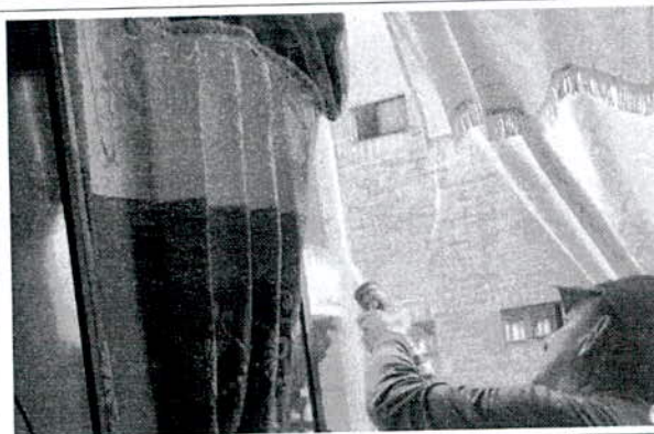
APLICACIÓN DE SILICONA EN VENTANA
