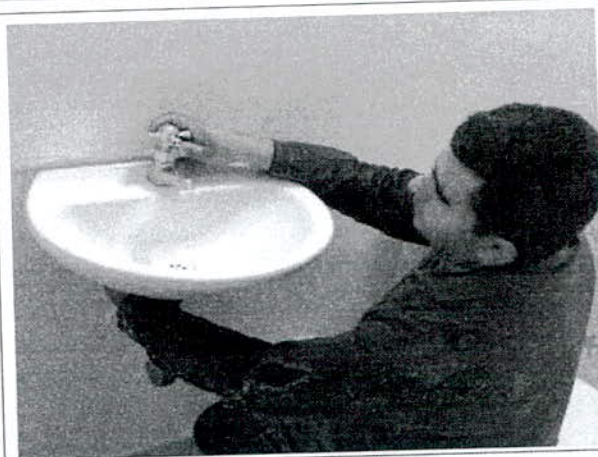
CAMBIO DE GRIFERIA DE LAVAMANOS
