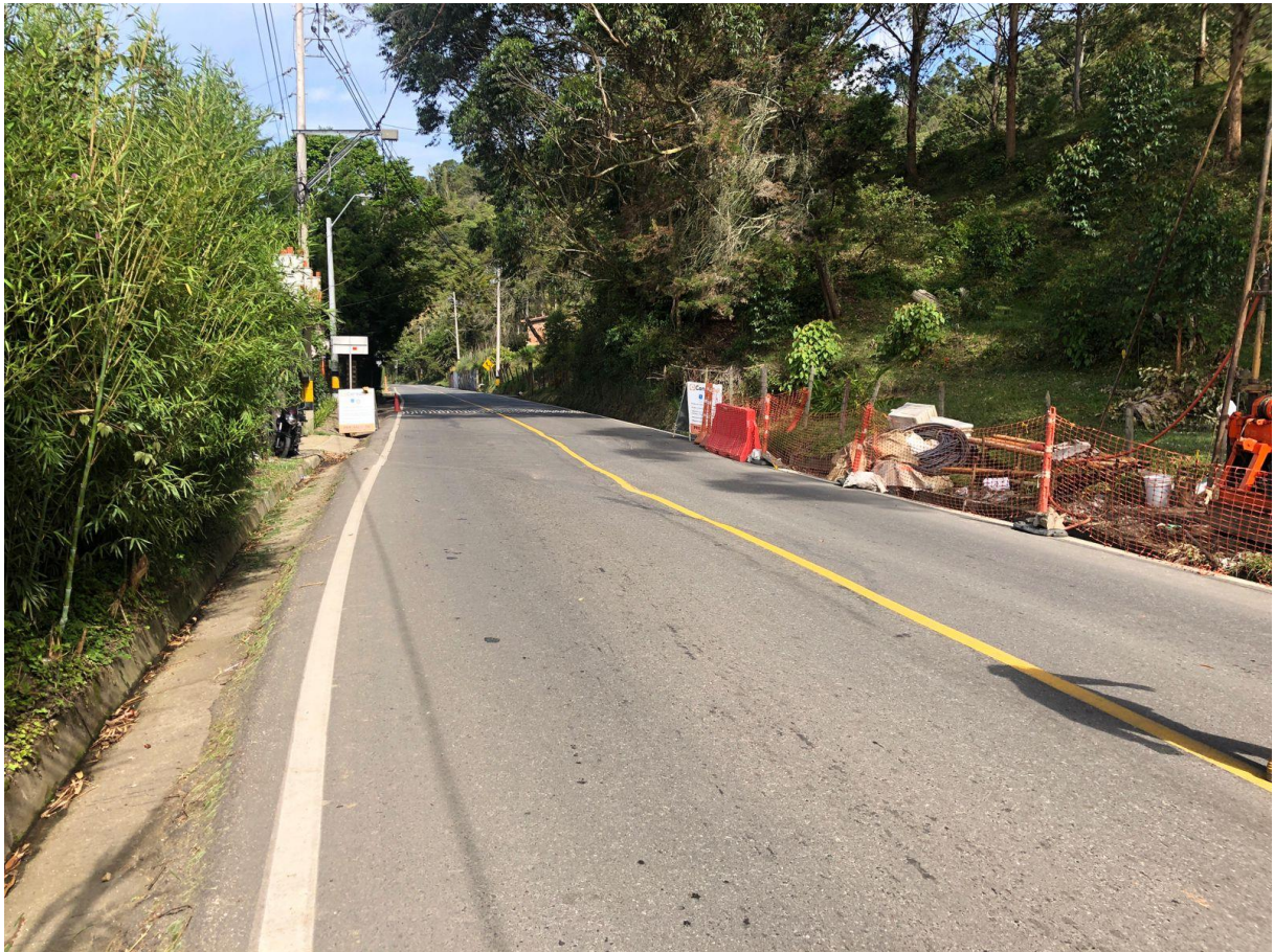
Fotografía 4. Evidencias de afectaciones y hundimientos en la capa de rodadura de la vía.
