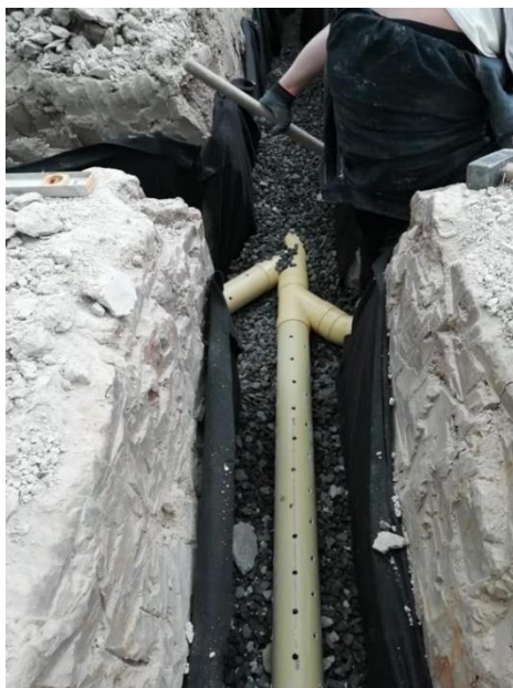
Figura 35. Filtro recomendado aguas arriba o contra zonas permeables. Esquemático
