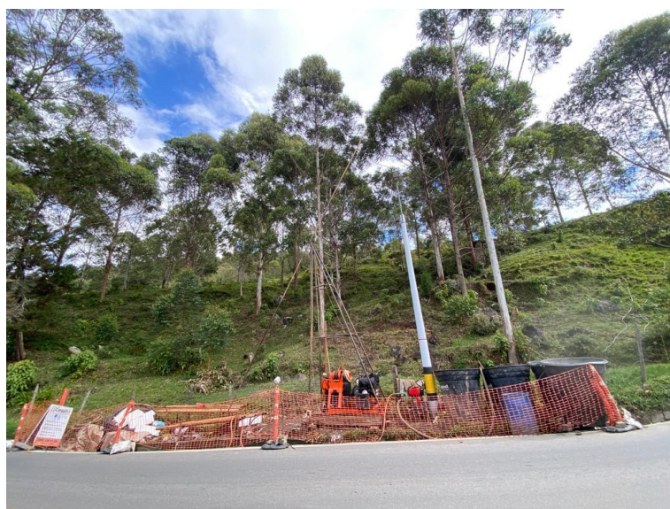
Fotografía 11. Ejecución Sondeo P1.
