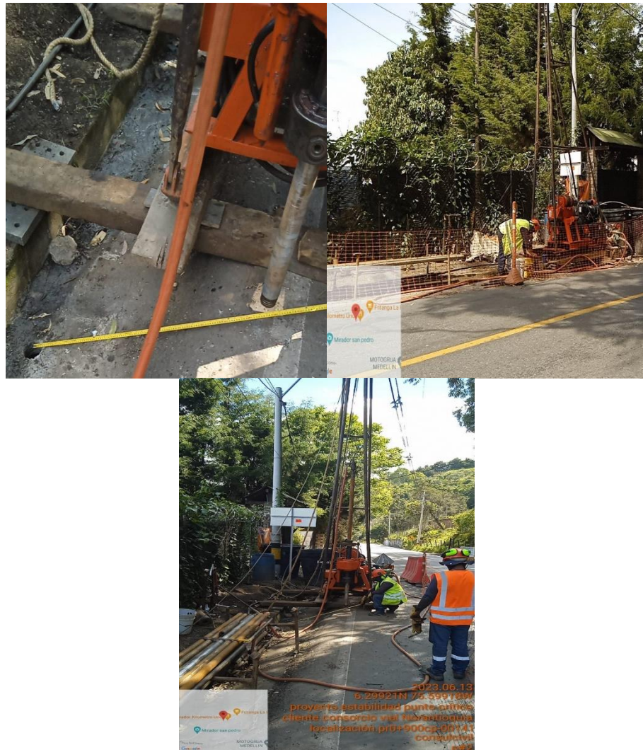
Fotografía 13. Ejecución Sondeo P2.
