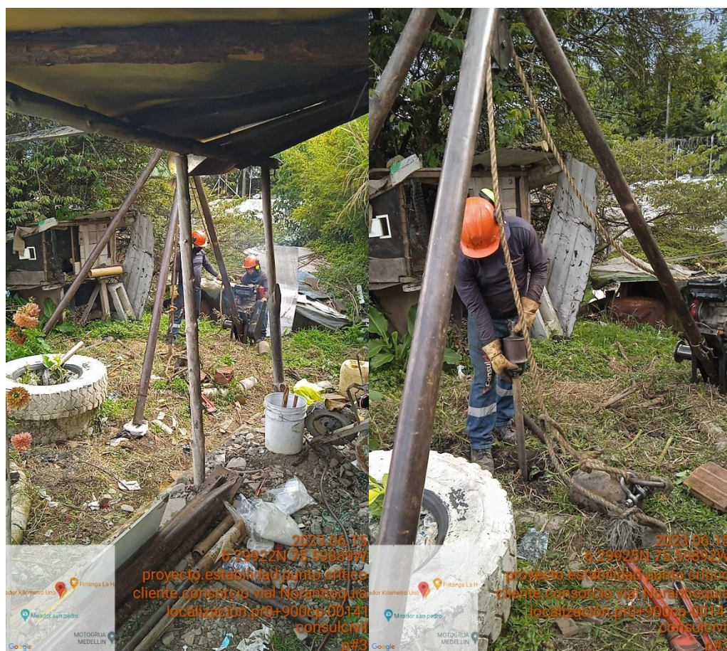
Fotografía 15. Ejecución Sondeo P3.
