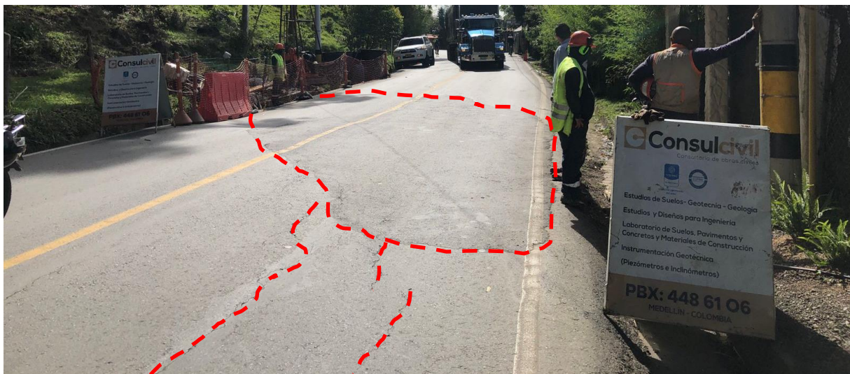
Figura 22. Agrietamientos evidenciados en la zona de interés.
