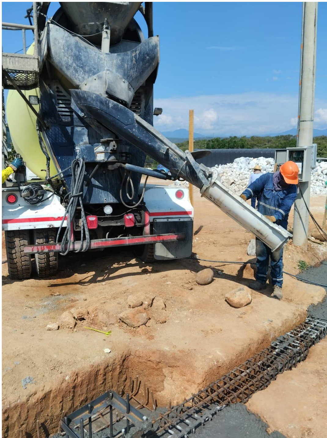
Ilustración 6. Vaciado de concreto. Fuente Autores.
