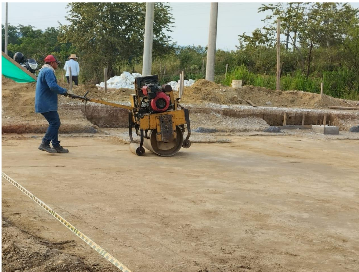
Ilustración 14. Compactación del terreno. Fuente Autores.
