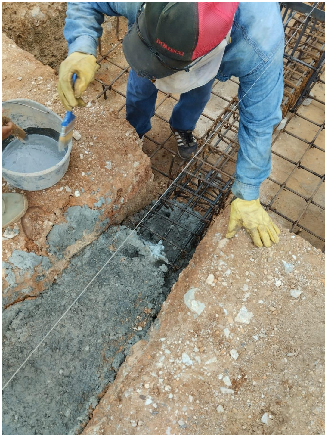
Ilustración 8. Aplicación sikadur para junta fría. Fuente Autores.
