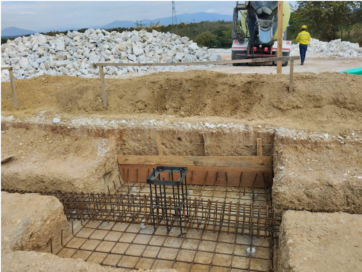
Ilustración 3. Armado de canastilla de anclajes. Fuente autores
