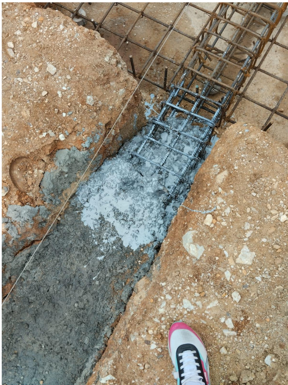
Ilustración 9. Sikadur en la junta fría. Fuente Autores.
