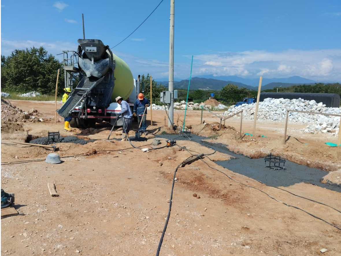
Ilustración 7. Vaciado y vibrado del concreto. Fuente Autores.
