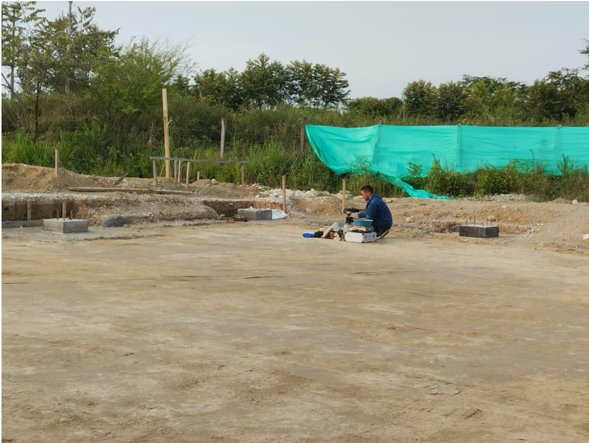
Ilustración 13. Toma de densidades para porcentaje de compactación. Fuente Autores.
