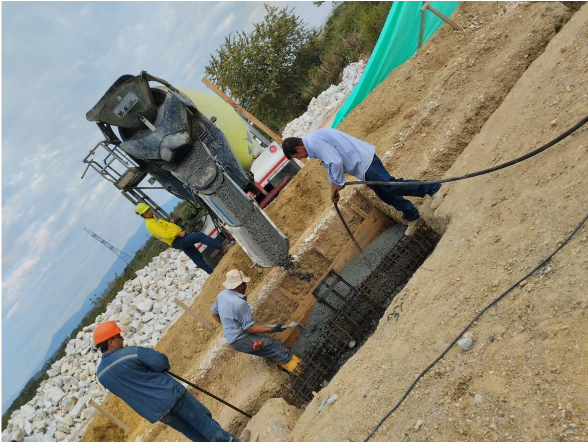
Ilustración 5. Vaciado de concreto 3500 PSI. Fuente autores.
