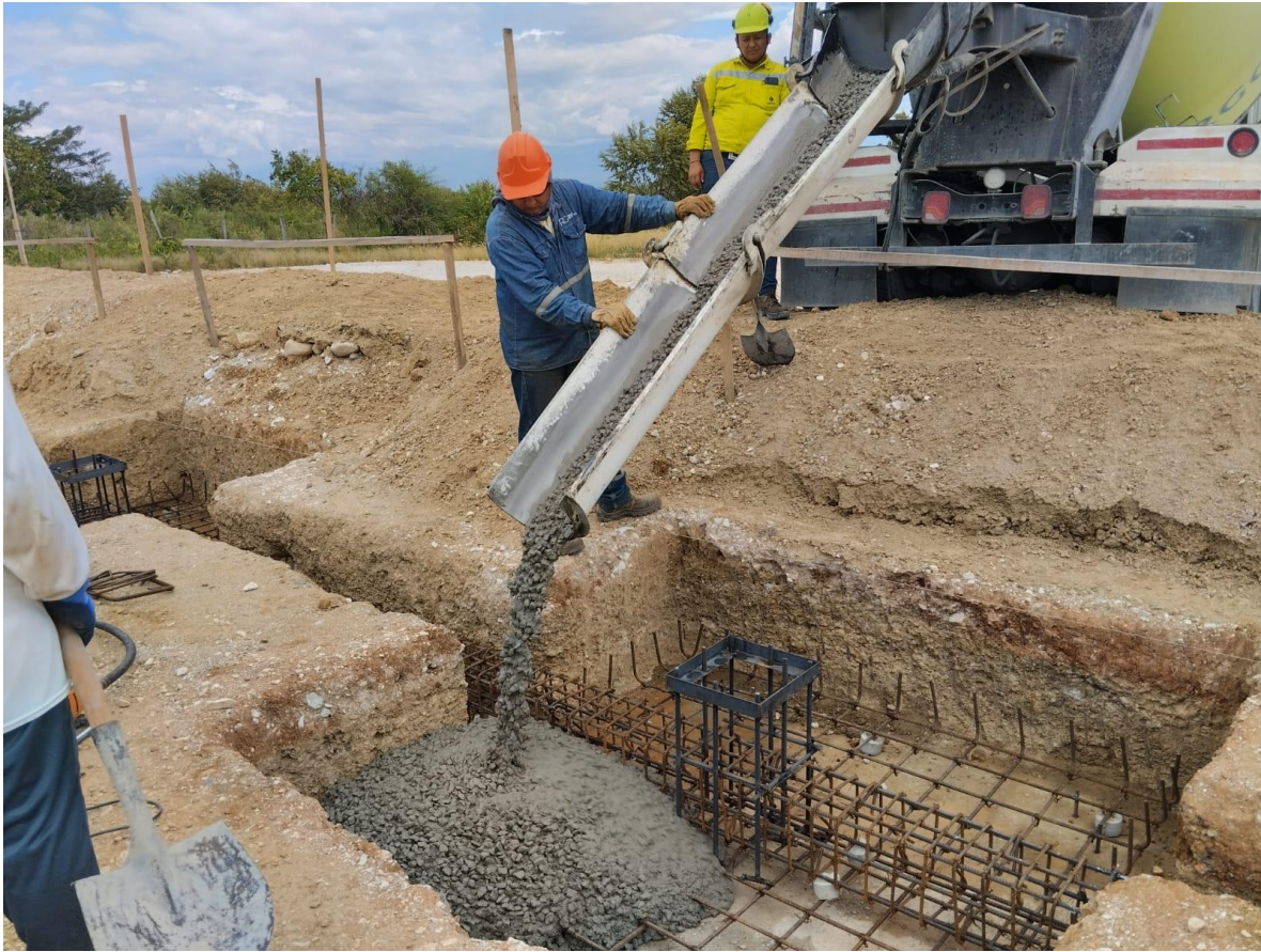
Ilustración 10. Vaciado de concreto. Fuente Autores.
