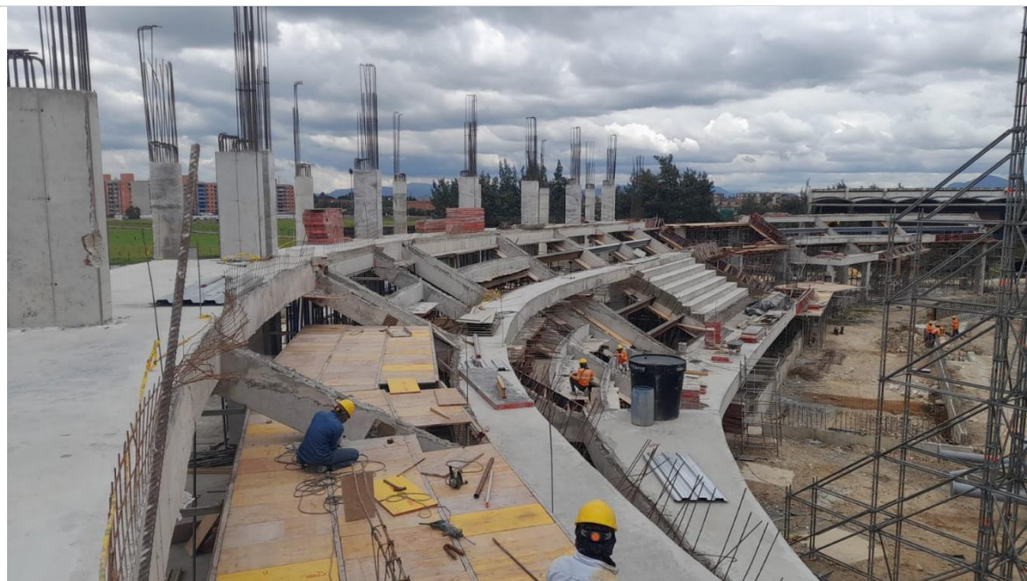
Ilustración 6. Encofrado graderías
