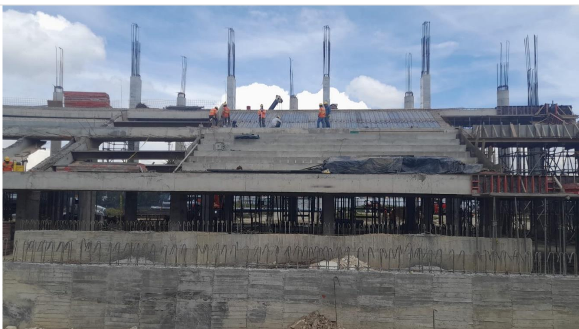
Ilustración 9. Taller – Armado de graderías
