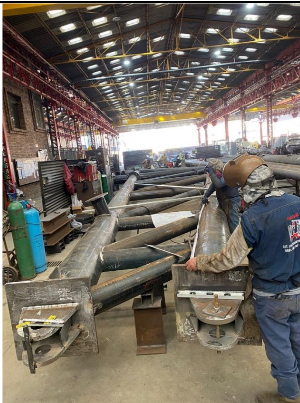
Ilustración 10. Taller CMA de fabricación estructura metálica
