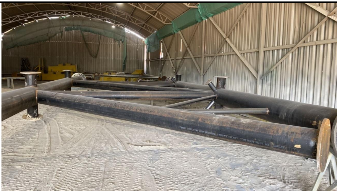
Ilustración 12. Taller CMA de fabricación estructura metálica
