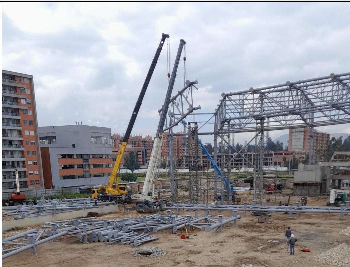
Ilustración 18. Izaje Fase 3 estructura metálica
