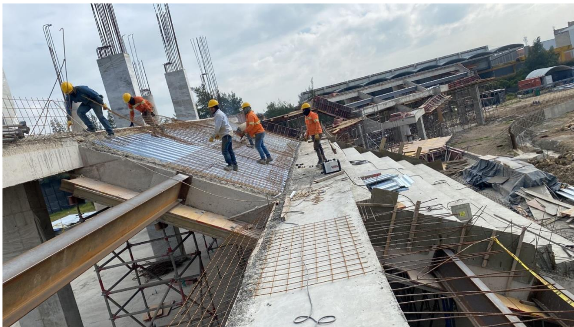
Ilustración 8. Armado de graderías
