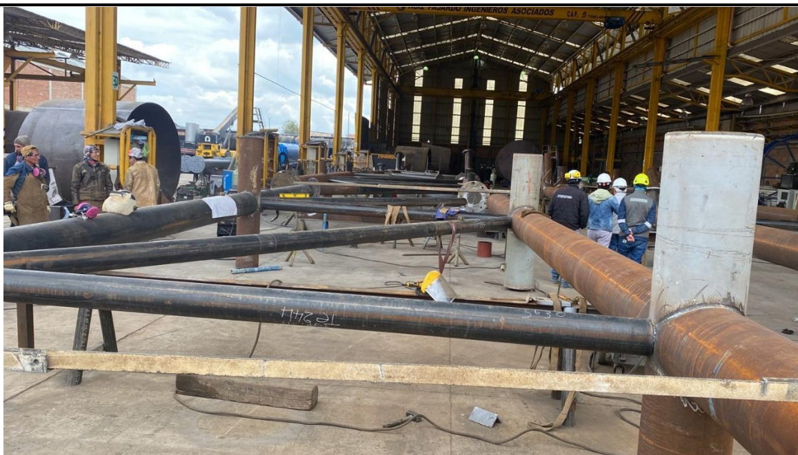
Ilustración 16. Taller RYF de fabricación estructura metálica
