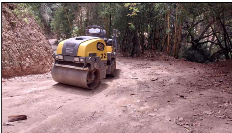
Conformación de calzada y compactación de la rasante.
