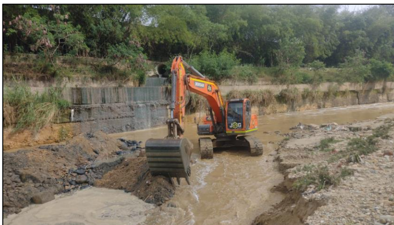
Canalización del cause del rio de oro en el sector de centro abastos
