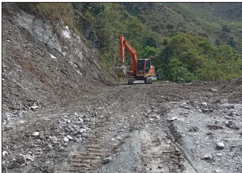
Retiro de material proveniente de los deslizamientos que afectaba el tránsito vehicular.
