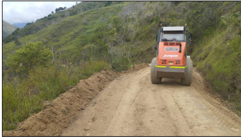
Compactación de rasante
