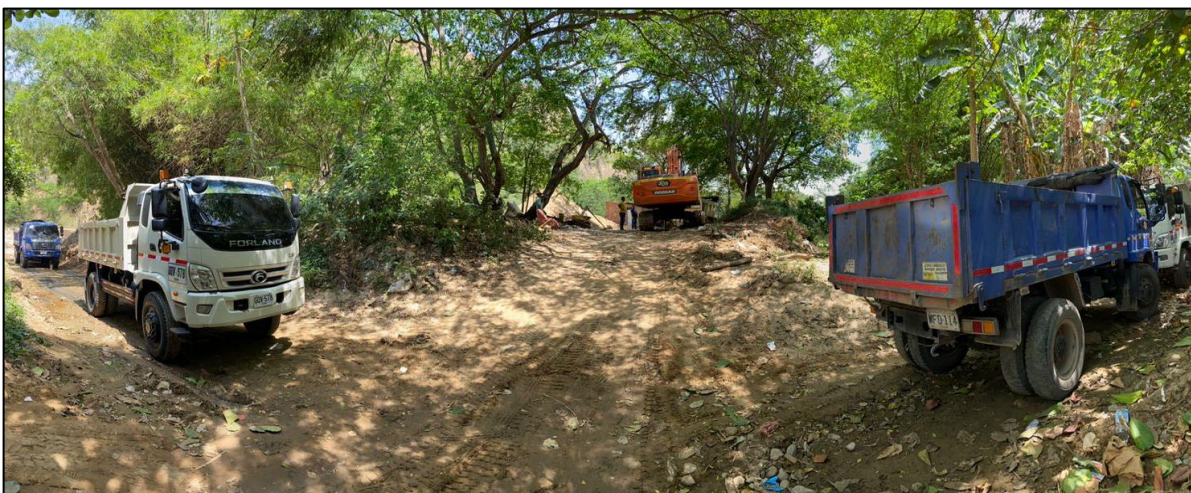
Excavación y dragado del cauce del río
