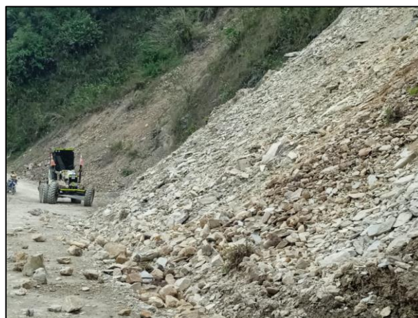
Conformación y compactación de calzada en zonas intervenidas
