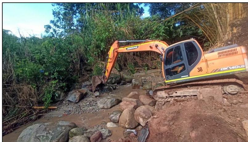
Trabajos en el cauce de río para recuperación de área y aumento de capacidad hidráulica
