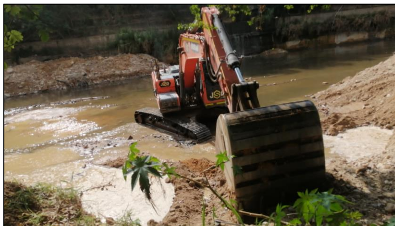
Conformación de material para la protección del muro lateral existente
