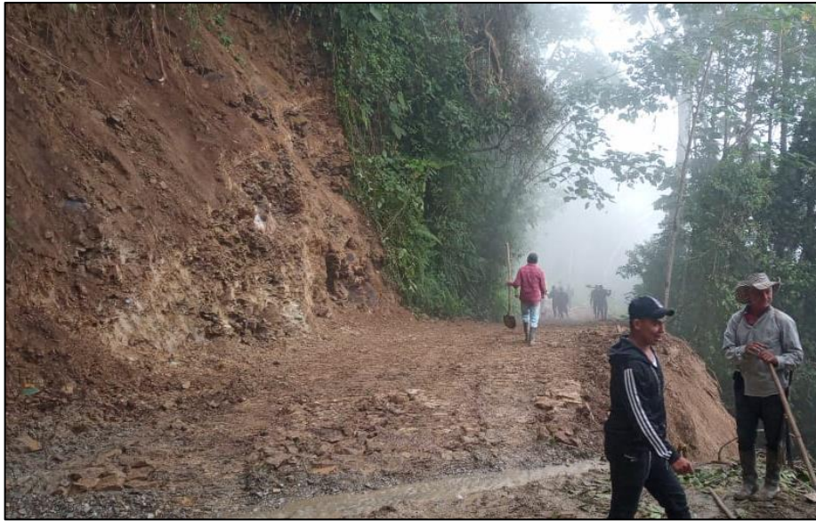
Se realiza el retiro de material proveniente del movimiento de tierra del talud.
