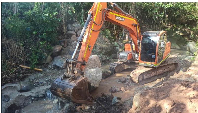
Limpieza y remoción de material rocoso de gran dimensión
