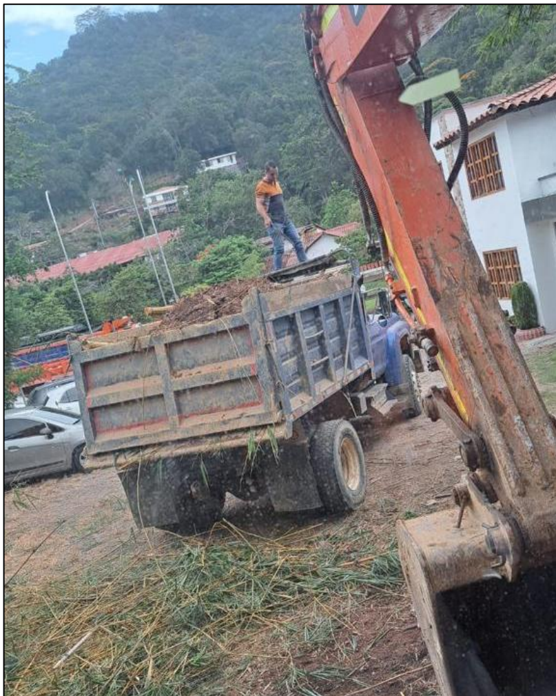
Retro de material sobrante de la limpieza
