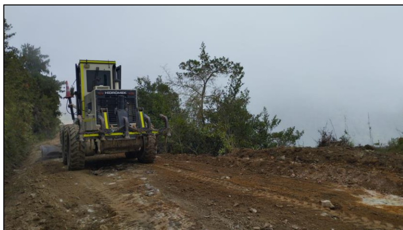
Limpieza de vía y conformación de banca principal de surata a mohan
