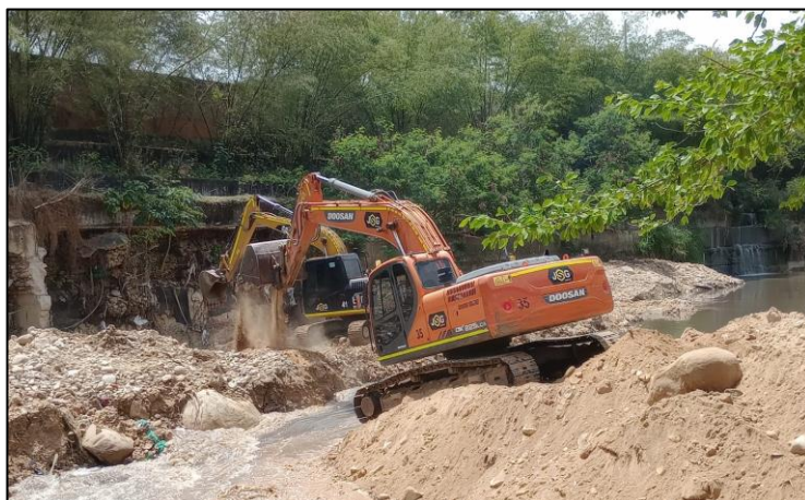
Conformación de barrera de protección para muro de gavión existente
