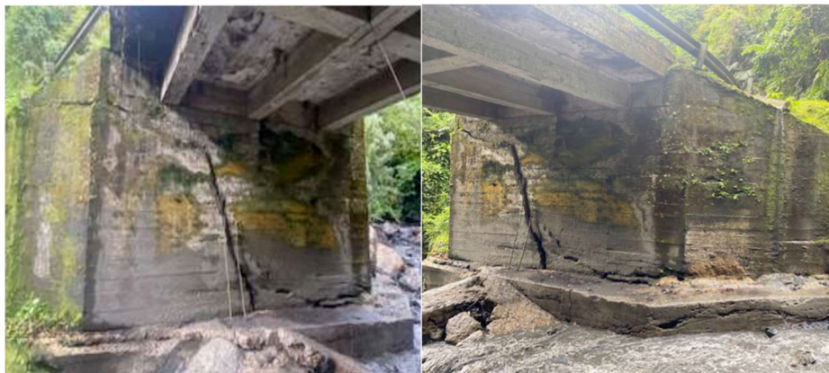
Foto No. 7: PC PR01+230 Ruta 6007 (imagen propia)
