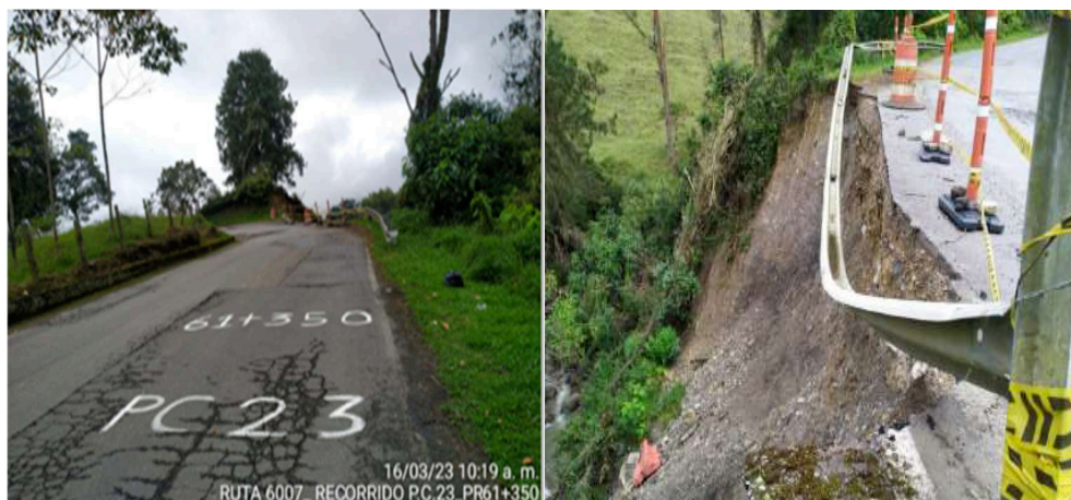
Foto No. 10: PC PR61+325 Ruta 6007 (imagen propia)
