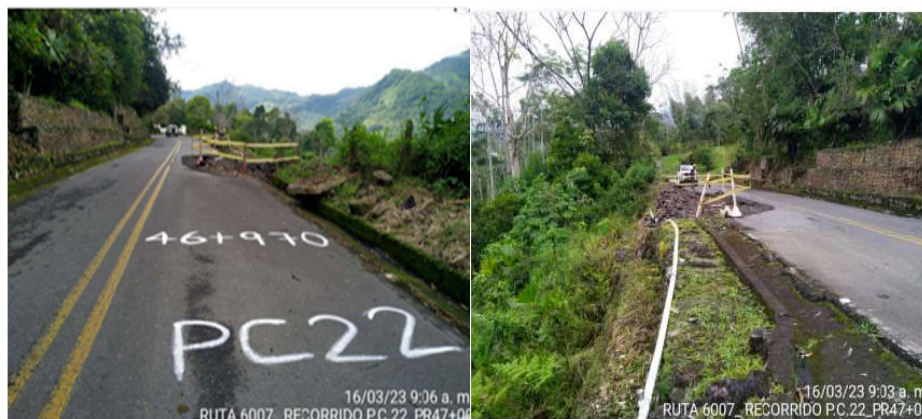
Foto No. 9: PC PR46+970 Ruta 6007 (imagen propia)
