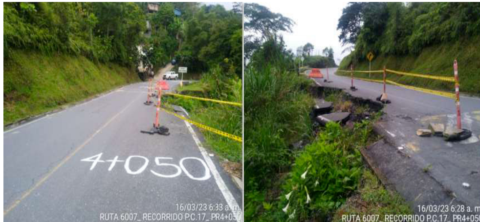
Foto No. 8: PC PR04+050 Ruta 6007 (imagen propia)
