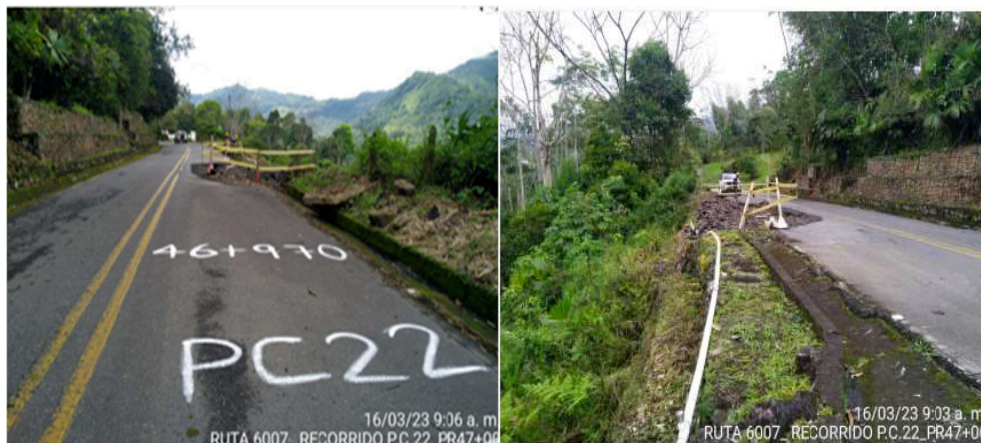
Foto No. 9: PC PR46+970 Ruta 6007 (imagen propia)
