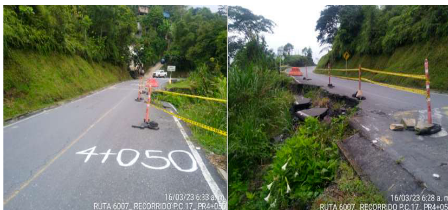
Foto No. 8: PC PR04+050 Ruta 6007 (imagen propia)
