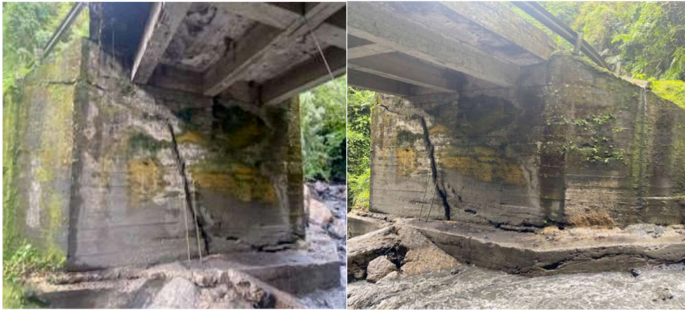
Foto No. 7: PC PR01+230 Ruta 6007 (imagen propia)
