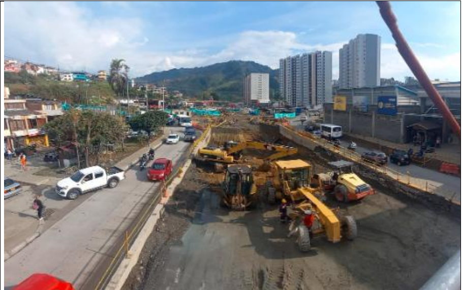
Excavación deprimido Cámbulos
