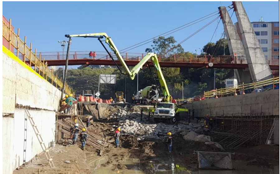
Fundición de pantallas y excavación Cambulos
