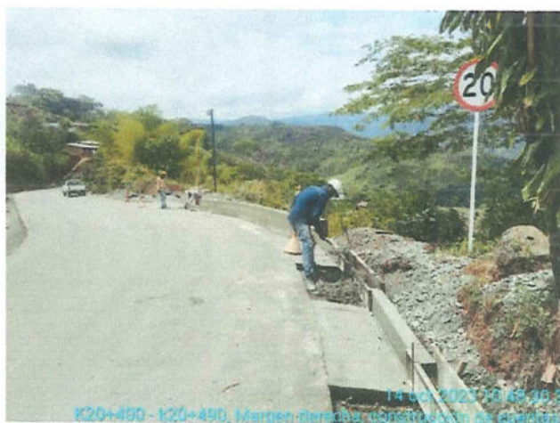
CUNETA DE CONCRETO CLASE D (21 MPa) VACIADA IN SITU.
