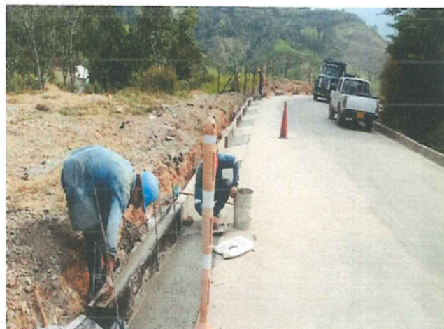
CUNETA DE CONCRETO CLASE D (21 MPa) VACIADA IN SITU.
