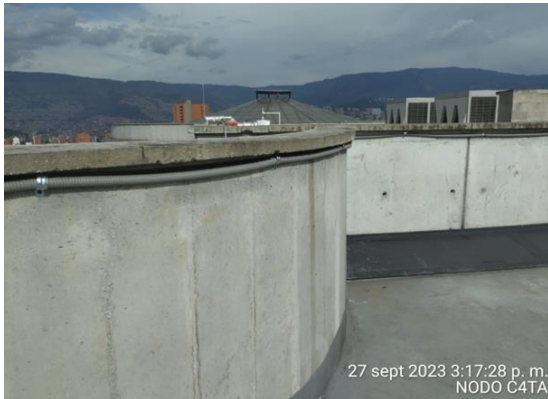
Instalación de FO
