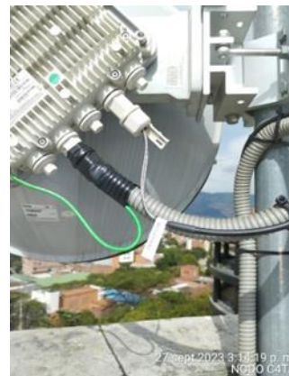
Instalación de FO
