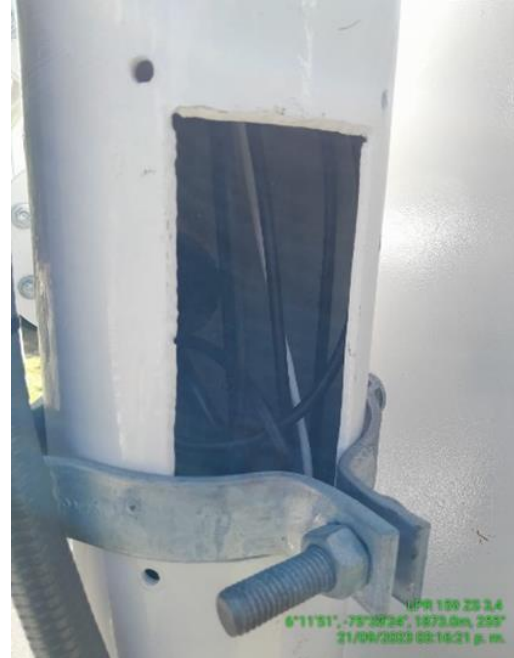
Instalación de la tapa
