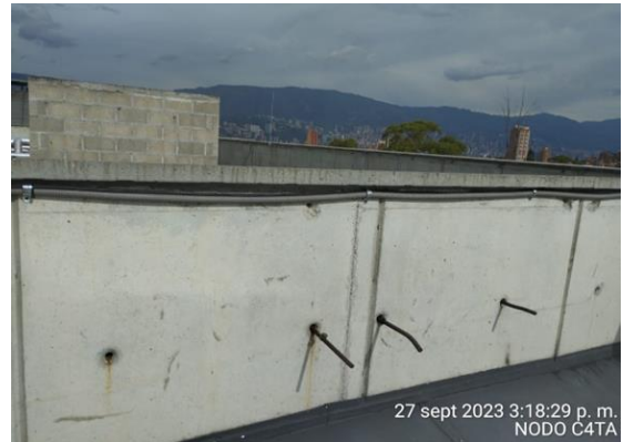
Instalación de FO
