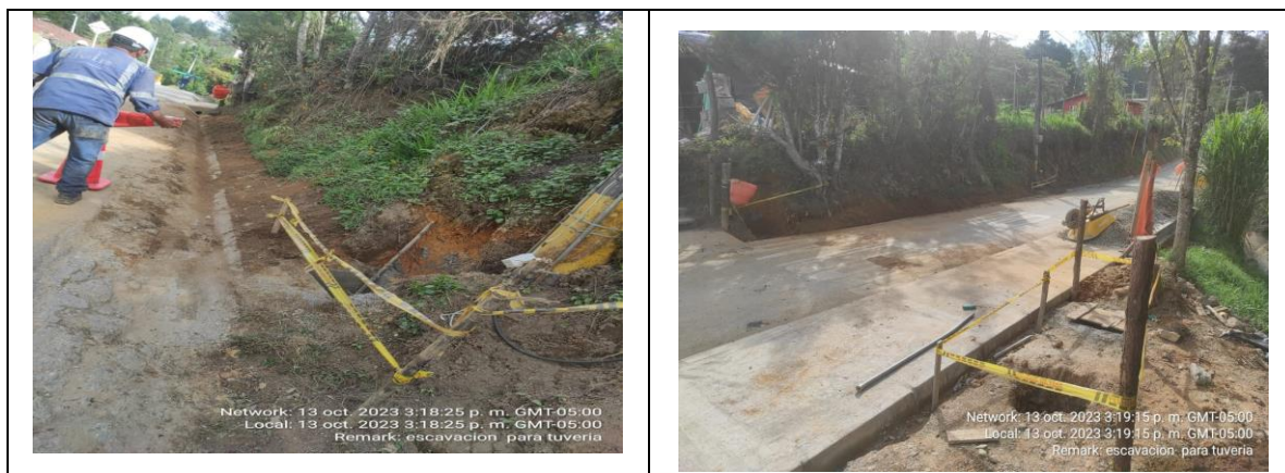
Imagen 3. ID LPR 194 Excavación de terreno para canalización, construcción de cajas y pedestal.
