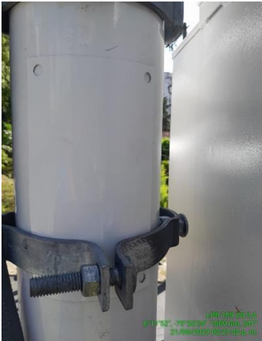
Instalación de la tapa
