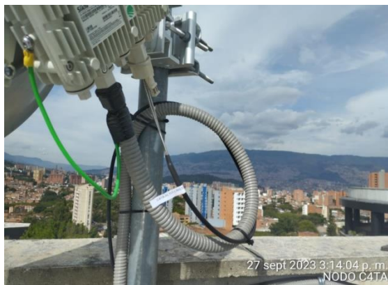
Instalación de FO
