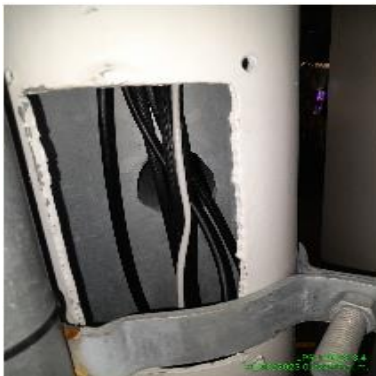
Ilustración 6 – Instalación de tapas laterales (Antes)
