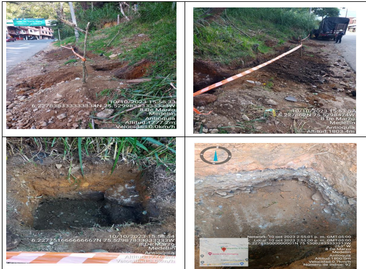
Imagen 3. ID LPR 194 Excavación de terreno para canalización, construcción de cajas y pedestal.
