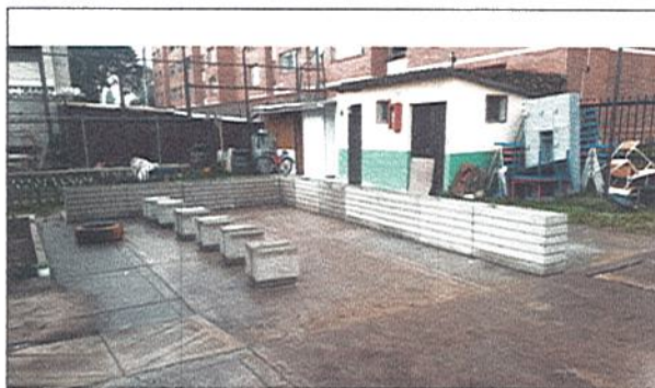
INSTALACION DE MATERAS Y BANCAS EN CONCRETO
