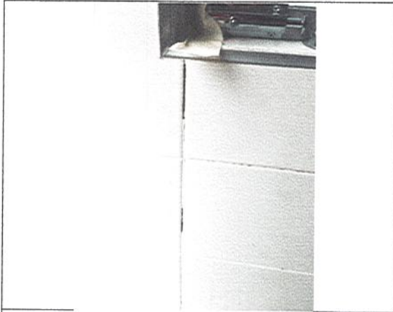
ARREGLO DE BOQUILLA EN MUROS
