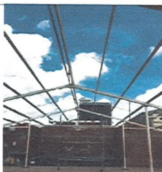
DESMONTE CUBIERTA EN ASBESTO CEMENTO-SALON MULTIPLE
