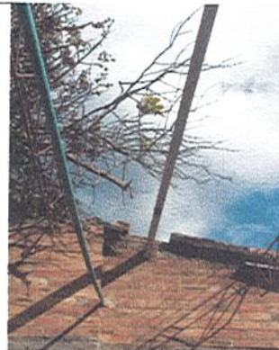
INSTALACION DE PLATINAS Y PERFILES DE REFORZAMIENTO
