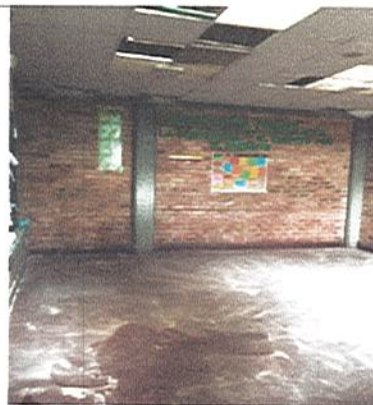
DESMONTE DE LAMPARAS EXISTENTES
