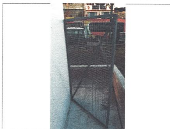
CORTE E INSTALACION DE REJA EXTERIOR
