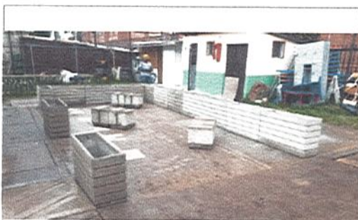
INSTALACION DE MATERAS Y BANCAS EN CONCRETO
