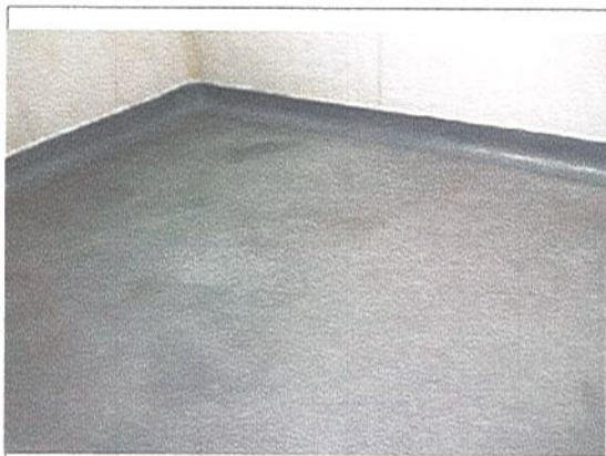
APLICACIÓN DE MATERIAL IMPERMEABILIZANTE-ARREGLOS- CUARTOS FRIOS
