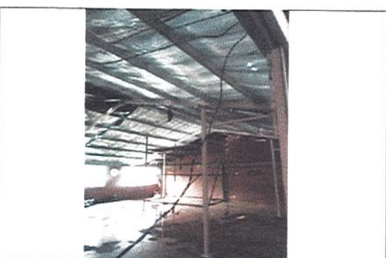
CUBRIMIENTO DE ESTRUCTURA CON PLASTICO
