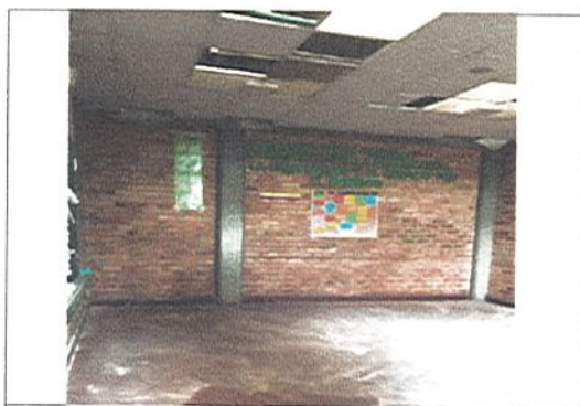
DESMONTE CIELO RASO
