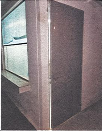
INSTALACION PUERTA- TIENDA ESCOLAR
