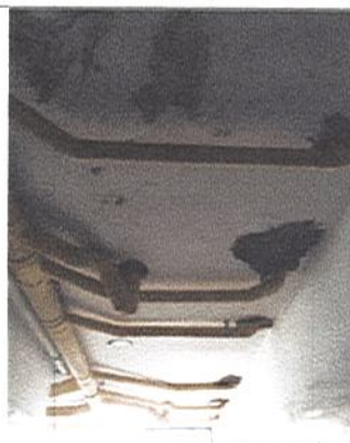
INSTALACION DE TUBERIA HIDROSANITARIA EN PVC
