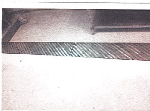
INSTALACION DE MARCO PARA REJILLA DE CARCAMO
