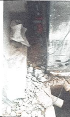
DEMOLICION DE ENCHAPE PISO
