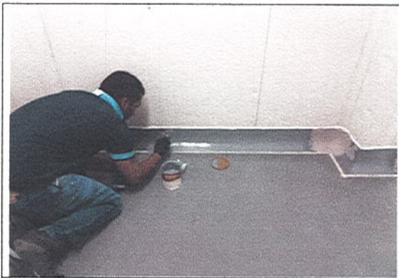
IMPERMEABILIZACION CUARTOS FRIOS
