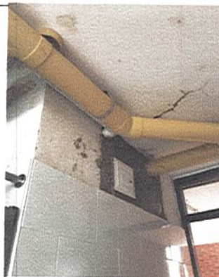
INSTALACION DE REGISTRO NUEVO Y ENCHAPE PARED
