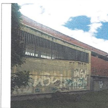
VISTA EXTERIOR DE CERRAMIENTO
