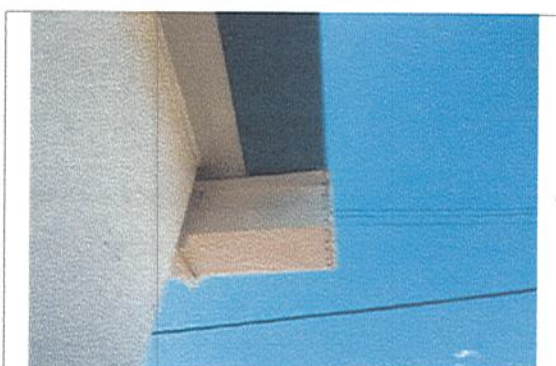
CORTE Y PINTURA DE CAÑAL
