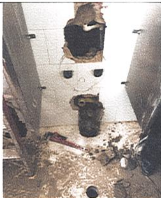
REPOSICION DE TUBERIA HIDROSANITARIA EN PVC
