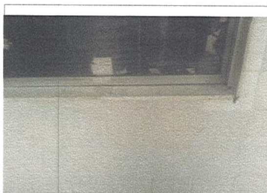
ARREGLO DE ENCHAPE DAÑADO-EXTERIOR COCINA
