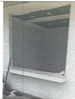
INSTALACION DE CIELO RASO EN SUPERBOARD
