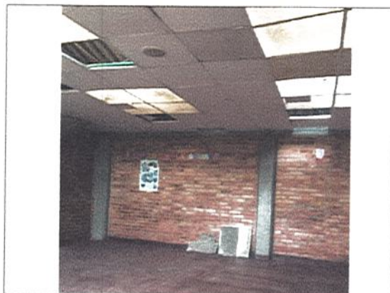
DESMONTE CIELO RASO
