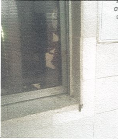
ARREGLO DE ENCHAPE DAÑADO-EXTERIOR COCINA
