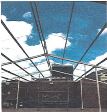
DESMONTE CUBIERTA EN ASBESTO CEMENTO-SALON MULTIPLE
