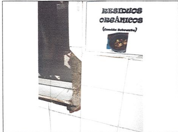
ENCHAPE EXTERIOR DAÑADO
