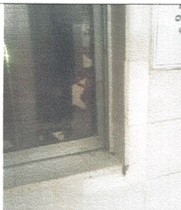
ARREGLO DE ENCHAPE DAÑADO-EXTERIOR COCINA
