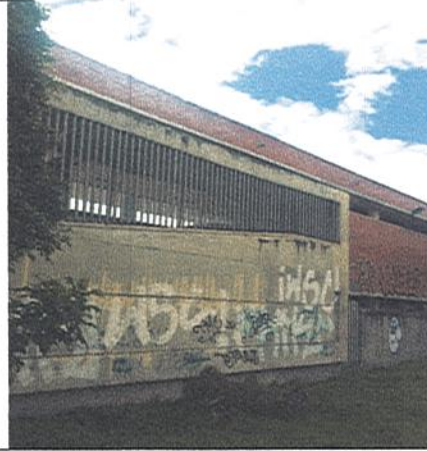
VISTA EXTERIOR DE CERRAMIENTO
