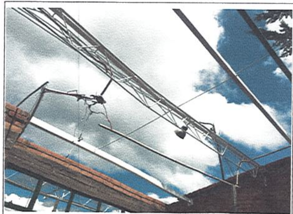
PINTURA DE PERFILERIA METALICA PARA REFORZAMIENTO ESTRUCTURAL
