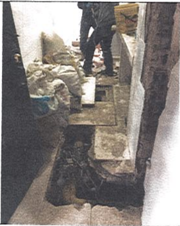
INSTALACION DE TUBERIA HIDROSANITARIA EN PVC
