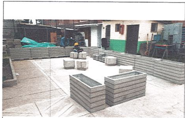
FINALIZA REUBICACION DE MATERAS
