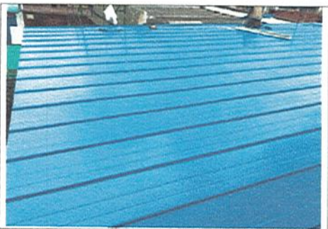
FINALIZACION DE INSTALACION DE CUBIERTA
