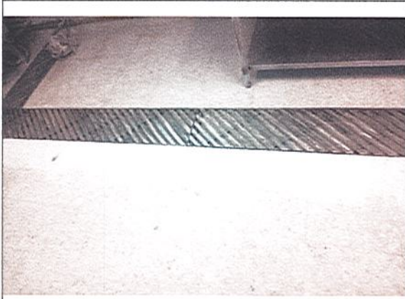
INSTALACION DE MARCO PARA REJILLA DE CARCAMO
