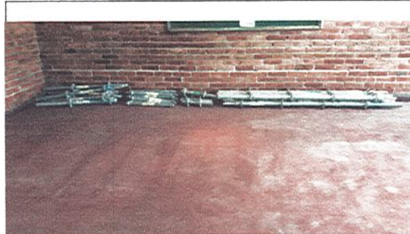
INGRESO DE MATERIAL DE REFUERZO ESTRUCTURAL
