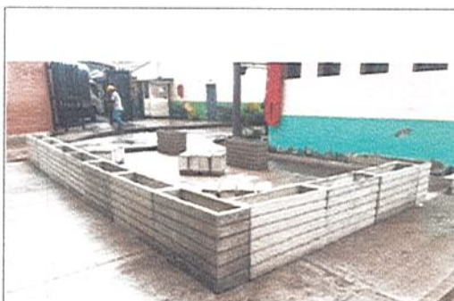
INSTALACION DE MATERAS Y BANCAS EN CONCRETO
