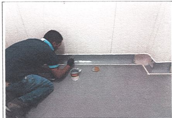
APLICACION DE MATERIAL IMPERMEABILIZANTE EN MEDIAS CAÑAS
