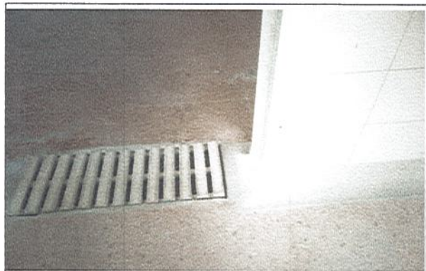
INSTALACION DE REJILLAS EXISTENTES
