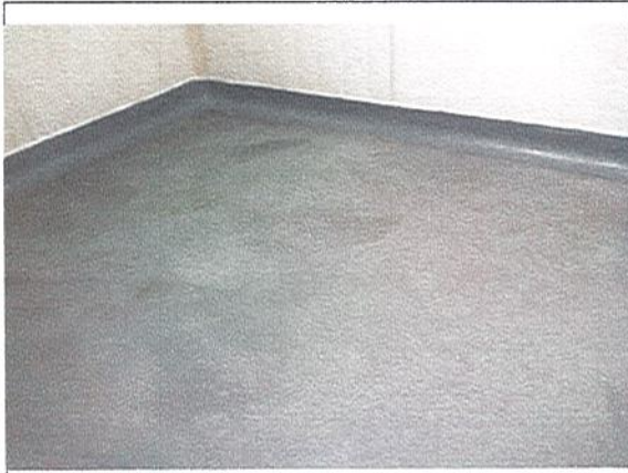
APLICACIÓN DE MATERIAL IMPERMEABILIZANTE-ARREGLOS- CUARTOS FRIOS
