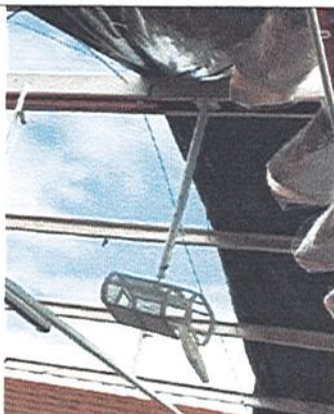
MONTAJE DE ESTRUCTURA DE REFORZAMIENTO
