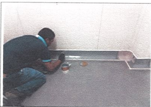
IMPERMEABILIZACION CUARTOS FRIOS
