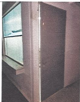
INSTALACION PUERTA- TIENDA ESCOLAR
