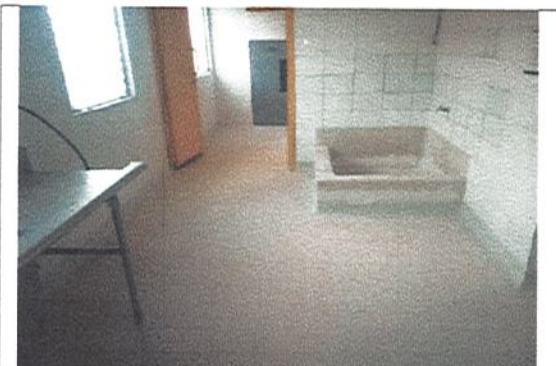
FINALIZACION DE ACTIVIDADES AREA DE LAVADO
