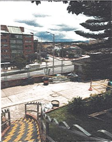
INGRESO DE MATERIAL Y EQUIPOS
