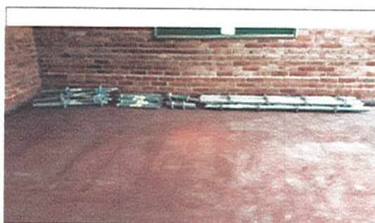
INGRESO DE MATERIAL DE REFUERZO ESTRUCTURAL
