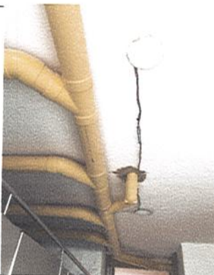
INSTALACION DE TUBERIA HIDROSANITARIA EN PVC
