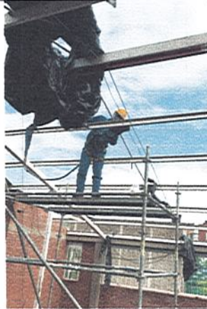
MONTAJE DE ESTRUCTURA DE REFORZAMIENTO
