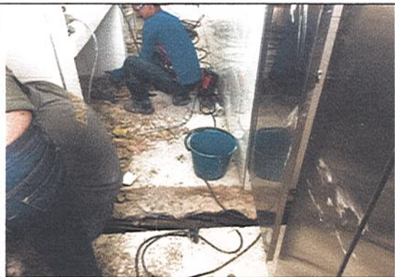
DESMONTE DE TUBERIA HIDROSANITARIA GALVANIZADA
