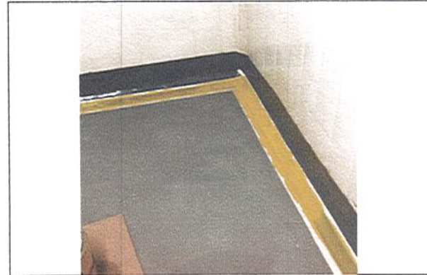
PINTURA MEDIAS CAÑAS Y CINTA DE SEGURIDAD
