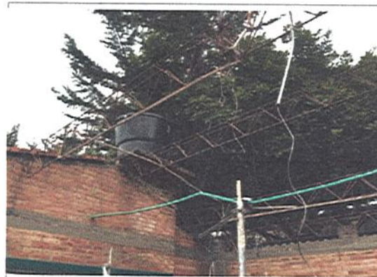
DESMONTE DE CUBIERTA EN ASBESTO CEMENTO
