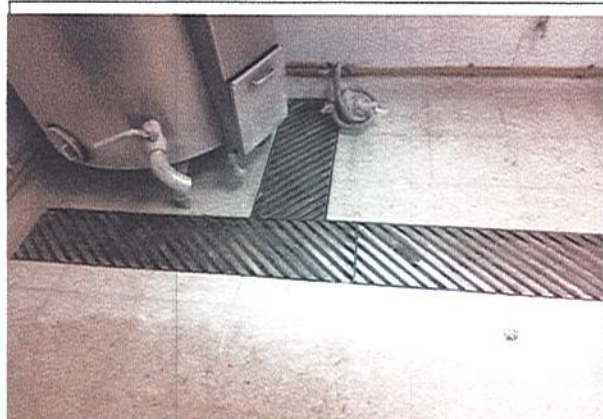
INSTALACION DE MARCO PARA REJILLA DE CARCAMO
