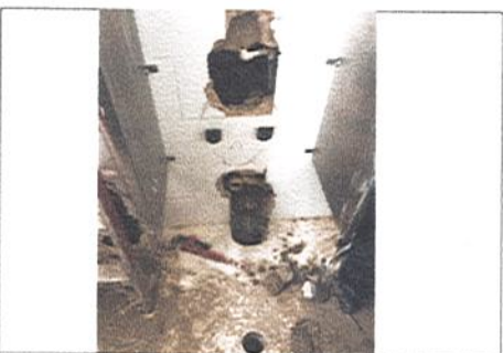
REPOSICION DE TUBERIA HIDROSANITARIA EN PVC
