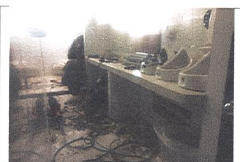
DEMOLICION DE ENCHAPE PARED
