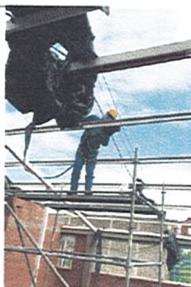
MONTAJE DE ESTRUCTURA DE REFORZAMIENTO
