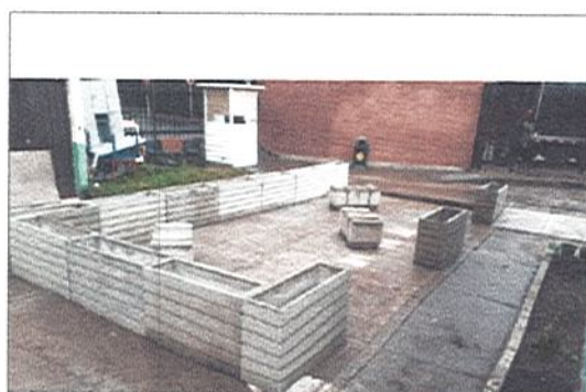
INSTALACION DE MATERAS Y BANCAS EN CONCRETO
