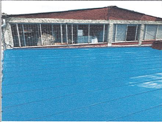
FINALIZA INSTALACION DE TEJA TIPO SANDWICH
