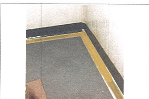
PINTURA MEDIAS CAÑAS Y CINTA DE SEGURIDAD
