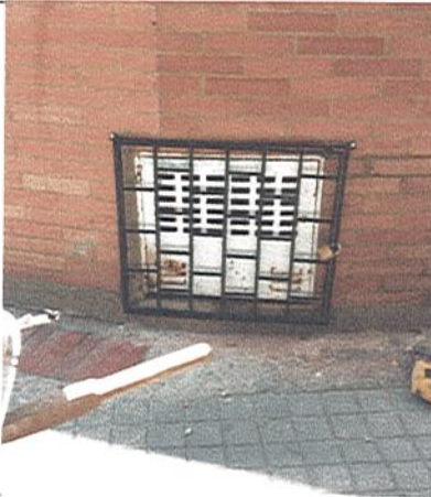
INSTALACION DE REJILLA NUEVA
