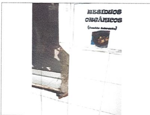
ENCHAPE EXTERIOR DAÑADO
