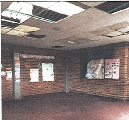
DESMONTE DE CIELO RASO
