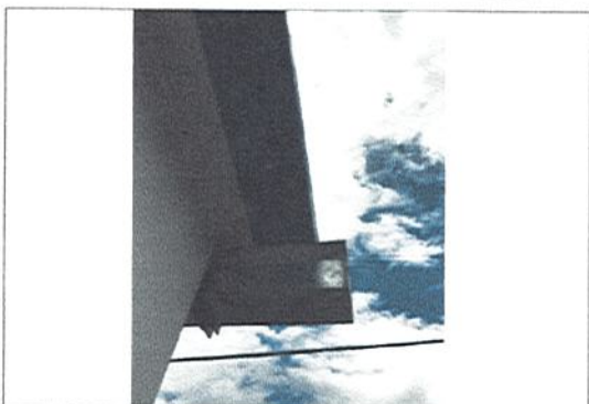
INSTALACION DE CAÑAL
