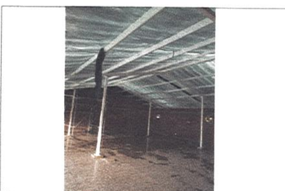
CUBRIMIENTO DE ESTRUCTURA CON PLASTICO
