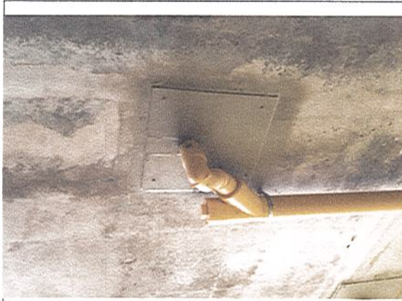
INSTALACION DE TAPAS EN DRYWALL
