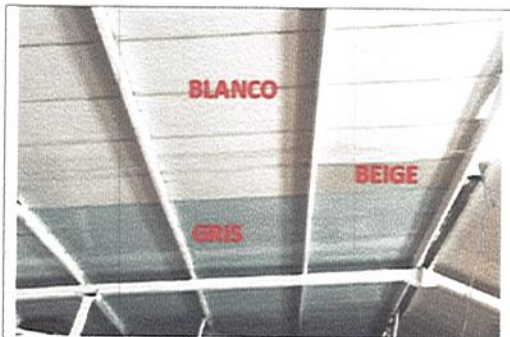
SE EVIDENCIA TRES TIPOS DE TONALIDADES AL INTERIOR DE LA CUBIERTA
