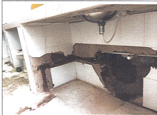
DESMONTE DE TUBERIA DE SUMINISTRO
