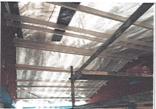
FINALIZA REFORZAMIENTO ESTRCUTURAL
