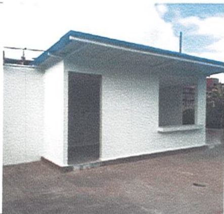
CASETA TIENDA ESCOLAR Y CUARTO DE REFRIGERIOS
