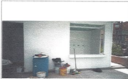
CASETA TIENDA ESCOLAR Y CUARTO DE REFRIGERIOS
