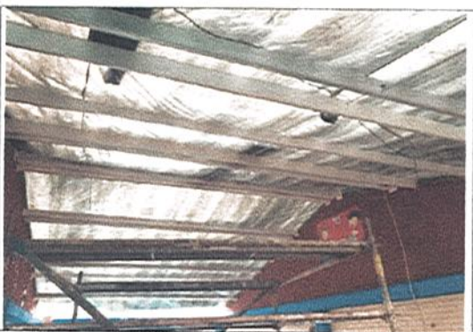
FINALIZA REFORZAMIENTO ESTRCUTURAL
