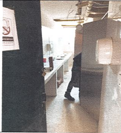
TUBERIA HIDROSANITARIA A LA VISTA-2DO PISO
