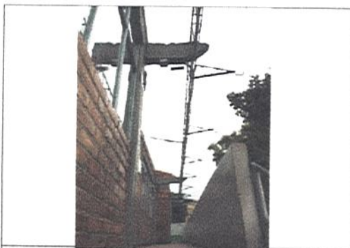
DESMONTE CUBIERTA DE ASBESTO CEMENTO
