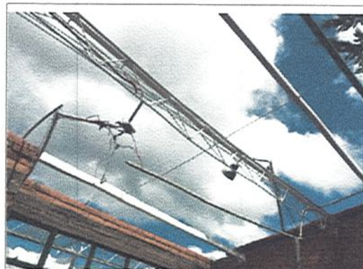
PINTURA DE PERFILERIA METALICA PARA REFORZAMIENTO ESTRUCTURAL
