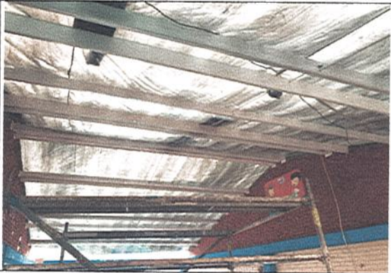
FINALIZA REFORZAMIENTO ESTRCUTURAL
