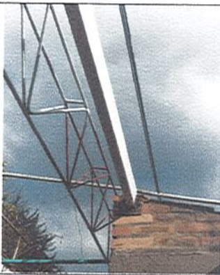
REFORZAMIENTO ESTRUCTURA DE CERCHAS EXISTENTES
