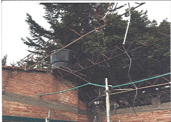
DESMONTE DE CUBIERTA EN ASBESTO CEMENTO
