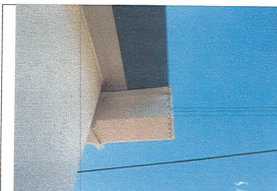
CORTE Y PINTURA DE CANAL
