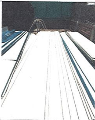
INGRESO DE TEJAS TIPO SANDWICH
