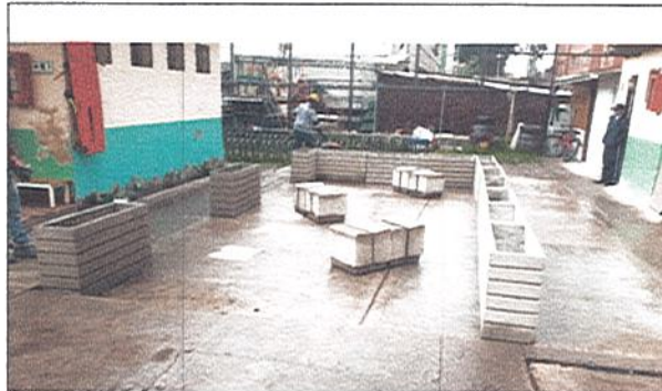
INSTALACION DE MATERAS Y BANCAS EN CONCRETO
