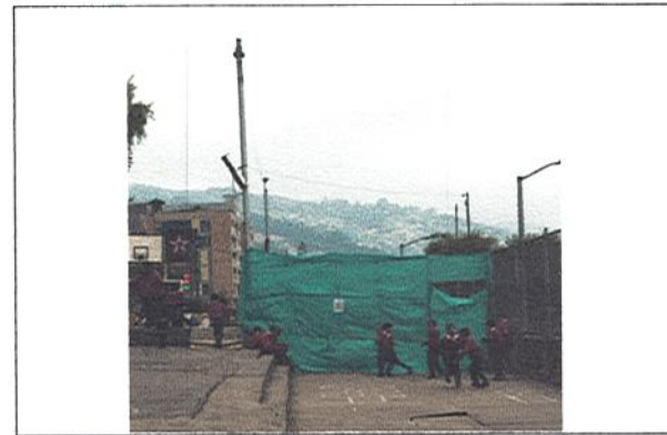
CERRAMIENTO ZONA DE ACOPIO
