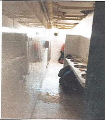
TUBERIA HIDROSANITARIA A LA VISTA-2DO PISO
