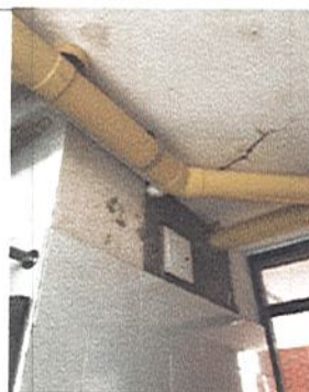
INSTALACION DE REGISTRO NUEVO Y ENCHAPE PARED
