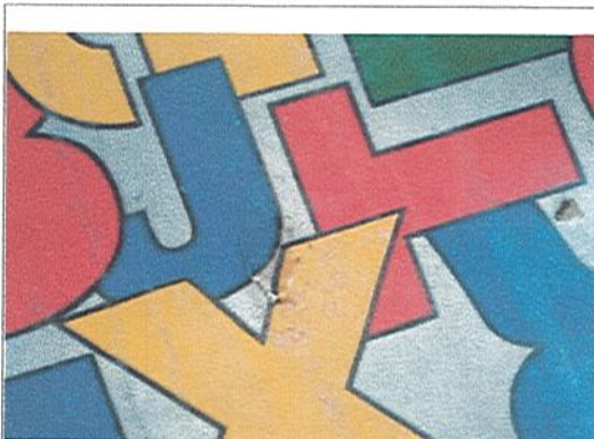
TAPETE DAÑADO DURANTE LA INTERVECION
