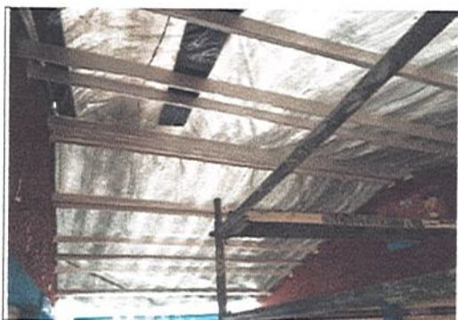
FINALIZA REFORZAMIENTO ESTRCUTURAL
