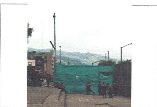
CERRAMIENTO ZONA DE ACOPIO
