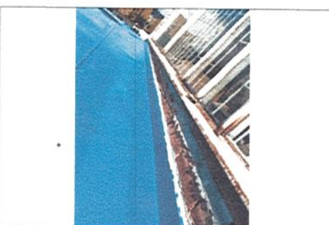
INSTALACION DE FLANCHE
