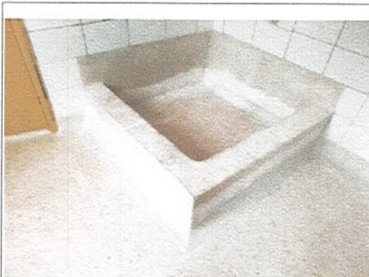
RESAÑE E IMPERMEABILIZACION DE POCETA
