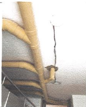
INSTALACION DE TUBERIA HIDROSANITARIA EN PVC
