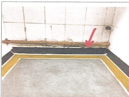
RETOQUE PINTURA MEDIAS CAÑAS Y CINTA DE SEGURIDAD
