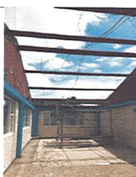
DESMONTE CUBIERTA EN ASBESTO CEMENTO-BIBLIOTECA
