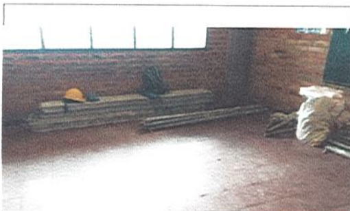
INGRESO DE MATERIAL DE REFUERZO ESTRUCTURAL
