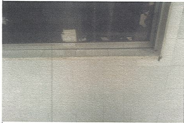
ARREGLO DE ENCHAPE DAÑADO-EXTERIOR COCINA
