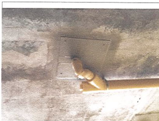
INSTALACION DE TAPAS EN DRYWALL
