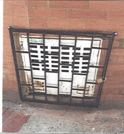
INSTALACION DE REJILLA NUEVA
