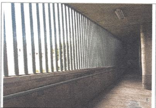
FINALIZA RASPAJE DE MUROS MANCHADOS
