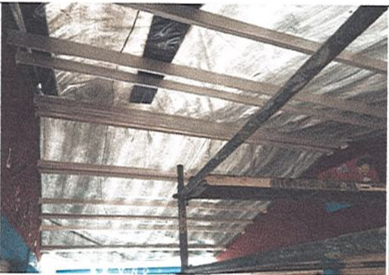
FINALIZA REFORZAMIENTO ESTRCUTURAL
