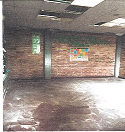
DESMONTE DE LAMPARAS EXISTENTES
