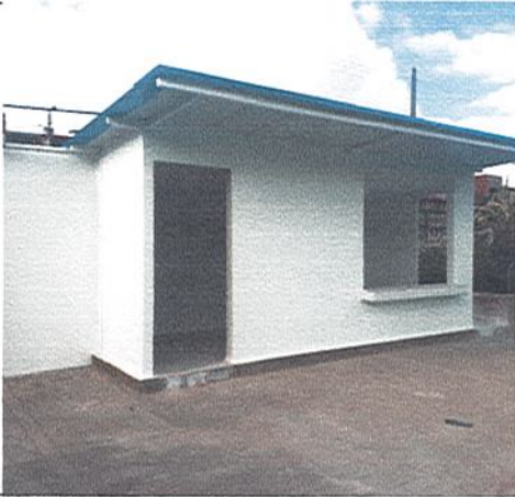
CASETA TIENDA ESCOLAR Y CUARTO DE REFRIGERIOS
