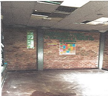
DESMONTE CIELO RASO
