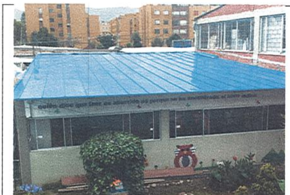
VISTA SUPERIOR DE CUBIERTA
