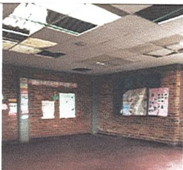
DESMONTE DE CIELO RASO
