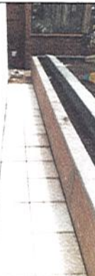
INSTALACION DE ENCHAFE PISO EXTERIOR
