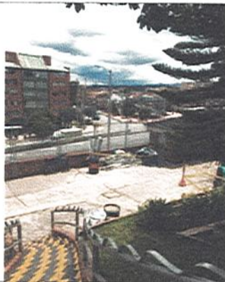
INGRESO DE MATERIAL Y EQUIPOS
