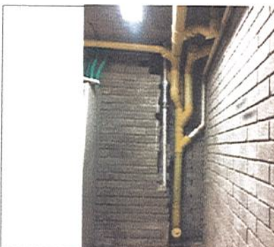
DEMOLICION MURO Y REPOSICION DE TUBERIA
