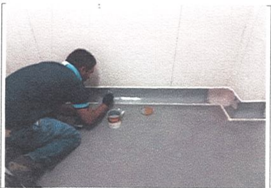
APLICACION DE MATERIAL IMPERMEABILIZANTE EN MEDIAS CAÑAS
