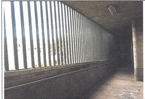
FINALIZA RASPAJE DE MUROS MANCHADOS
