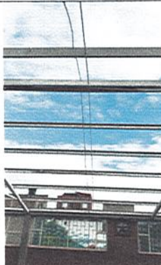
MONTAJE DE ESTRUCTURA DE REFORZAMIENTO
