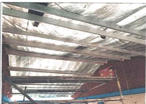
FINALIZA REFORZAMIENTO ESTRCUTURAL
