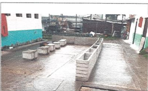
INSTALACION DE MATERAS Y BANCAS EN CONCRETO
