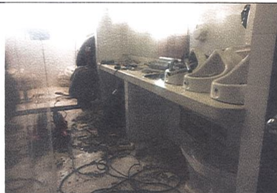
DEMOLICION DE ENCHAFE PARED
