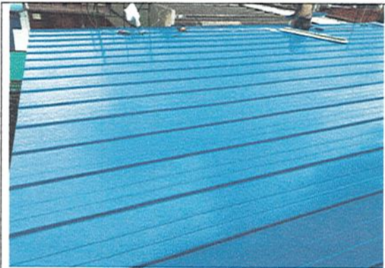
FINALIZACION DE INSTALACION DE CUBIERTA
