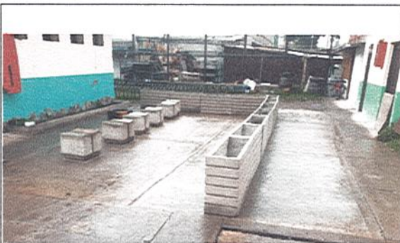
INSTALACION DE MATERAS Y BANCAS EN CONCRETO
