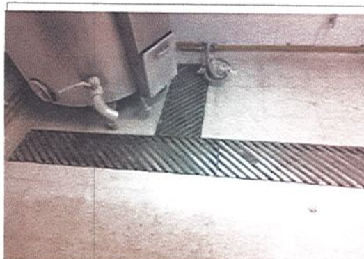
INSTALACION DE MARCO PARA REJILLA DE CARCAMO
