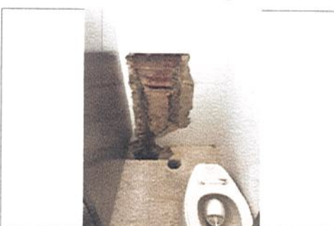
DESMONTE DE TUBERIA HIDROSANITARIA GALVANIZADA
