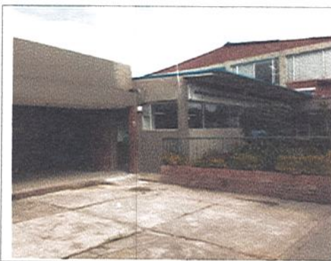
RETIRO DE ESCOMBROS Y MATERIAL DE OBRA
