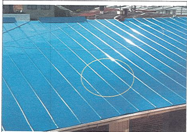
IRREGULARIDADES EN PARTE SUPERIOR DE LAS TEJAS
