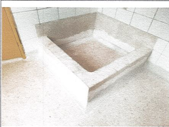
RESANE E IMPERMEABILIZACION DE POCETA
