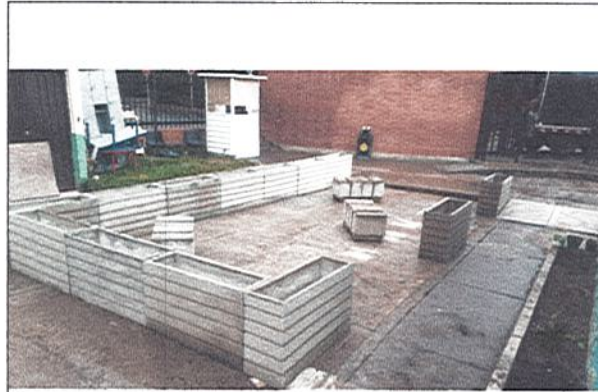
INSTALACION DE MATERAS Y BANCAS EN CONCRETO
