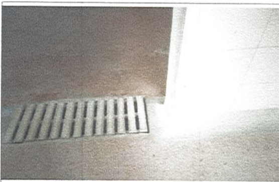
INSTALACION DE REJILLAS EXISTENTES
