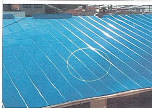
IRREGULARIDADES EN PARTE SUPERIOR DE LAS TEJAS
