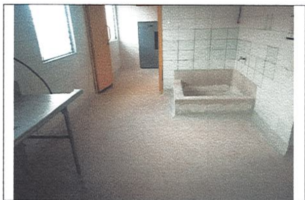
FINALIZACION DE ACTIVIDADES AREA DE LAVADO
