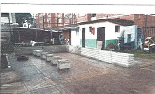
INSTALACION DE MATERAS Y BANCAS EN CONCRETO
