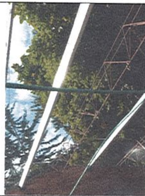
INSTALACION DE PLATINAS Y PERFILES DE REFORZAMIENTO
