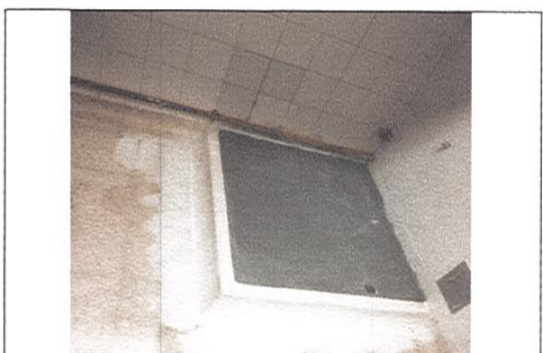
INSTALACION DE PISO IMPERMEABILIZANTE EN ZONA DE MARMITA
