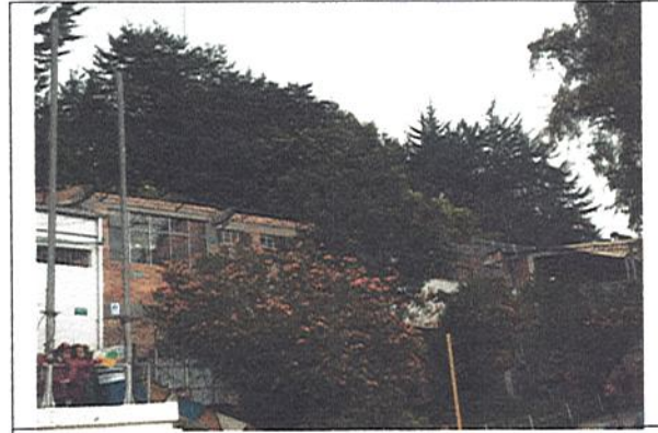
DESMONTE CUBIERTA DE ASBESTO CEMENTO
