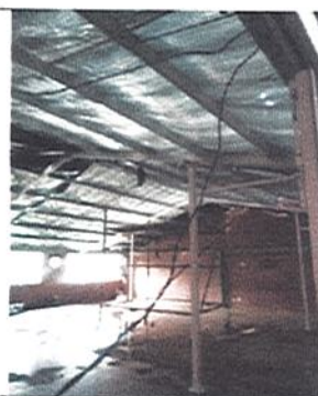
CUBRIMIENTO DE ESTRUCTURA CON PLASTICO
