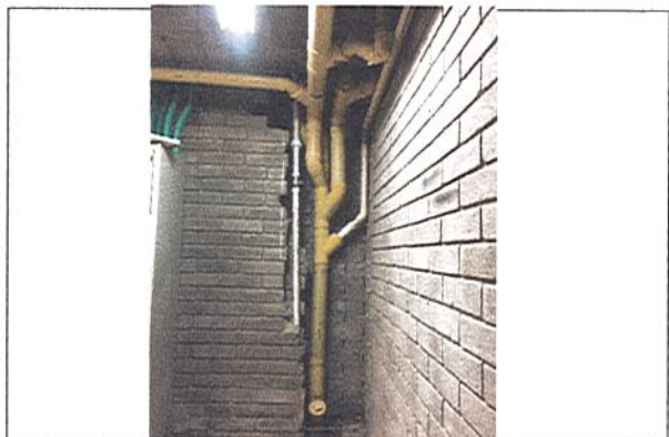
DEMOLICION MURO Y REPOSICION DE TUBERIA
