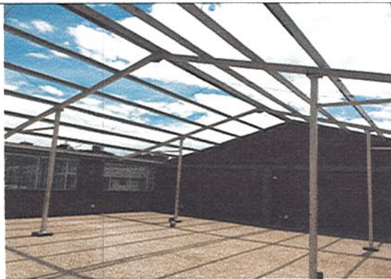
DESMONTE CUBIERTA EN ASBESTO CEMENTO-SALON MULTIPLE
