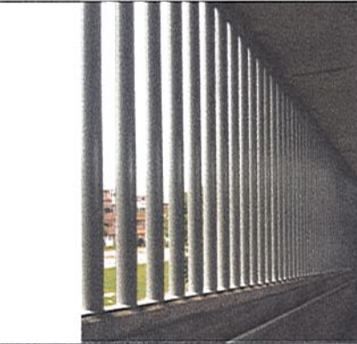
FINALIZA PINTURA DE TUBERIA
