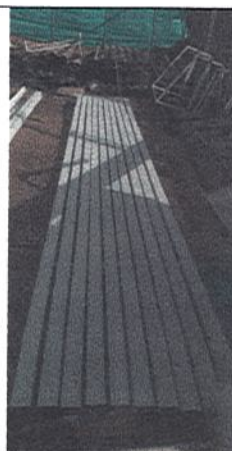
PINTURA DE PERFILERIA METALICA PARA REFORZAMIENTO ESTRUCTURAL
