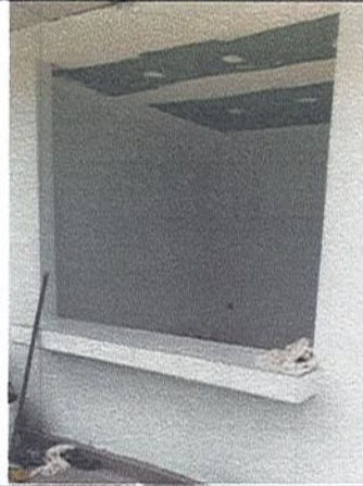
INSTALACION DE CIELO RASO EN SUPERBOARD
