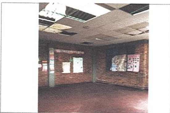
INICIO DESMONTE DE CIELO RASO
