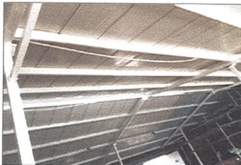
FINALIZA MONTAJE DE CUBIERTA TIPO SANDWICH
