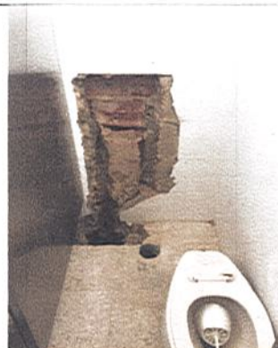
DESMONTE DE TUBERIA HIDROSANITARIA GALVANIZADA
