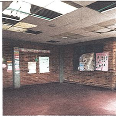
INICIO DESMONTE DE CIELO RASO
