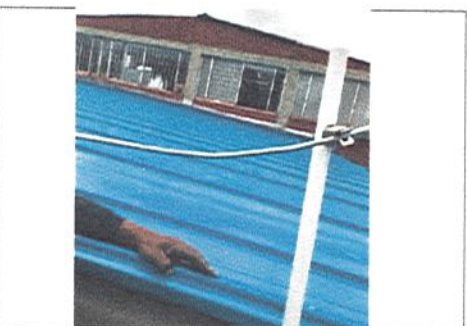
REMATES LATERALES DE TEJAS TIPO SANDWICH
