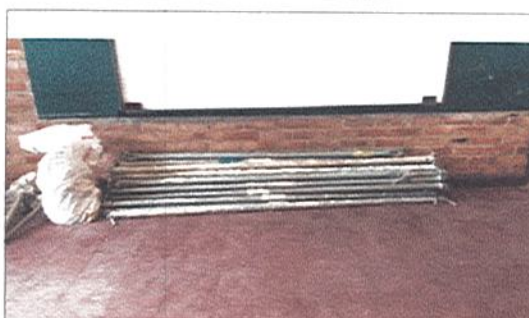
INGRESO DE MATERIAL DE REFUERZO ESTRUCTURAL
