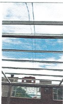
MONTAJE DE ESTRUCTURA DE REFORZAMIENTO
