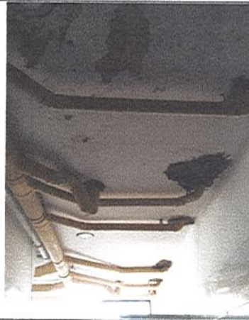
INSTALACION DE TUBERIA HIDROSANITARIA EN PVC
