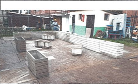
INSTALACION DE MATERAS Y BANCAS EN CONCRETO
