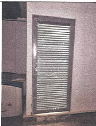
INSTALACION DE PUERTA-CUARTO DE REFRIGERIOS
