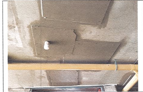
PINTURA PARA TAPAS EN DRYWALL-BIBLIOTECA PENDIENTE ARREGLAR REMATES
