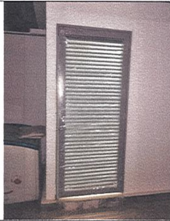
INSTALACION DE PUERTA-CUARTO DE REFRIGERIOS
