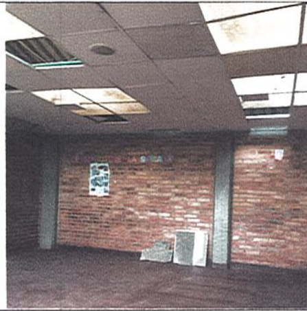
DESMONTE CIELO RASO
