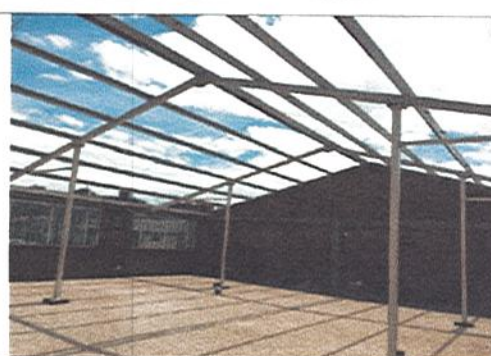
DESMONTE CUBIERTA EN ASBESTO CEMENTO-SALON MULTIPLE
