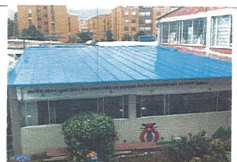
VISTA SUPERIOR DE CUBIERTA
