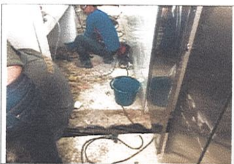
DESMONTE DE TUBERIA HIDROSANITARIA GALVANIZADA
