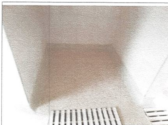
ACABADO DE PISO GRANITO Y MEDIA CAÑA PULIDA
