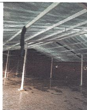
CUBRIMIENTO DE ESTRUCTURA CON PLASTICO
