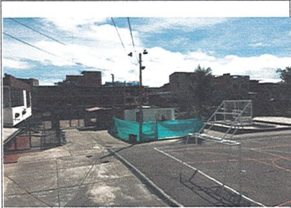
CASETA TIENDA ESCOLAR Y CUARTO DE REFRIGERIOS
