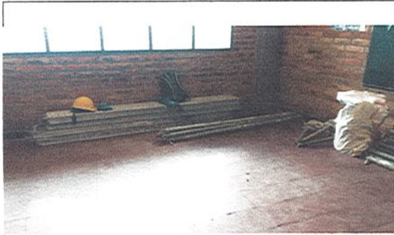
INGRESO DE MATERIAL DE REFUERZO ESTRUCTURAL
