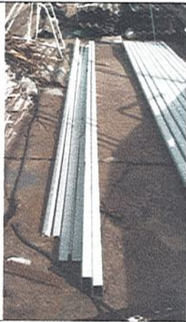
PINTURA DE PERFILERIA METALICA PARA REFORZAMIENTO ESTRUCTURAL
