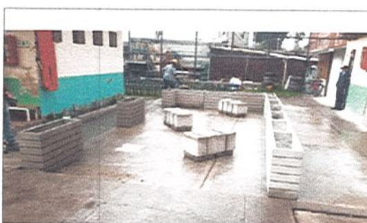
INSTALACION DE MATERAS Y BANCAS EN CONCRETO
