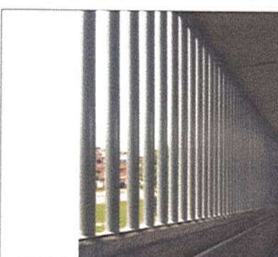
FINALIZA PINTURA DE TUBERIA
