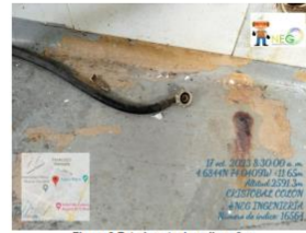
Figura 3 Estado actual media cañas
