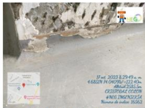
Figura 2 Estado actual media cañas
