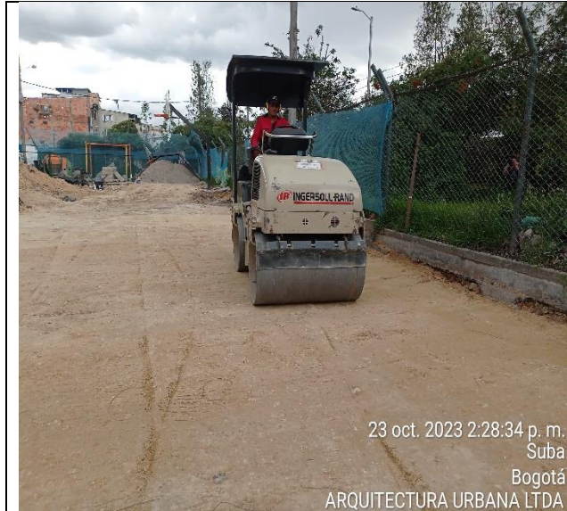
Fotografía N°9. PARQUE LISBOA. COD - II-091. Se verifica por parte de Interventoría ARQUITECTURA URBANA LTDA, la compactación de fondo de excavación de la cancha del costado occidental del parque, la compactación se realiza con vibro compactador.
