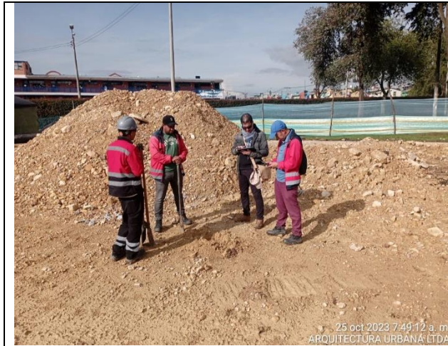
Fotografía N°1. PARQUE SABANA DE TIBABUYES. COD - II-246. Visita del profesional en Geotecnia de la Interventoría ARQUITECTURA URBANA LTDA ING. DIEGO NARVAEZ para la verificación de las condiciones del terreno donde se establece mejoramiento en rajón a una profundidad de 30-40 cm y mejoramiento con agua cal de la subrasante de la zona de la pista de patinaje.
