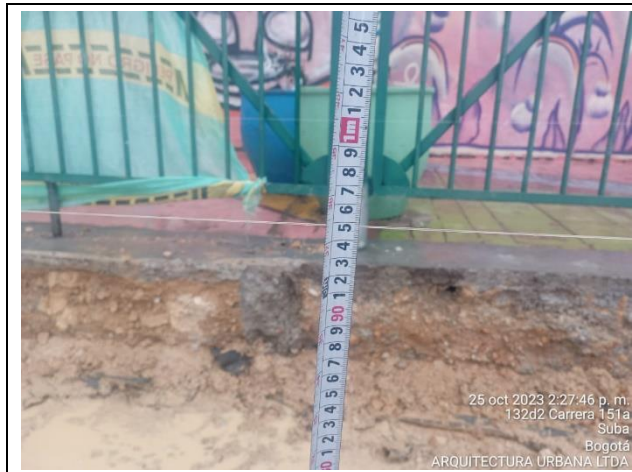
Fotografía N°17. PARQUE LISBOA. COD - II-091. Se verifica por parte de Interventoría ARQUITECTURA URBANA LTDA los niveles de compactación de la base de excavación N+0.95 mt para el acabado de la subrasante de la estructura de conformación de rellenos de subbase, base y carpeta asfáltica el cual corresponderá a 0.45 mt.
