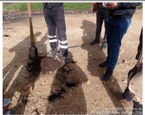
Fotografía N°2. PARQUE SABANA DE TIBABUYES. COD - II-246. Visita del profesional en Geotecnia de la Interventoría ARQUITECTURA URBANA LTDA ING. DIEGO NARVAEZ para la verificación de las condiciones del terreno donde se establece mejoramiento en rajón a una profundidad de 30-40 cm y mejoramiento con agua cal de la subrasante de la zona de la pista de patinaje.
