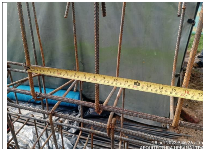
Fotografía N°3. PARQUE SABANA DE TIBABUYES. COD - II-246. Se verifica por parte de Interventoría ARQUITECTURA URBANA LTDA la actividad de armado y amarre de acero de refuerzo de 60.000psi para la viga de cimentación de la malla contra impacto, la cual se realiza en varillas No.4 para el refuerzo longitudinal y flejes en varilla No.3 distanciados cada 0.20m de acuerdo a las especificaciones técnicas del INSTITUTO DISTRITAL DE RECREACION Y DEPORTE (IDRD).
