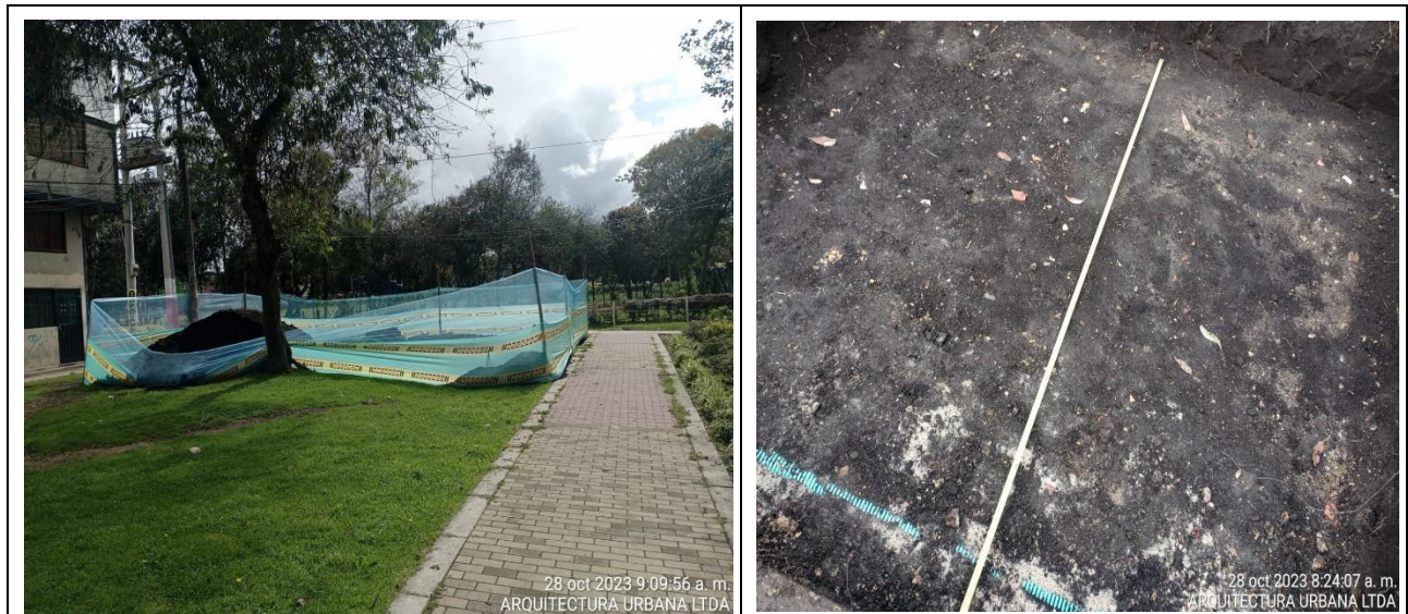
Fotografía N°25. PARQUE URB. PUERTA DEL SOL. COD – II-552. Se verifica por parte de Interventoría ARQUITECTURA URBANA LTDA la construcción del cerramiento perimetral a una altura de 2.00m de la zona a intervenir, de acuerdo a las especificaciones técnicas del INSTITUTO DISTRITAL DE RECREACION Y DEPORTE (IDRD).
