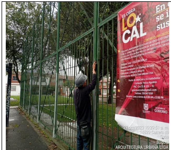
Fotografía N° 19. PARQUE URB. SANTA HELENA. COD - II-062. Se verifica por parte de Interventoría ARQUITECTURA URBANA LTDA el lijado de la malla contra impacto existente de acuerdo a lo establecido en las especificaciones técnicas del INTITUTITO DISTRITAL DE RECREACION Y DEPORTE (IDRD).
