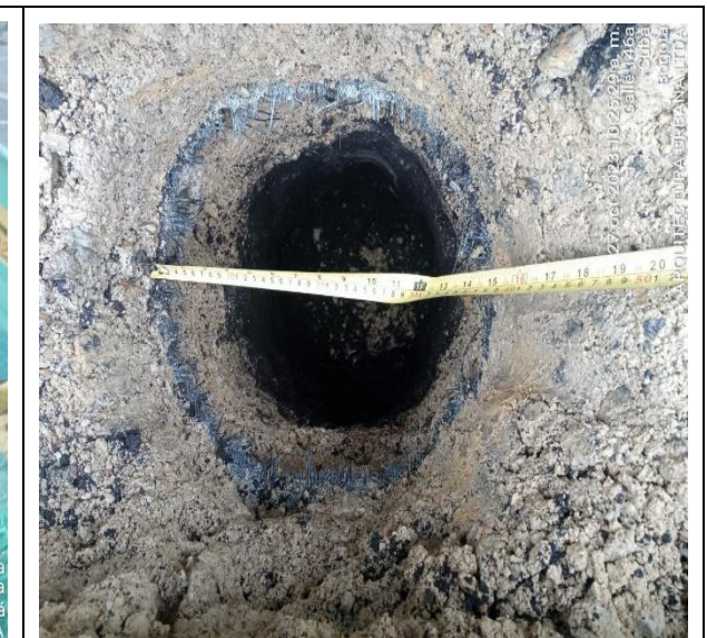
Fotografía N° 22. PARQUE URB. SANTA HELENA. COD - II-062. Se verifica por parte de Interventoría ARQUITECTURA URBANA LTDA el diámetro de 0.30m de la excavación para los pilotes para la cimentación de la malla contra impacto, de acuerdo a las especificaciones técnicas del INTITUTITO DISTRITAL DE RECREACION Y DEPORTE (IDRD).
