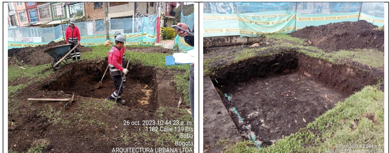
Fotografía N°27. PARQUE URB. PUERTA DEL SOL. COD – II-552. Se verifica por parte de Interventoría ARQUITECTURA URBANA LTDA el descapote y la excavación manual para la construcción de placa en concreto para la instalación de equipos biosaludable.
