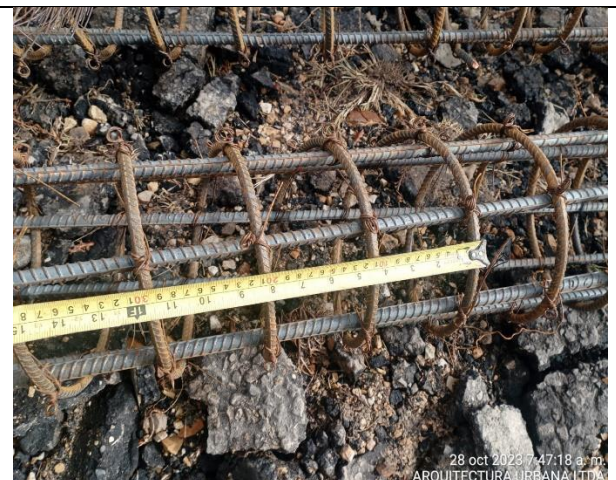
Fotografía N°4. PARQUE SABANA DE TIBABUYES. COD - II-246. Se verifica por parte de Interventoría ARQUITECTURA URBANA LTDA la actividad de armado y amarre de acero de refuerzo de 60.000psi para los pilotes de cimentación para la malla contra impacto, la cual se realiza con refuerzos longitudinales en varilla No. 4 y espirales en varilla No. 3 distanciados cada 0.10m de acuerdo a las especificaciones técnicas del INSTITUTO DISTRITAL DE RECREACION Y DEPORTE (IDRD).
