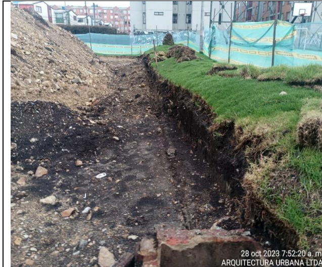
Fotografía N°5. PARQUE SABANA DE TIBABUYES. COD – II-246. Se verifica por parte de Interventoría ARQUITECTURA URBANA LTDA excavación del sobreancho para la construcción del andén cuneta de la cancha.
