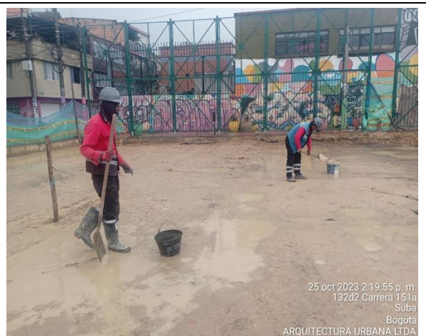
Fotografía N°18. PARQUE LISBOA. COD - II-091. Se observa por parte de Interventoría ARQUITECTURA URBANA LTDA los imprevistos generados frente a las constantes lluvias generadas y las afectaciones a las áreas previstas de compactación de fondo de excavación realizadas en el costado de la cancha N° I.
