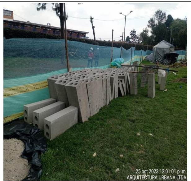
Fotografía N°8. PARQUE SABANA DE TIBABUYES. COD – II-246. Se verifica por parte de Interventoría ARQUITECTURA URBANA LTDA la disposición temporal de BORDILLO A-80 para las actividades de confinamiento de las estructuras de la cancha de microfútbol y pista de patinaje.
