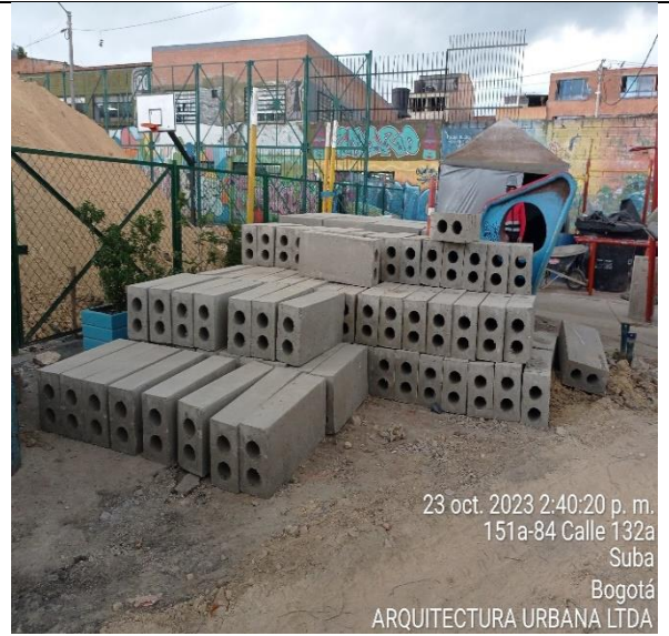
Fotografía N°10. PARQUE LISBOA. COD - II-091. PARQUE LISBOA. COD - II-091. Se verifica por parte de Interventoría ARQUITECTURA URBANA LTDA, la llegada de 250 unidades de bordillo A-80 a la obra.
