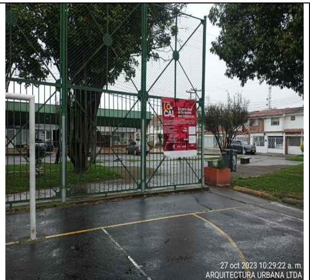
Fotografía N° 20. PARQUE URB. SANTA HELENA. COD - II-062. Se verifica por parte de Interventoría ARQUITECTURA URBANA LTDA la instalación de la valla informativa de la intervención a realizar en el parque durante la ejecución del contrato.
