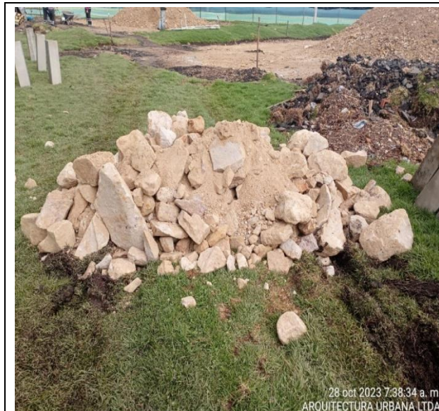
Fotografía N°7. PARQUE SABANA DE TIBABUYES. COD – II-246. Se verifica por parte de Interventoría ARQUITECTURA URBANA LTDA la disposición de RAJON para las actividades de mejoramiento previo a la instalación de la subbase granular.
