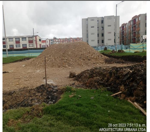
Fotografía N°6. PARQUE SABANA DE TIBABUYES. COD – II-246. Se verifica por parte de Interventoría ARQUITECTURA URBANA LTDA el acopio temporal de material producto de excavación para su disposición final en puntos autorizados.
