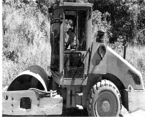
TRABAJOS DE COMPACTACION EN VIA TERCARIA
