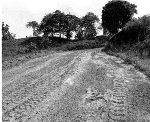
TRABAJOS CON MOTONIVELADORA EN TRAMO
