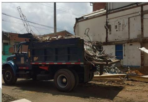
Foto 23: ENTREGA DE ESTRUCTURAS METALICAS A LA ALCALDIA
