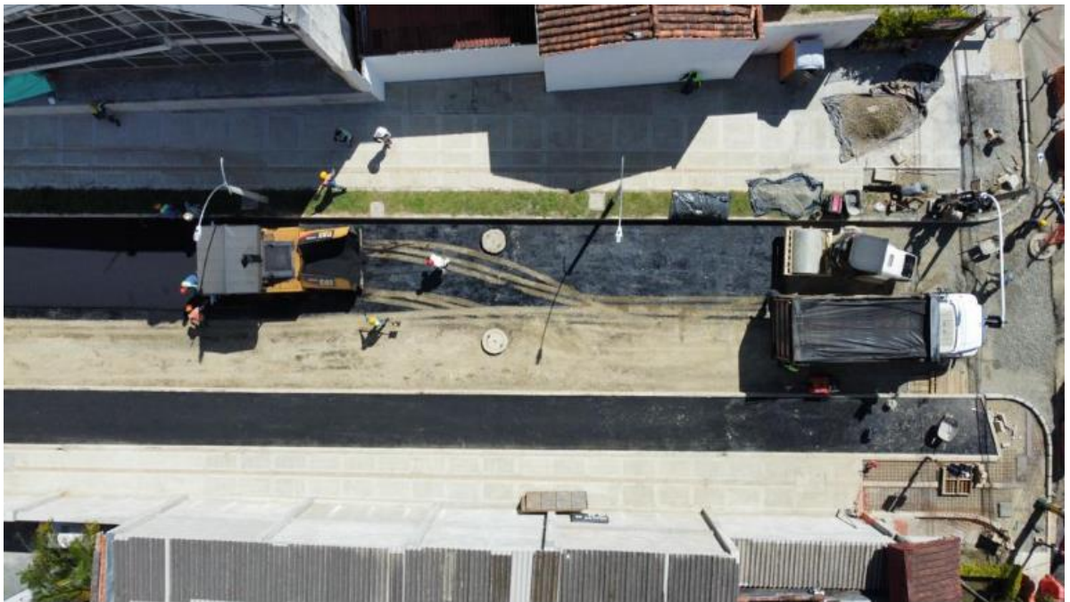
Pavimentación de la calle 65 sur (nueva vía de conexión)
