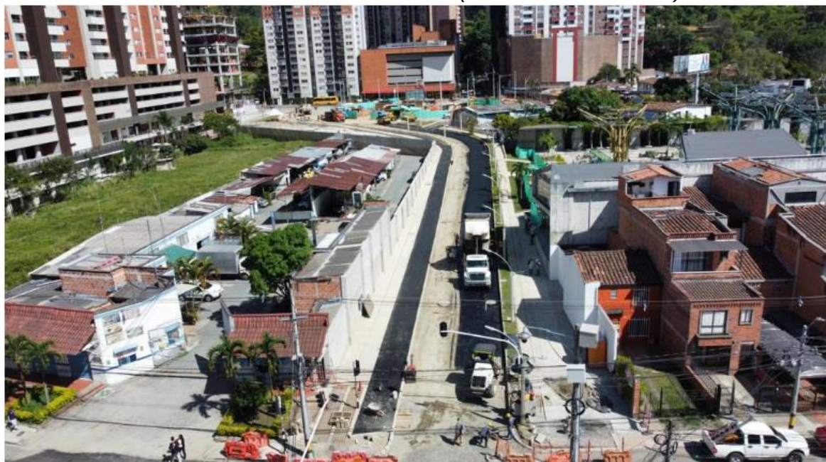
Pavimentación de la calle 65 sur (nueva vía de conexión)
