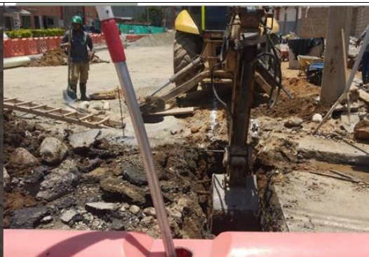
Foto 22: EXCAVACION RED ALCANTARILLADO EN PEPSICO
