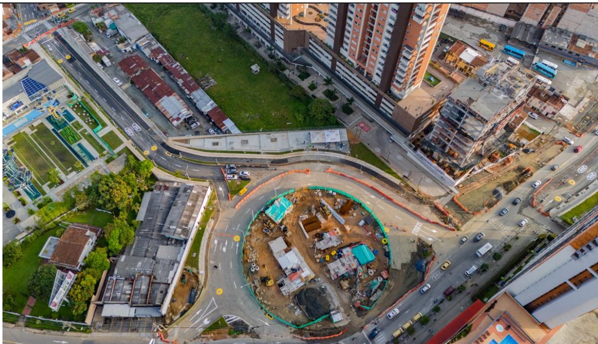
Habilitación del primer tramo de la glorieta sobre la carrera 43 A y calle 65 sur en el mes de octubre del 2023
