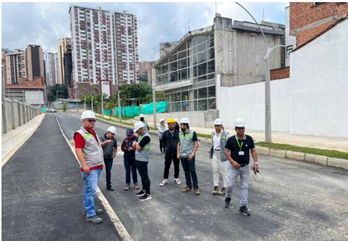
Recorrido de obra el día por la nueva via de empalme (calle 65 sur)
