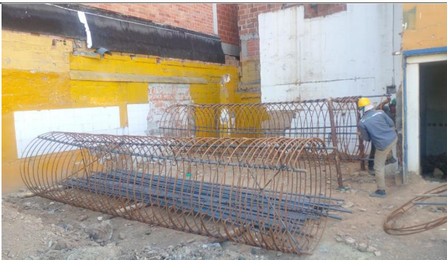
Ejecución de pilas en el sector de la calle 62 sur para la construcción del nuevo puente sobre la quebrada
