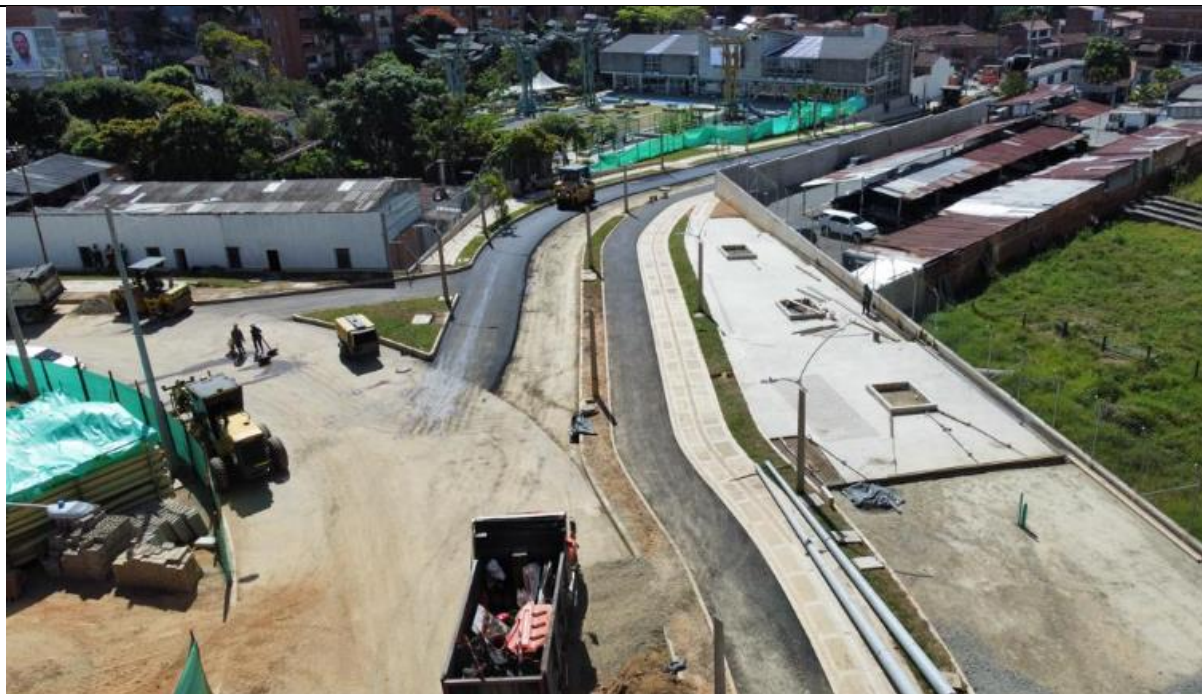
Vista de nueva vía (calle 65 sur-empalme con rotonda principal sobre la Av el Poblado)
