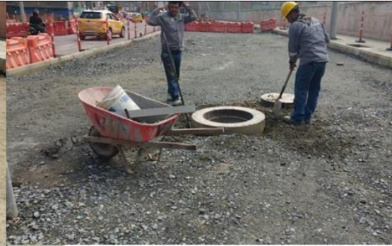
Foto 6: INSTALACION DE CUELLO EN MH ALCAZARES
