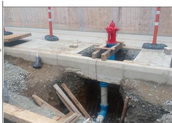
Foto 9: INSTALACION DE HIDRANTE EN ALCAZARES
