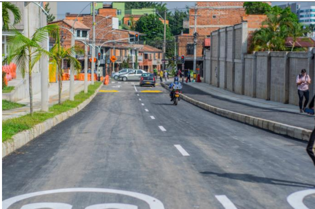
Habilitación de primer tramo de la Fase I _Glorieta principal y calle 65 sur
