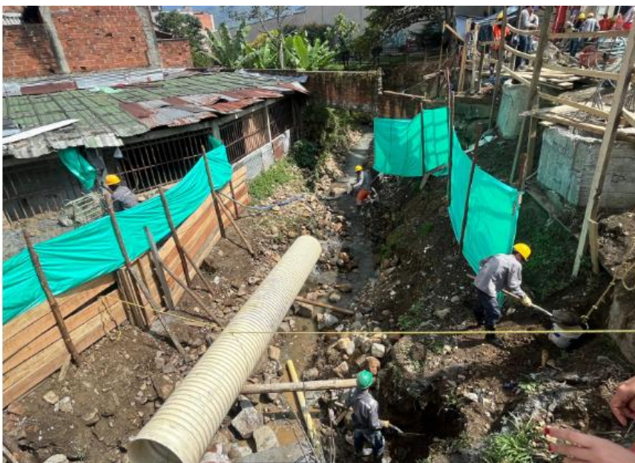
Ejecución de pilas en el sector de la calle 62 sur para la construcción del nuevo puente sobre la quebrada
