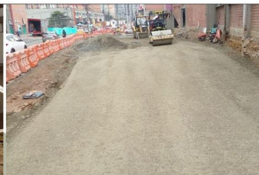
Foto 24: COMPACTACION DE BASE GRANULAR SUBRASANTE PEPSICO
