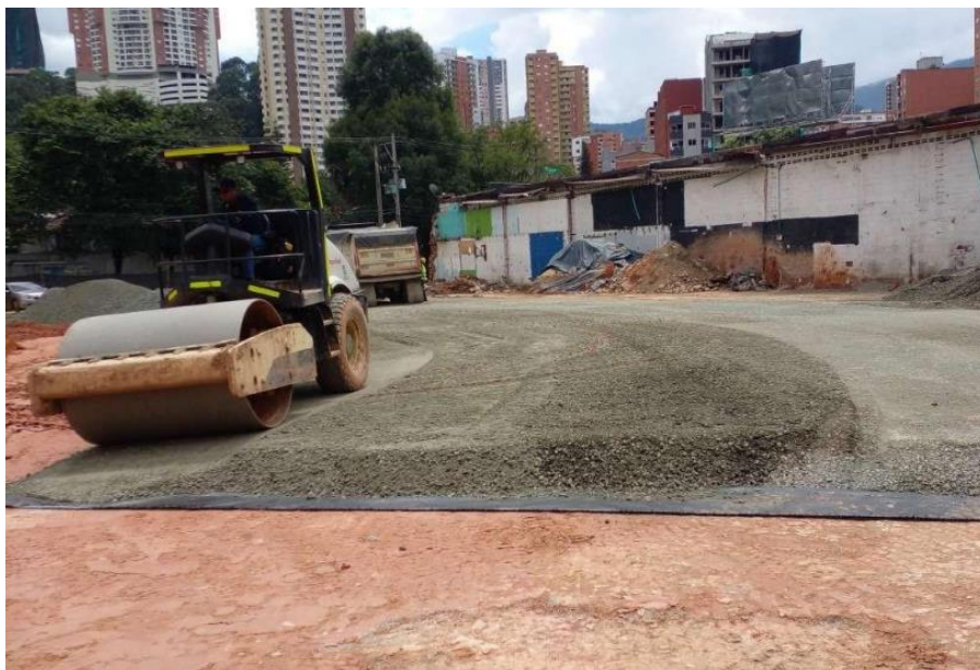
Compactación de base granular en la glorieta principal de la calle 65 sur
