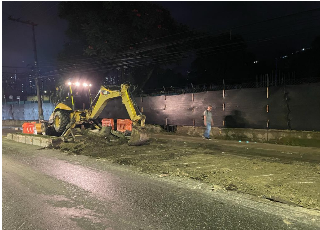
Nivelación de subbase y base granular
