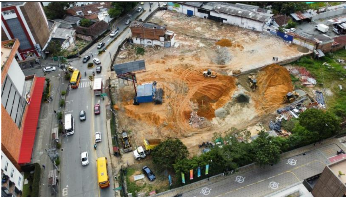
Vista general de la glorieta principal del proyecto a julio del 2023
