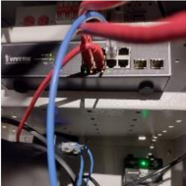
Ilustración 26 – LPR174, Instalación de Switch
