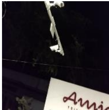
Ilustración 28 – LPR177-2, Instalación de cámara LPR
