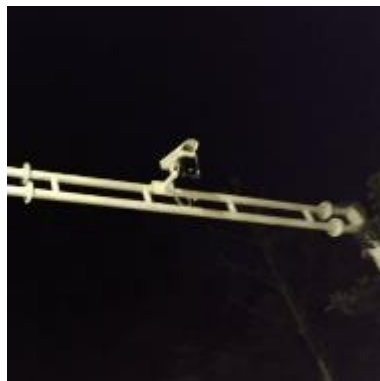
Ilustración 25 – LPR174-2, Instalación cámara LPR
