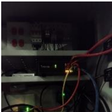
Ilustración 29 – LPR177, Instalación de Switch
