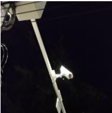
Ilustración 27 – LPR177-1, Instalación de cámara LPR
