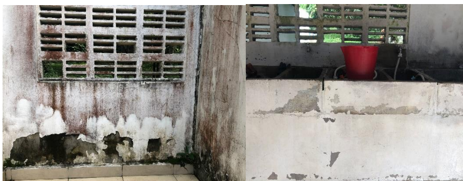
Zona de patio
