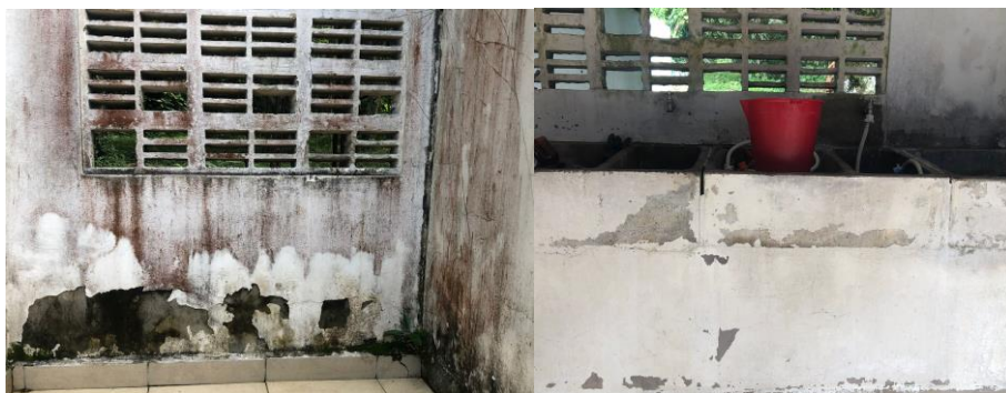
Zona de patio
