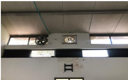
ZONA DE DORMITORIOS
