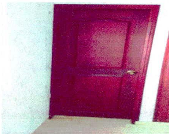
APLICACIÓN DE PINTURA EN PUERTAS
