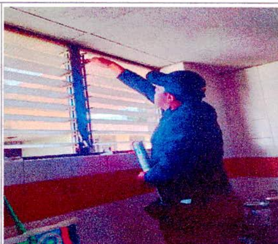
APLICACION DE SILICONA EN VENTANAS
