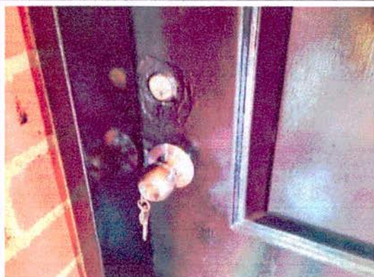
INSTALACION DE CERRADURA
