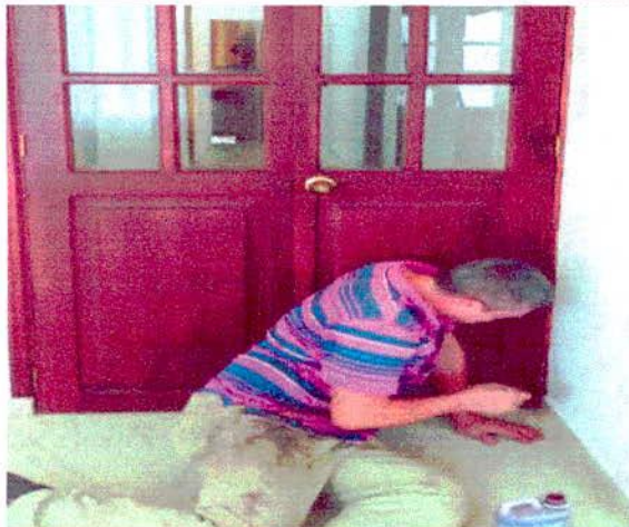
APLICACIÓN DE PINTURA EN PUERTAS
