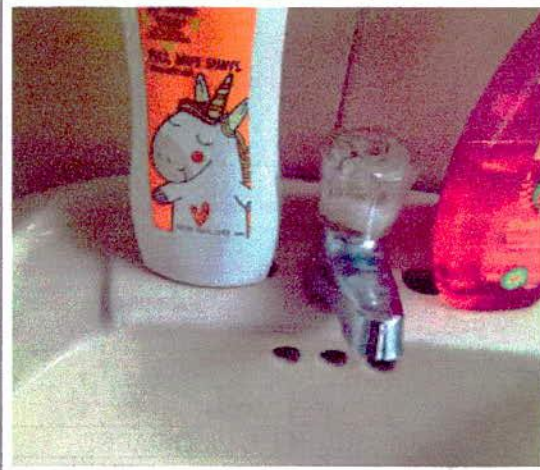
CAMBIO DE LLAVE DE LAVAMANOS
