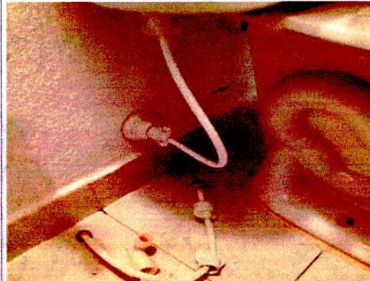
CAMBIO DE ACOUPLE DE SANITARIO
