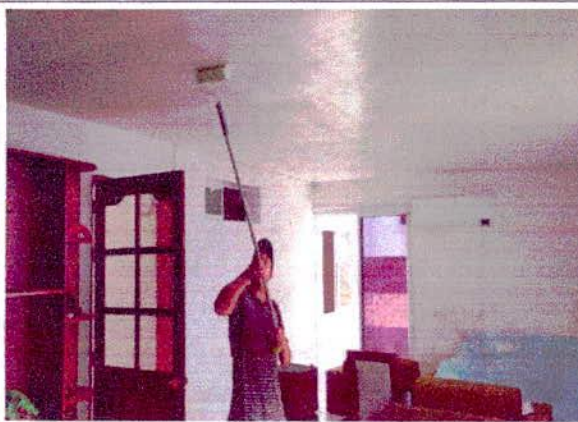
APLICACIÓN DE PINTURA
