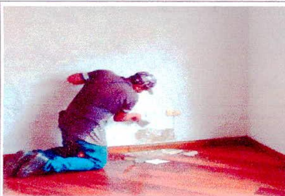
ARREGLO DE PAREDES
