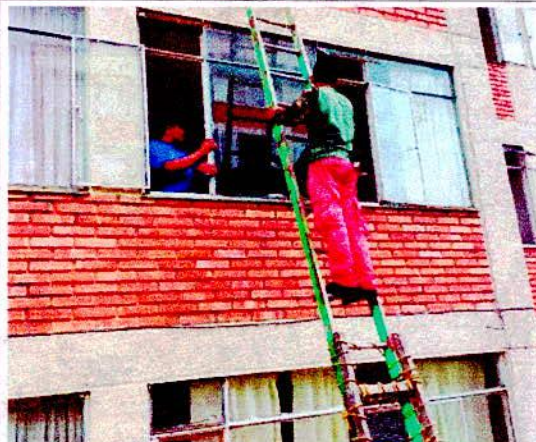
INSTALACION DE VIDRIO EN VENTANA
