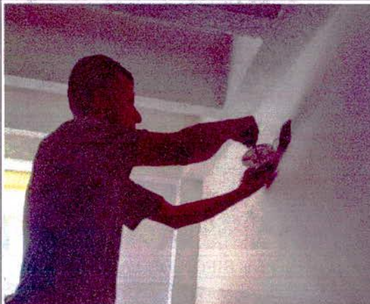
INSTALACION DE PLAFON
