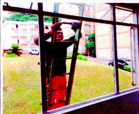
INSTALACION DE VIDRIO EN VENTANA
