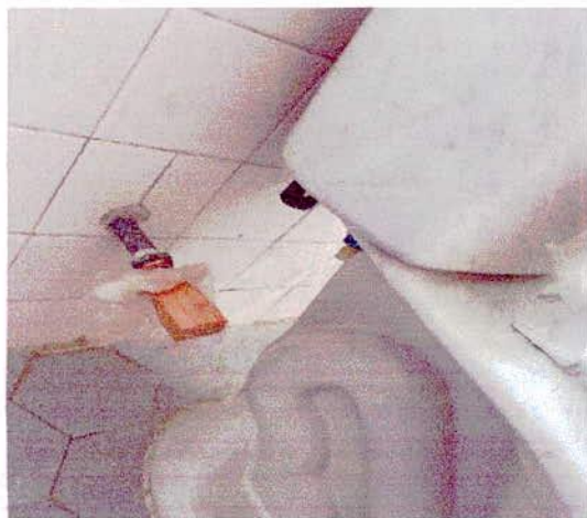
INSTALACION DE ACOPLE
