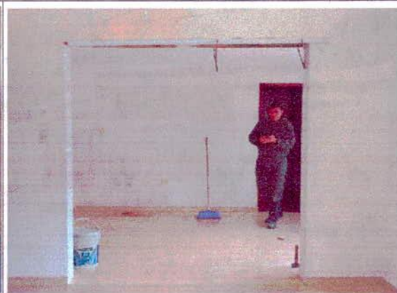
MARCO DE PASILLO TERMINADO
