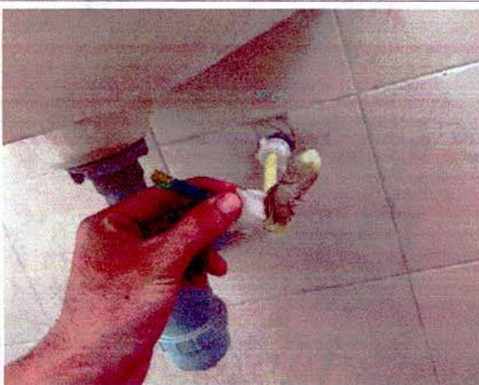
CAMBIO DE ACOPLA LAVAMANOS
