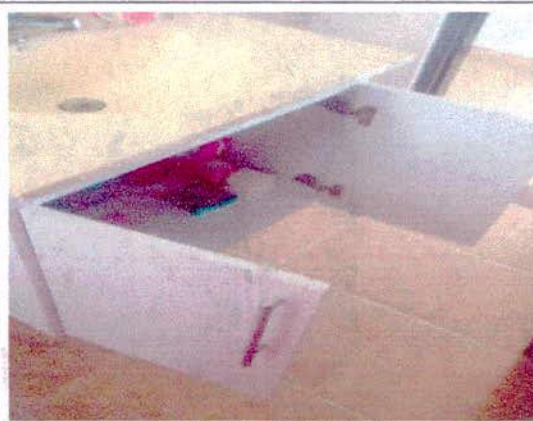
INSTALACION DE MUEBLE DE BAÑO
