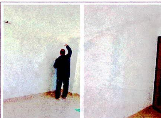
APLICACIÓN DE PINTURA EN PAREDES
