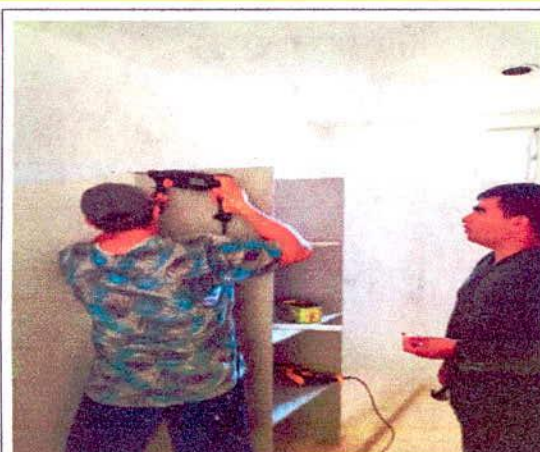
INSTALACION DE CLOSET
