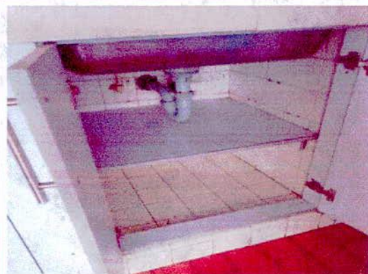
CAMBIO DE SIFON DE LAVAPALTOS
