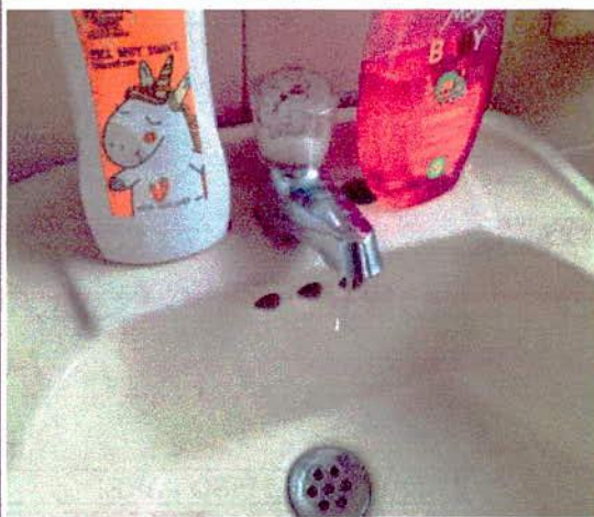
CAMBIO DE LLAVE DE LAVAMANOS
