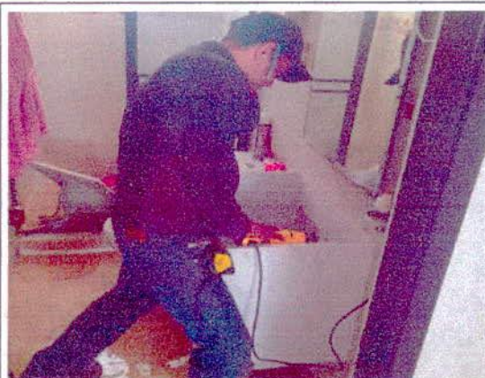
INSTALACION DE MUEBLE DE BAÑO
