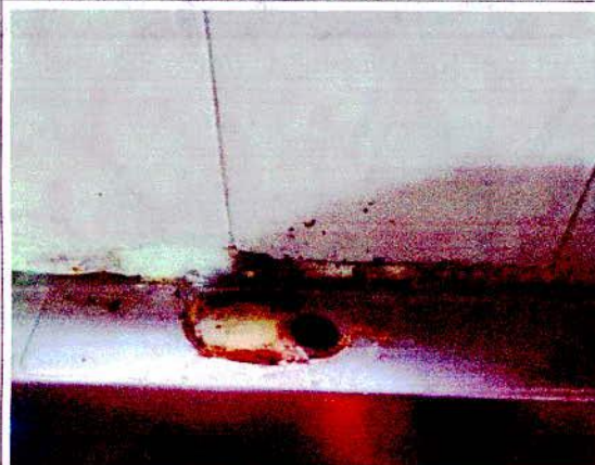
INSTALACION DE LLAVE LAVAPLATOS
