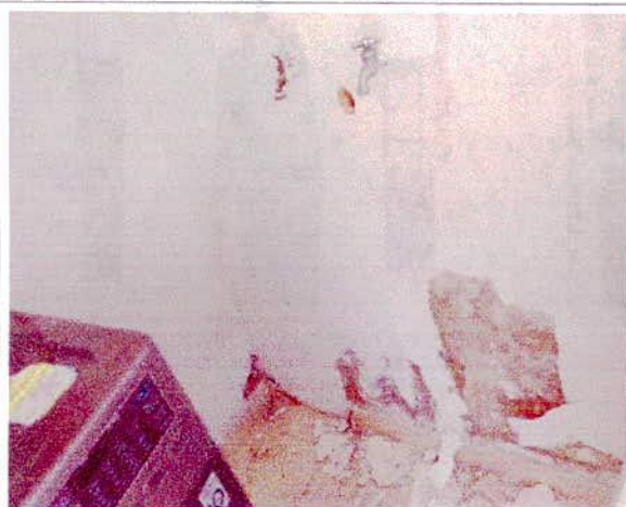
ARREGLO DE HUMEDADES
