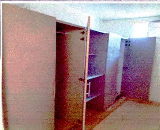
INSTALACION DE CLOSET
