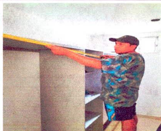
INSTALACION DE CLOSET
