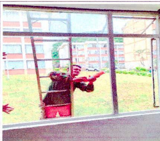
APLICACION DE SILICONA EN VENTANAS
