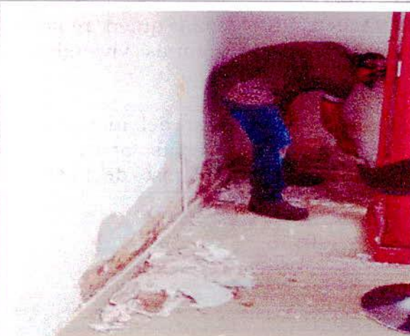
ARREGLO DE HUMEDADES
