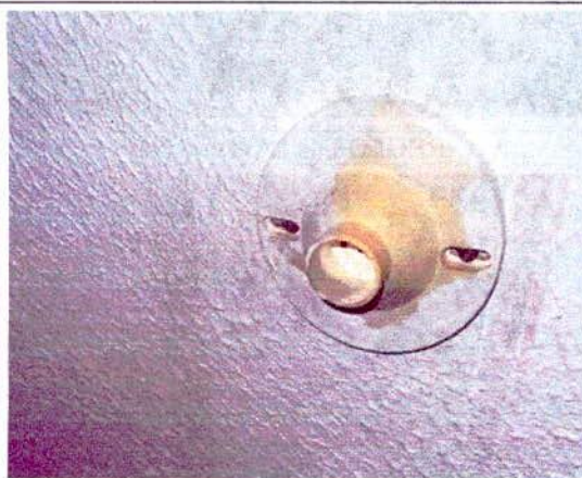
INSTALACION DE PLAFON
