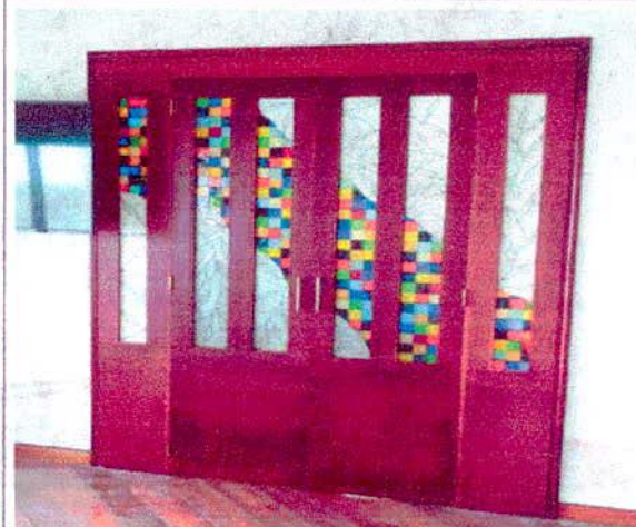
APLICACIÓN DE PINTURA EN PUERTAS
