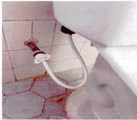
INSTALACION DE ACOPLE
