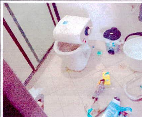
ARREGLO DE SANITARIO
