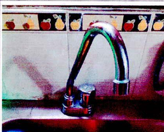
INSTALACION DE LLAVE LAVAPLATOS
