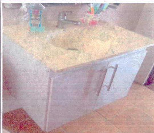
INSTALACION DE MUEBLE DE BAÑO
