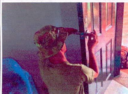
INSTALACION DE CERRADURA
