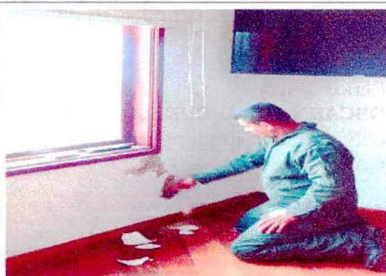
ARREGLO DE PAREDES
