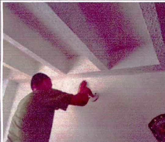
INSTALACION DE PLAFON
