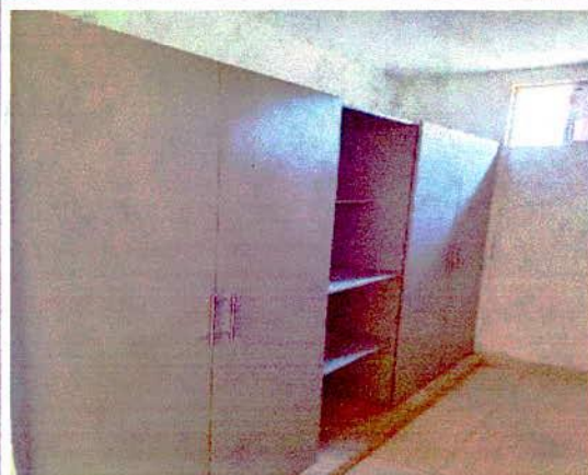
INSTALACION DE CLOSET
