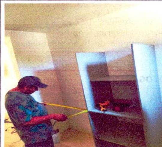
INSTALACION DE CLOSET
