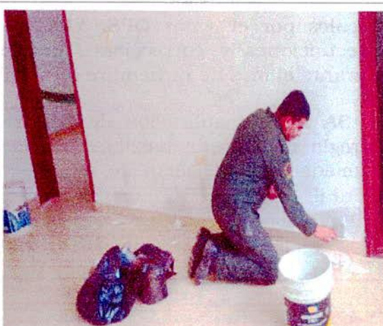
APLICACIÓN DE ESTUCO
