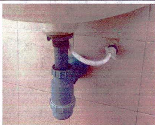
CAMBIO DE ACOPLA LAVAMANOS
