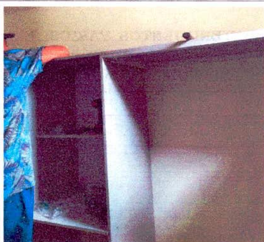
INSTALACION DE CLOSET
