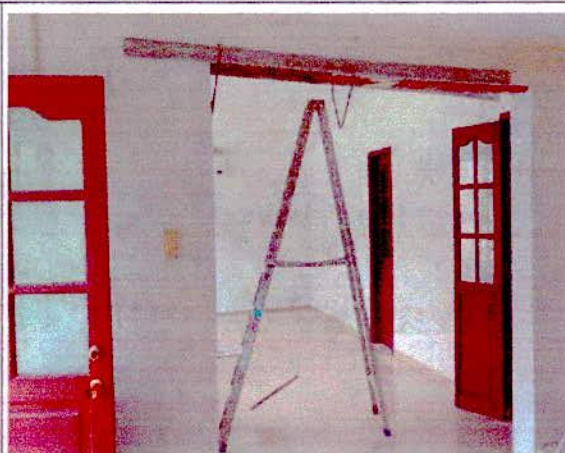
ARREGLO ARCO DE PASILLO
