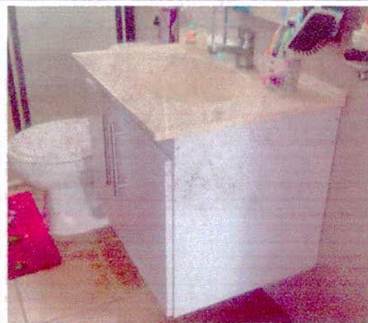
INSTALACION DE MUEBLE DE BAÑO
