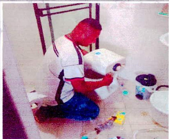
ARREGLO DE SANITARIO
