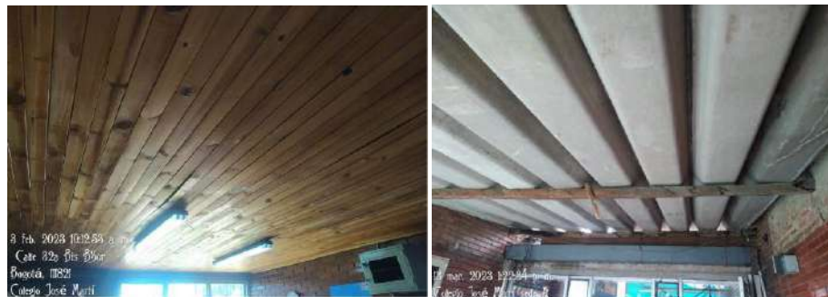
imagen 9. Desmonte de luminarias en orientación
