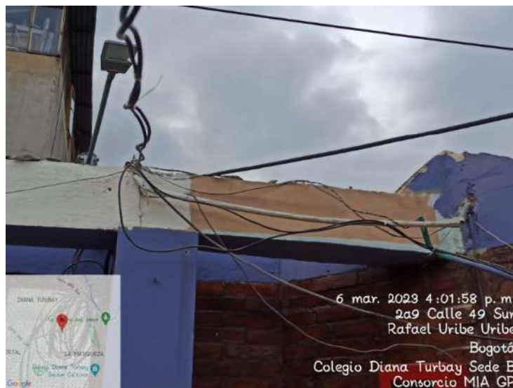
imagen 2. Desmonte de salidas eléctricas.
