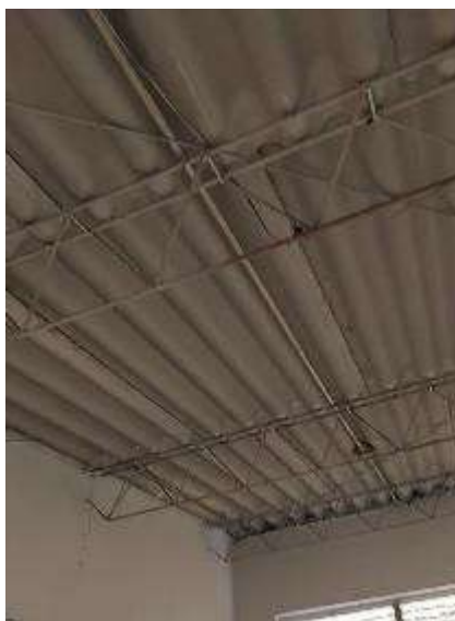
Imagen 5. Cerchas de cubierta con adosadas a mampostería
