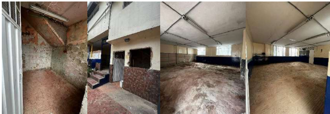
imagen 2. Demolición áreas intervenidas
