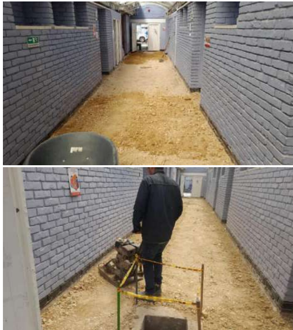
imagen 26. Relleno y compactación de subbase granular B-400 en edificio 2, piso 1 Colegio Restrepo Millán Sede B Isabel II de Inglaterra
