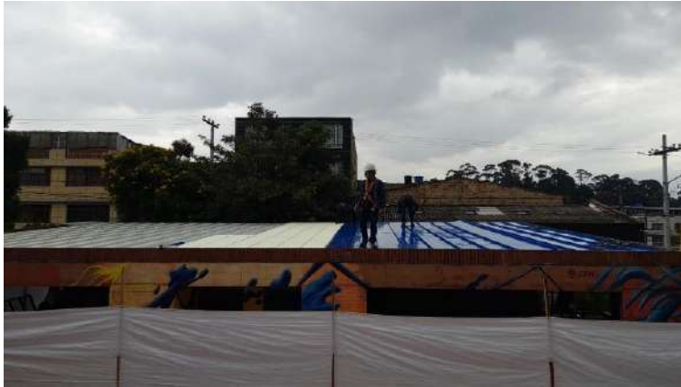
Imagen 42. Suministro e instalación de cubierta modular tipo sándwich.
