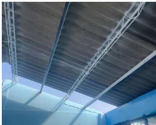
imagen 29. Perfiles adicionales para instalación de teja
