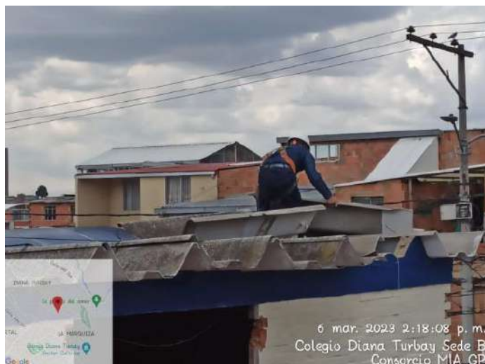
Imagen 3. Desmonte de canal.
