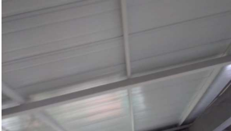
Imagen 40. Pintura sobre estructura.
