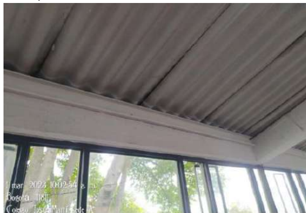
imagen 10. Perfil en C instalado perimetralmente para evitar que se levante la teja
