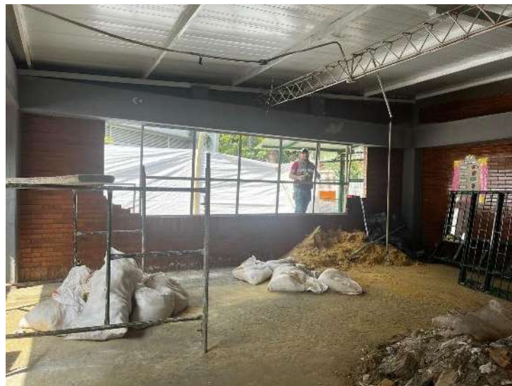
Imagen 41. Suministro e instalación de carpintería aluminio.
