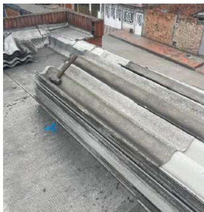
imagen 31. Desmonte de cubierta existente
