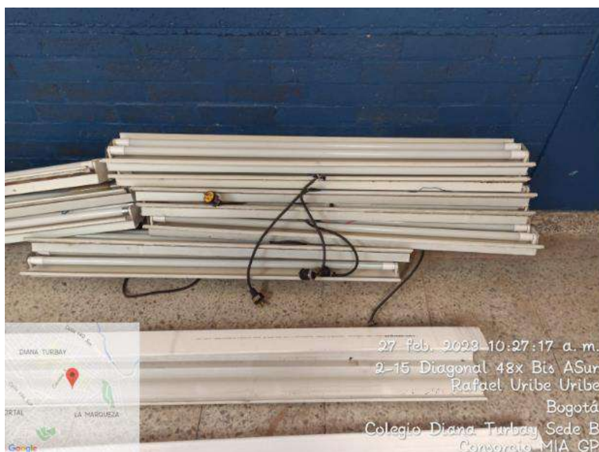
imagen 4 Desmonte de lámparas.
