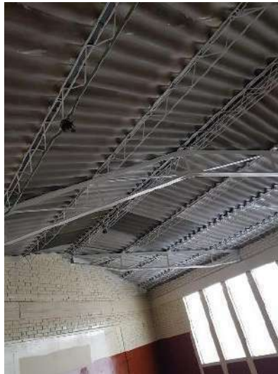
Imagen 50. Pintura de cerchas existentes.
