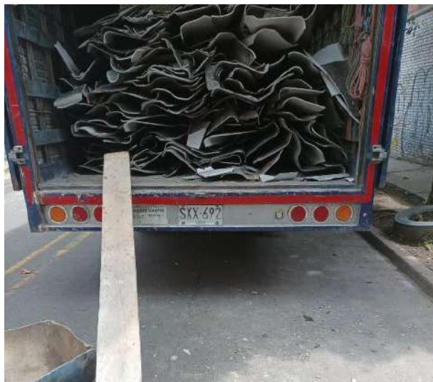
Imagen 43. Disposición final teja de asbesto cemento.
