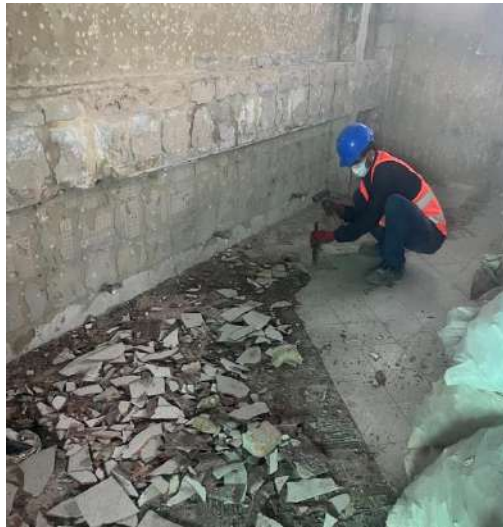
imagen 28. Demolición de enchape de piso y pared
