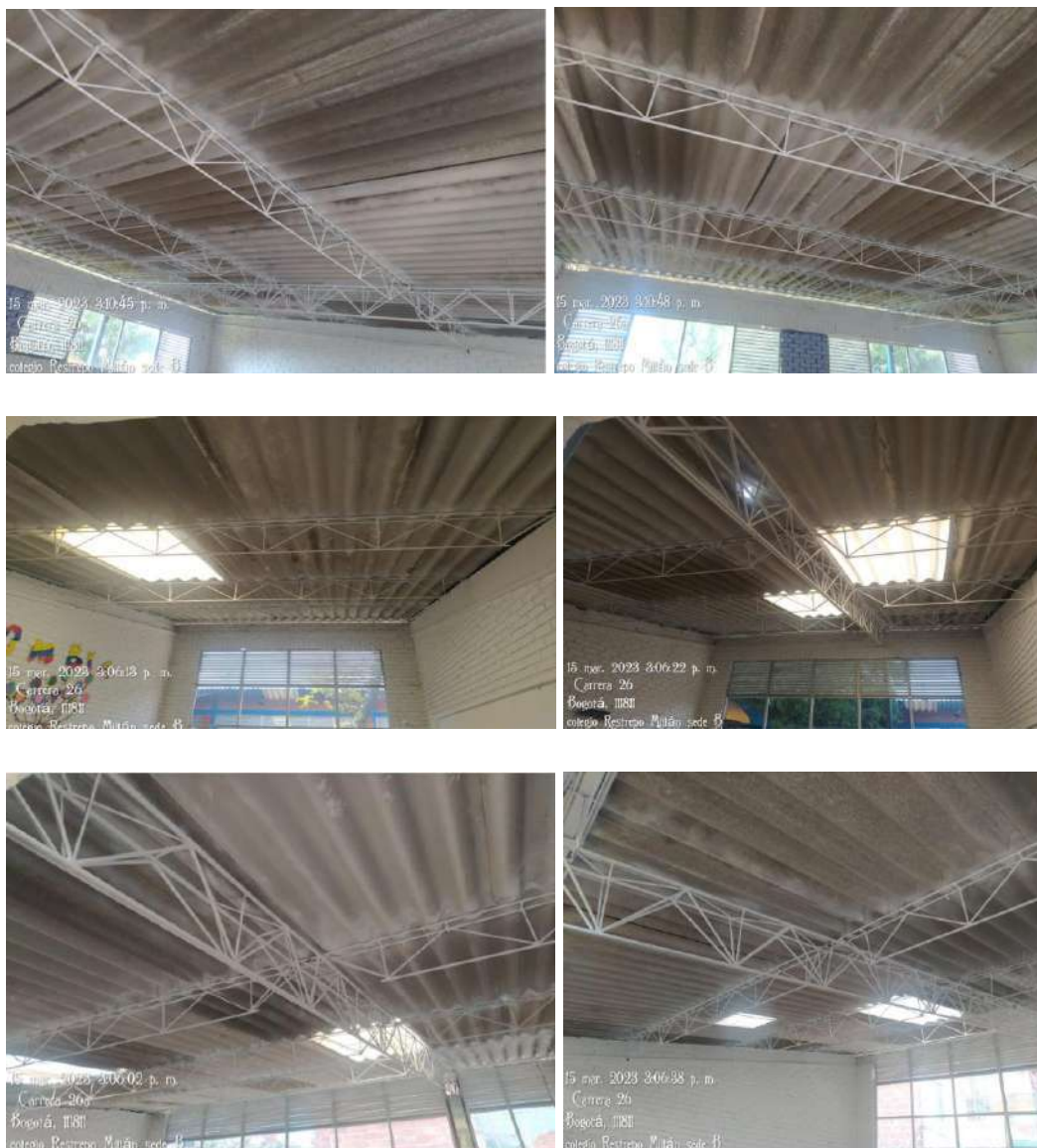
imagen 27. Mantenimiento de cerchas existentes en edificio 2, piso 1 Colegio Restrepo Millán Sede B Isabel II de Inglaterra
