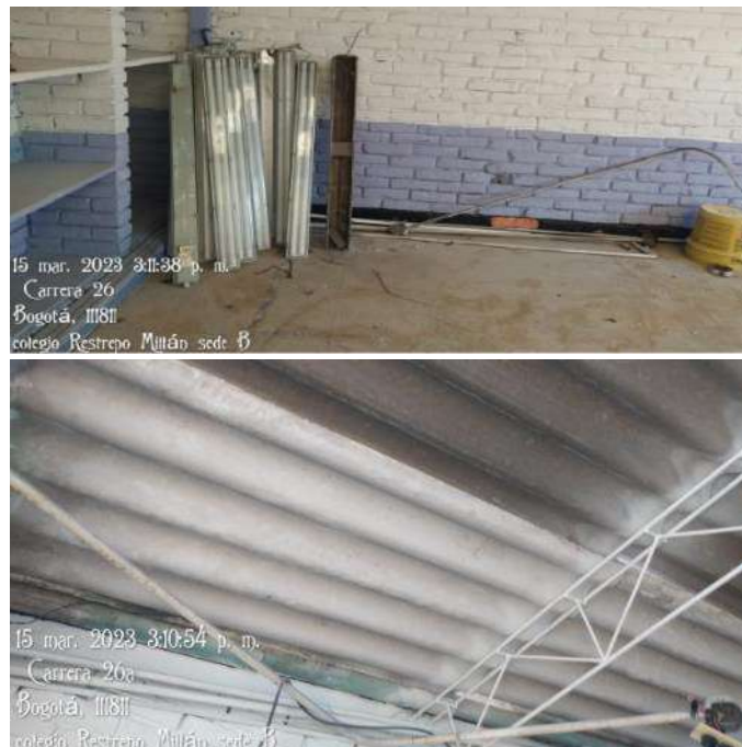
imagen 24. Desmonte de salidas eléctricas existentes en edificio 2, piso 1 Colegio Restrepo Millán Sede B Isabel II de Inglaterra
