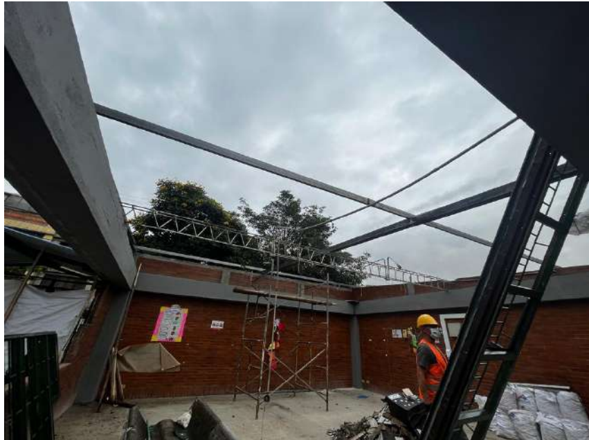
Imagen 36. Desmonte de cubierta existente
