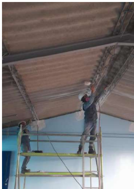
Imagen 31. Esmalte sobre estructura existente
