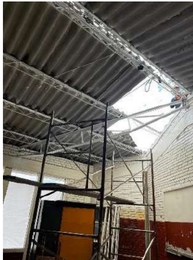
Imagen 48. Desmonte de Cubierta existente
