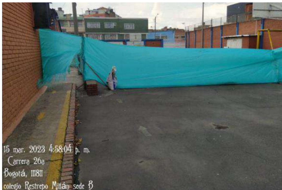
imagen 22. Cerramiento para aislar edificio 2 Colegio Restrepo Millán Sede B Isabel II de Inglaterra
