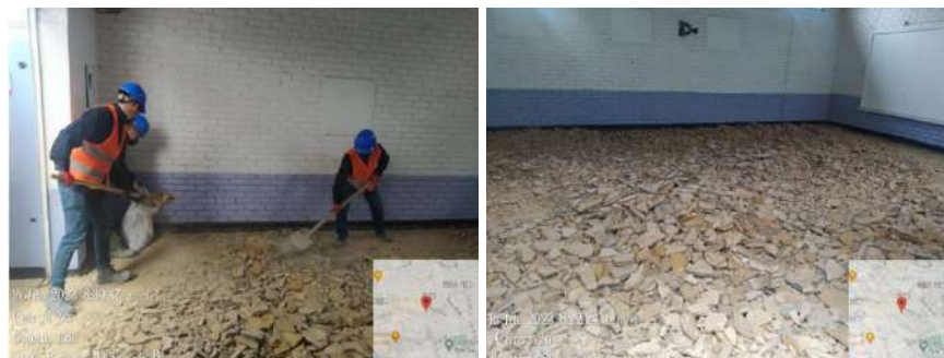
imagen 19. Demolición piso en corredor 33 y aula 32 edificio 2 Colegio Restrepo Millán Sede B Isabel II de Inglaterra
