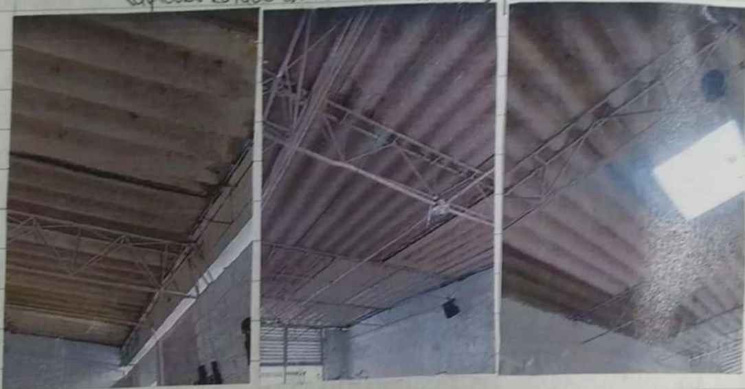
Edificio 2: Estado estructura metálica soporte de cubierta
