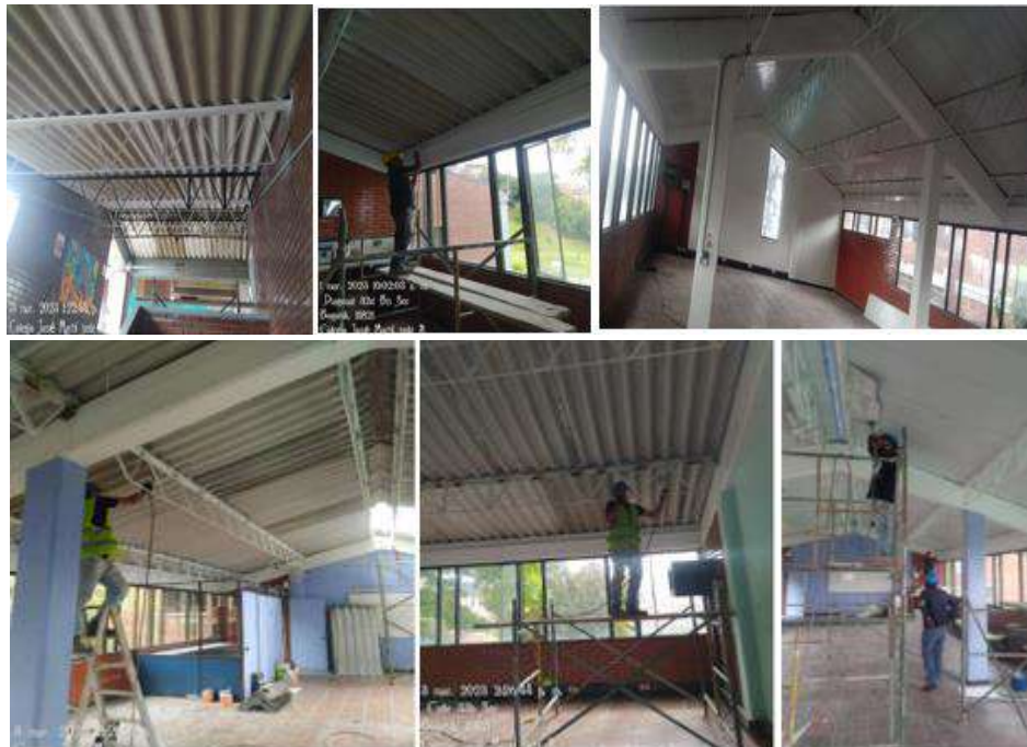
imagen 16. Pintura estructura metálica soporte cubierta en aula profesores
