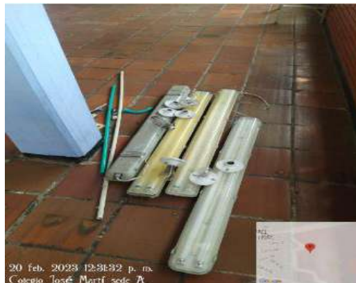
imagen 16. Desmonte de luminarias en aula profesores
