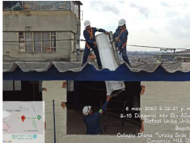
imagen 1. DESMONTE DE TODO TIPO DE CUBIERTA EXISTENTE
