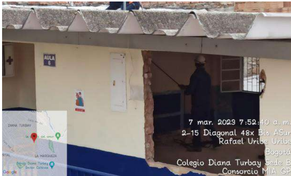
imagen 5. Desmonte de la tubería eléctrica.
