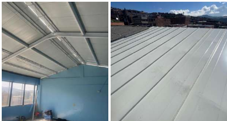
imagen 32. Instalación cubierta tipo sándwich
