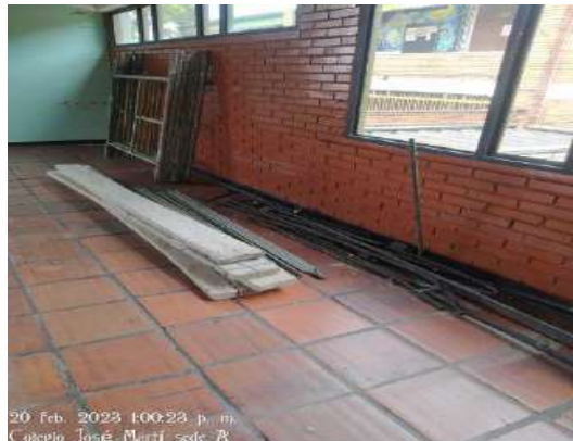
imagen 15. Desmonte de salidas eléctricas aula profesores
