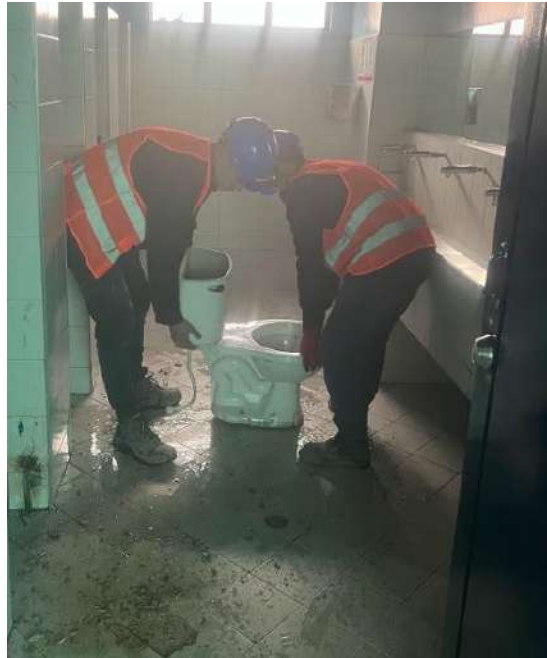
Imagen 30. Desmontes de aparatos sanitarios
