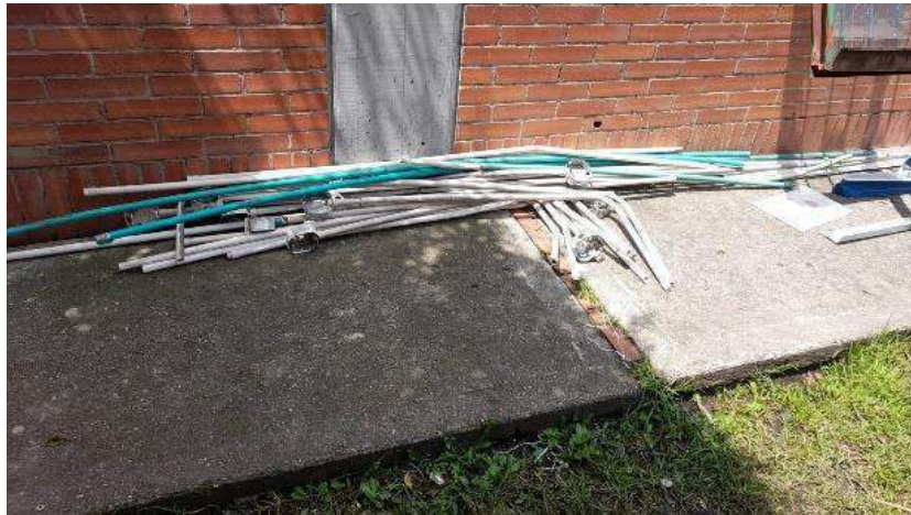
Imagen 38. Desmonte de red eléctrica.
