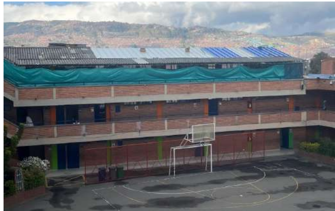
imagen 33. Instalación de primera capa cubierta, asilamiento y segunda capa
