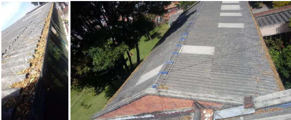
imagen 17. Canales edificio aula profesores
