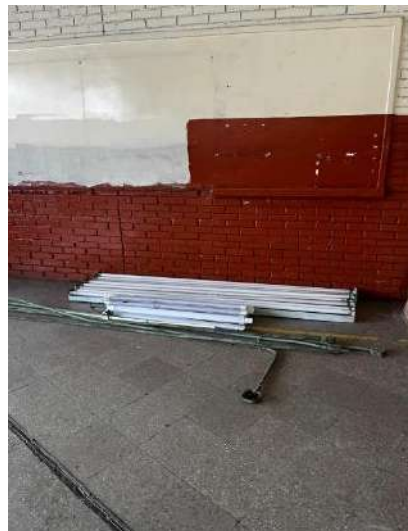
Imagen 49. Desmonte de Lámparas
