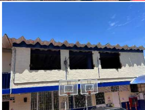
imagen 4 Desmonte de ventanas Edificio 2 y 3
