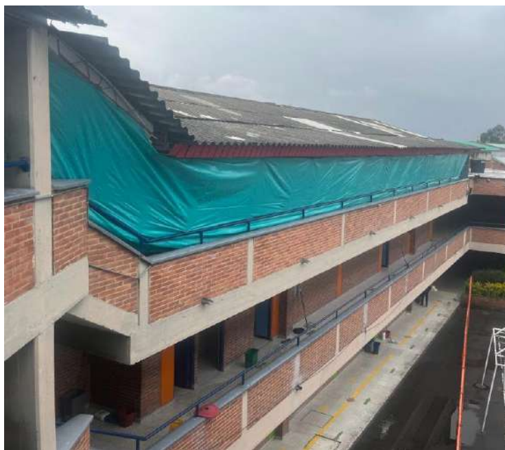
Imagen 27. Cerramiento en lona
