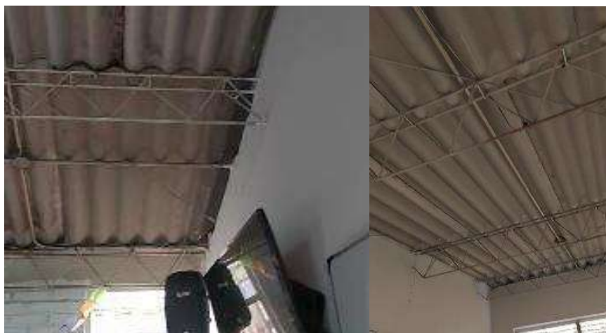
Imagen 9. Cercha típica transversal edificio 1, Altura: 0.25m
