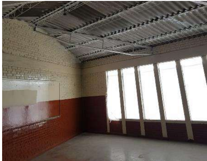
Imagen 47. Desmonte de Carpintería metálica.
