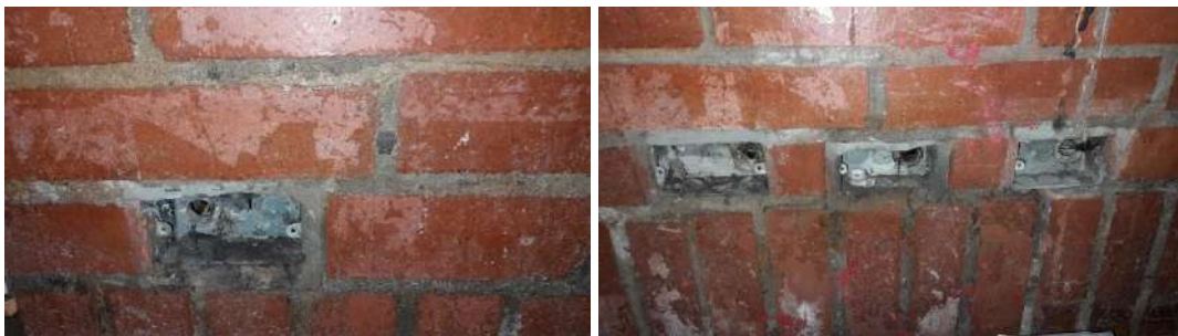
Imagen 37. Desmonte de salidas eléctricas.
