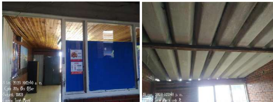
imagen 8. Desmonte de cielo falso en orientación
