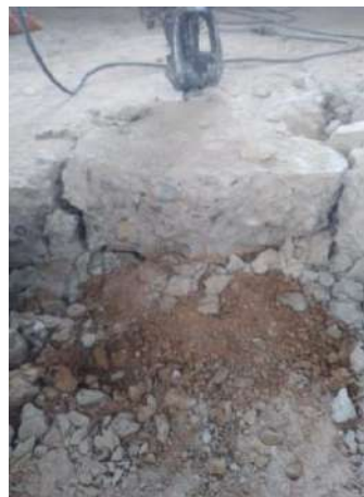
imagen 23. Demolición placa de piso en corredor 33 y aula 32 edificio 2
