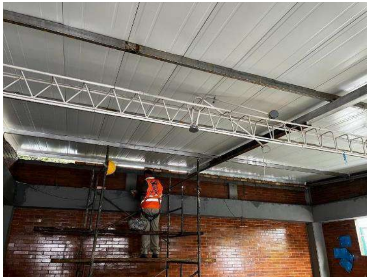
Imagen 39. Suministro e instalación de estructura metálica.
