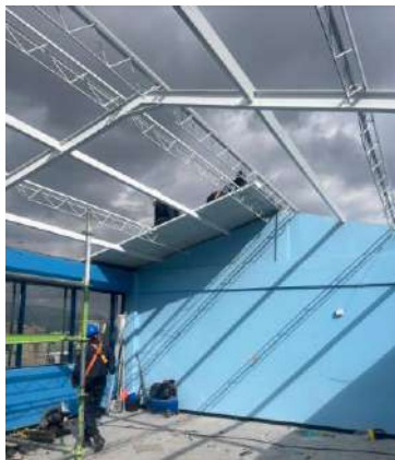
imagen 30. Desmonte y montaje de teja tipo sándwich primera cama
