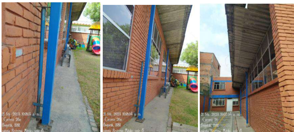
Imagen 7. Soportes verticales, columnetas soporte de cerchas
