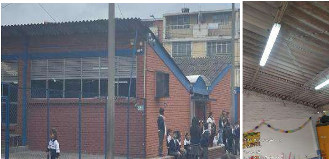
Imagen.4. Tejas de asbesto cemento EDIFICIO 1
