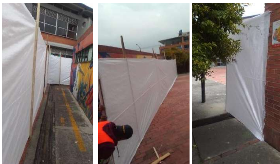
Imagen 33. Cerramiento en lona
