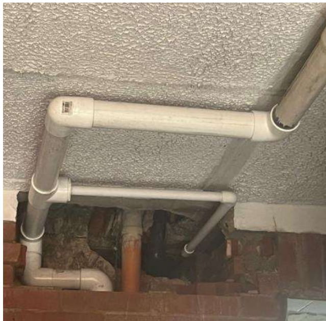
imagen 26. Reparación de Fuja
