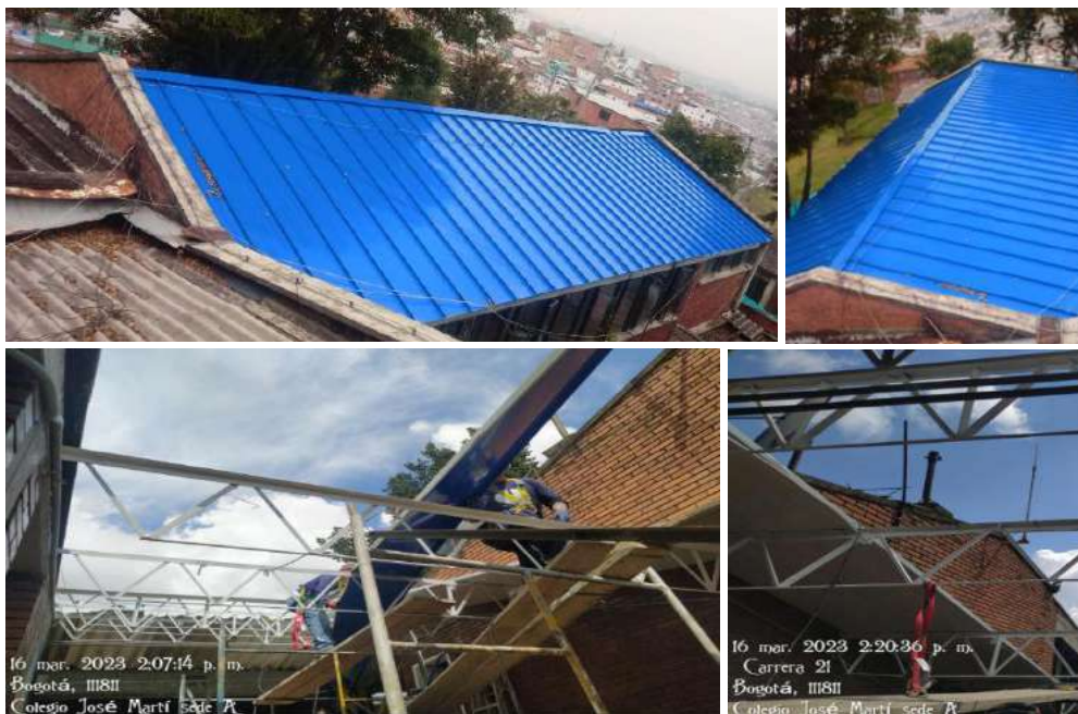
imagen 17. Cubierta standing sean.
