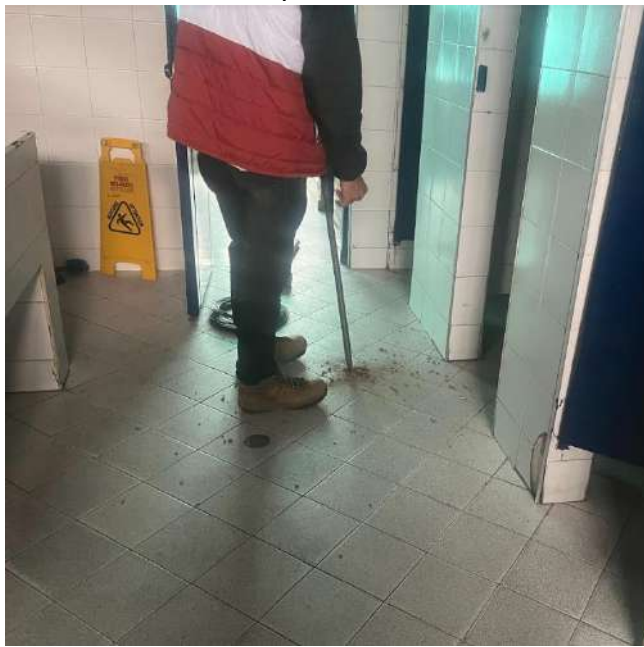
Imagen 28. Demolición acabado de Piso
