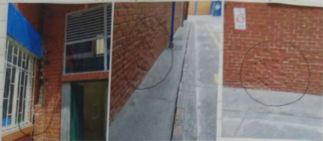
Estado actual Muros en Rampas edificio 2.
