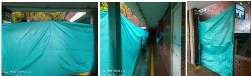
imagen 7. Cerramiento en área de circulación y trasiego interno desde áreas de desmonte de cubierta hasta acopio temporal
