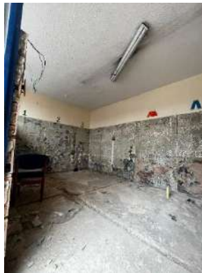
Imagen 3. Demolición muros en mampostería baños edificio 2
