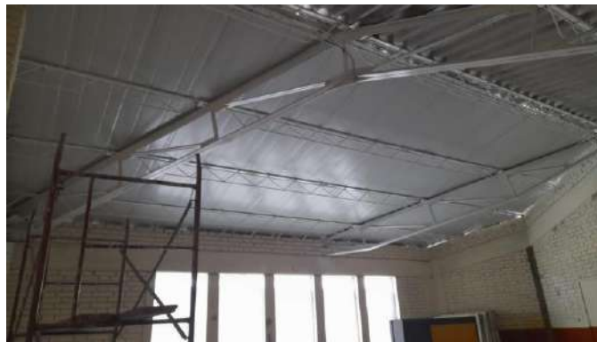
Imagen # Instalación cubierta modular tipo sándwich.
