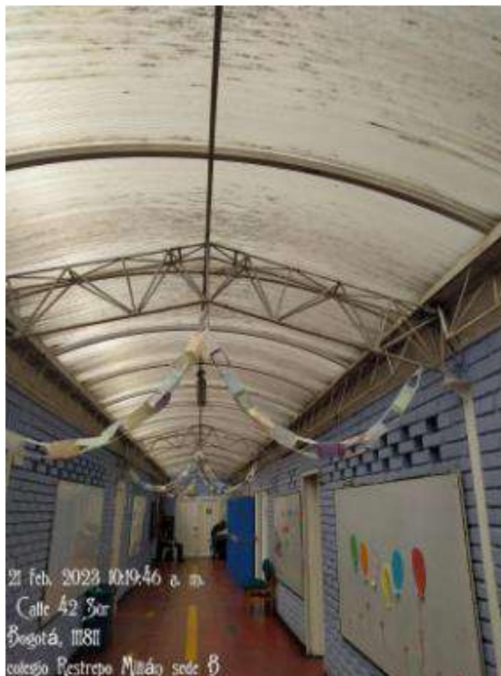
Imagen 6. Estructura soporte de domo en pasillo central.
