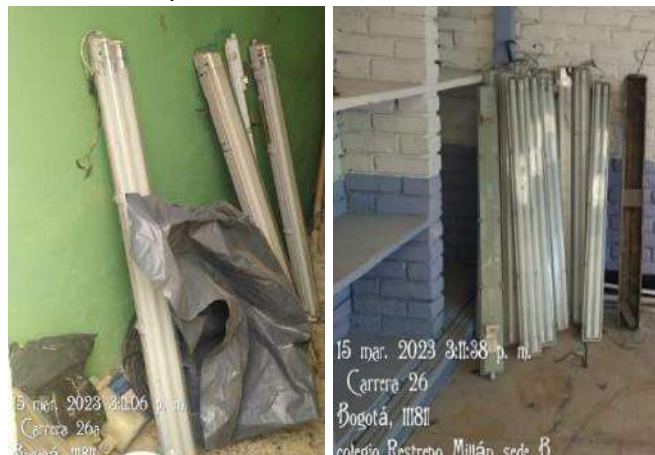
imagen 25. Desmonte de luminarias existentes en edificio 2, piso 1 Colegio Restrepo Millán Sede B Isabel II de Inglaterra
