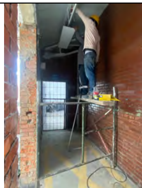
Instalación de luminarias
