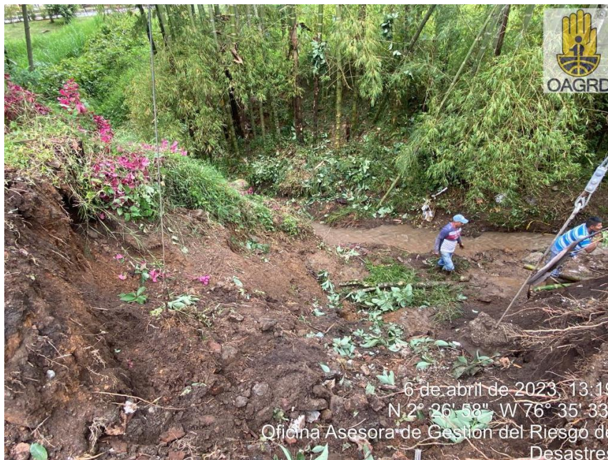
Fotografía No. 1 – Deslizamiento de tierra sobre la quebrada La Chirria. Fuente: Equipo de Trabajo OAGRDP
