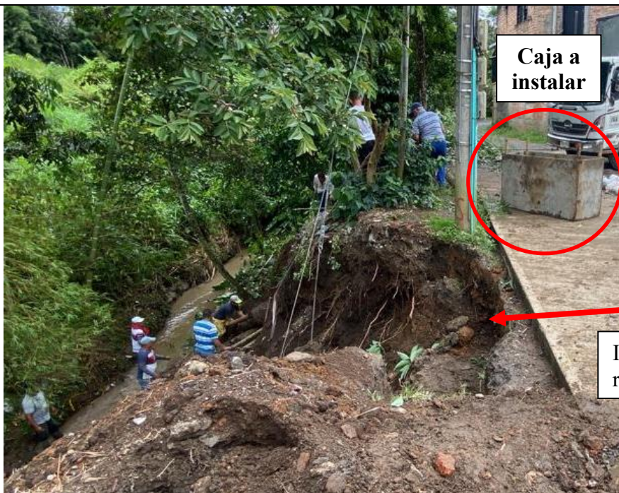
Fotografía No. 3 – Intervención y afectación de terreno.
