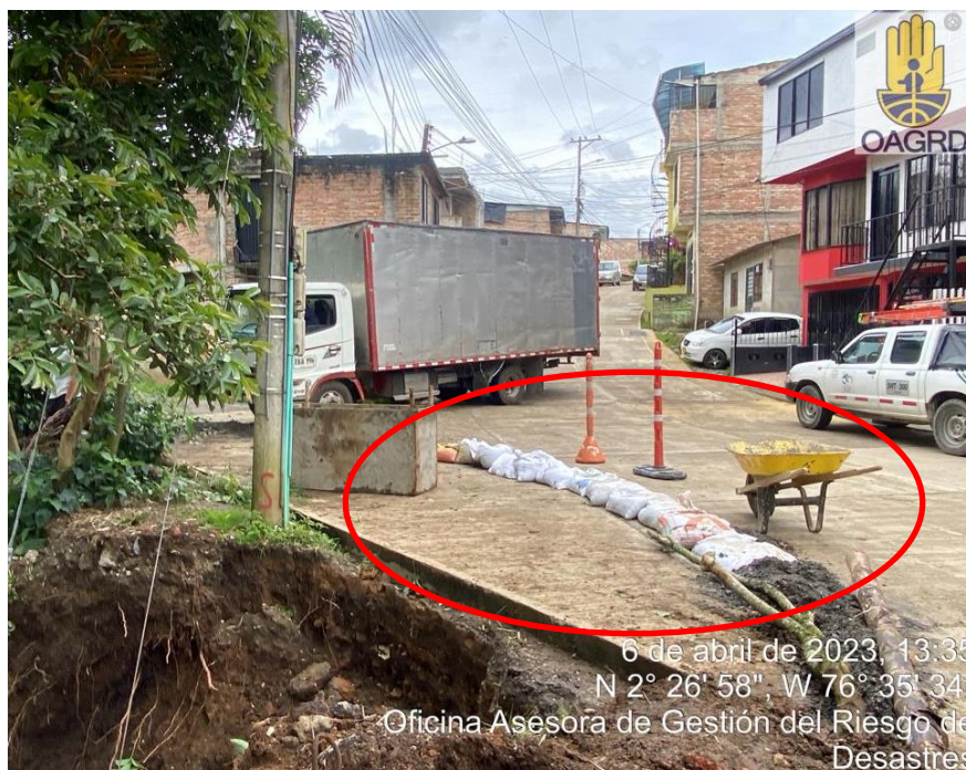
Fotografía No. 5 – Instalación de costalillas. Fuente: Equipo de Trabajo OAGRD
