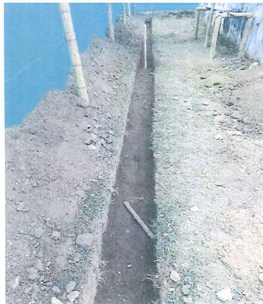
EXCAVACIONES PARA CERRAMIENTO PERIMETRAL
