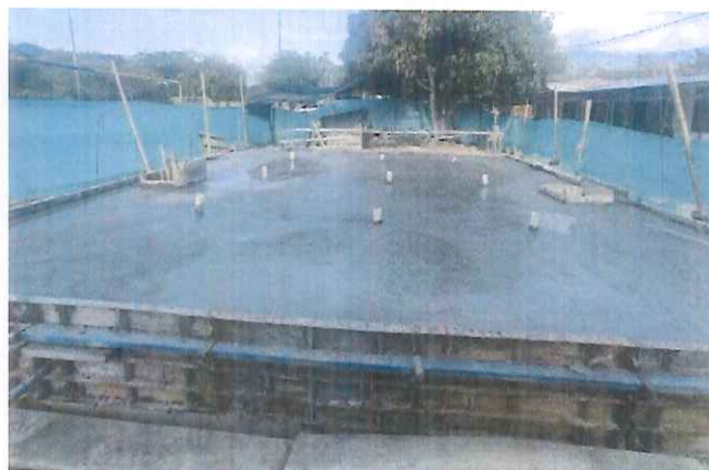
FUNDICION TANQUE DE ALMACENAMIENTO DE AGUA POTABLE
