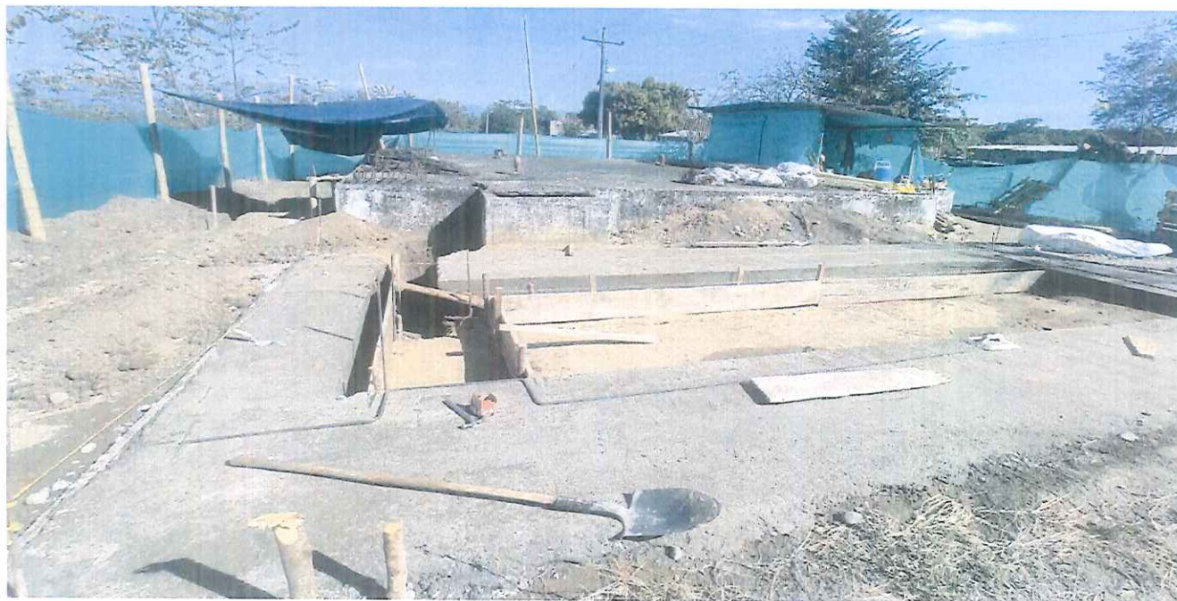
FUNDICION DE SOLADO PLACA DE SOPORTE DE LA PLANTA DE TRATAMIENTO DE AGUA POTABLE
