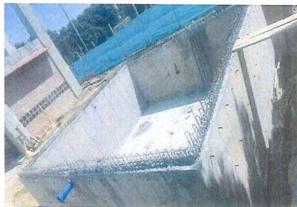
FUNDICION TANQUE DE ALMACENAMIENTO DE AGUA POTABLE
