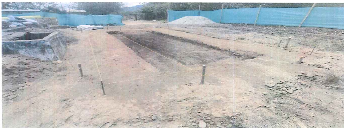
LOCALIZACION Y REPLANTEO
