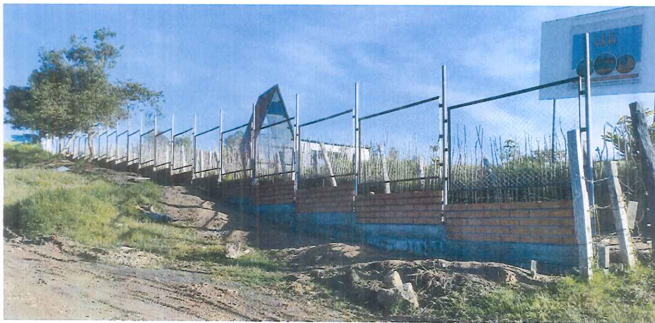
CERRAMIENTO PERIMETRAL DEFINITIVO
