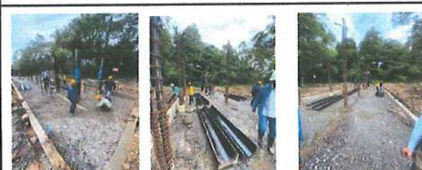
FOTO 25, 26 y 27 Construcción viga principal y aocplo de mamposteria en concreto pabellon de mamíferos
