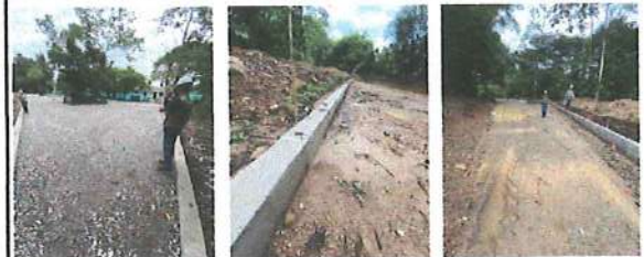
FOTO 40, 41 y 42 Construcción parqueaderos calle segunda
