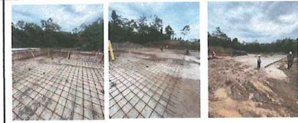
FOTO 16, 17 y 18 Construcción de sendero a nivel tipo 1, excavacion sardineles y relleno
