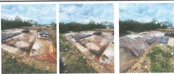
FOTO 7, 8 y 9 Detalle armadura de torta inferior placa de subpresion y vigas principales
