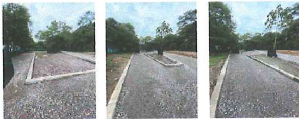
FOTO 37, 38 y 39 Construcción senderos calle segunda
