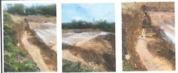
FOTO 10 y 11 Construcción de sendero a nivel tipo 1, excavación sardineles y relleno
