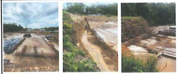
FOTO 10, 11 y 12 Detalle armadura de torta inferior placa de subpresion y vigas principales
