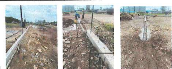
FOTO 19, 20 y 21 Armadura columnas circulares y formalelas area aprovechamiento economico
