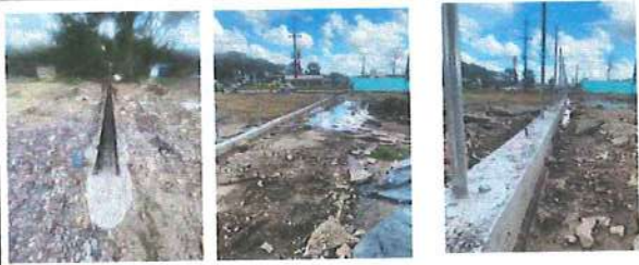
FOTO 12, 13 y 14 Construcción zapatas, viga de cimentación y refuerzo columnas área aprovechamiento económico
