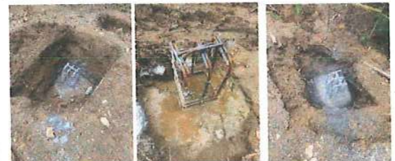
FOTO 20, 21 y 22 Construcción de zapatas sendero tipo 3, excavación y solados
