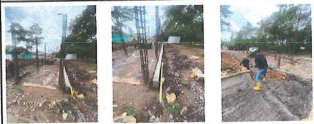
FOTO 18 y 19 Construcción zapatas y cerramiento pabellón de mamíferos
