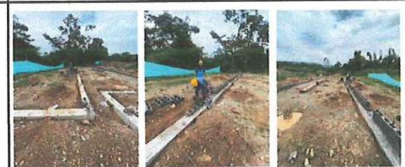
FOTO 28, 29 y 30 Construcción de zapatas sendero tipo 3 armadura de pedestales
