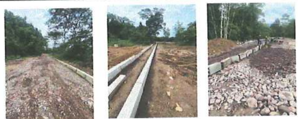
FOTO 23, 24 y 25 Construcción senderos calle segunda, excavación, sardineles y relleno
