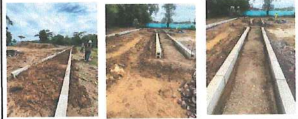
FOTO 46, 47 y 48 Excavacion y solados punete en copncreto tipo 1 caño rosablanca
