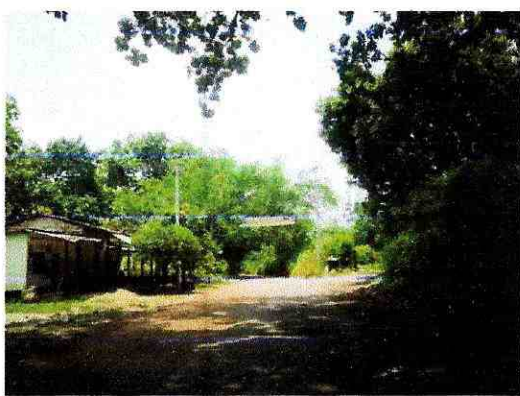
Figura 7. Panorama general de la vía.
