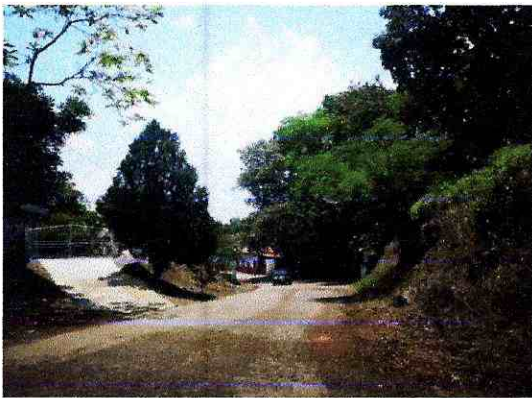
Figura 5. Panorama general de la vía.
