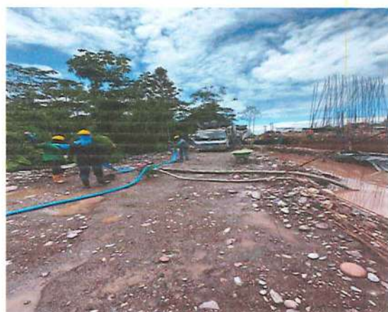
Manejo de aguas lluvia
