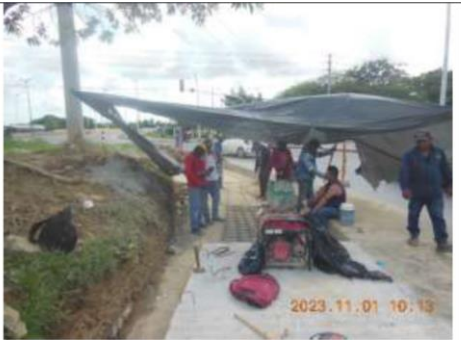
Supervisión de construcción del pavimento reforzado en el radio de giro para empalmar con Cll 30
