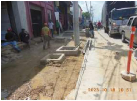
Supervisión de trabajos en el espacio público en Cile 30 entre Cra 29 y 30 oriental
