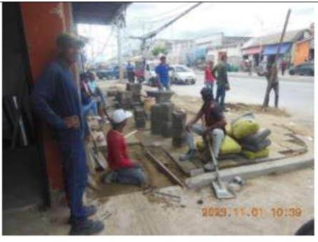
Supervisión de la instalación de losetas en el espacio público entre Cra 29 y 30 oriental
