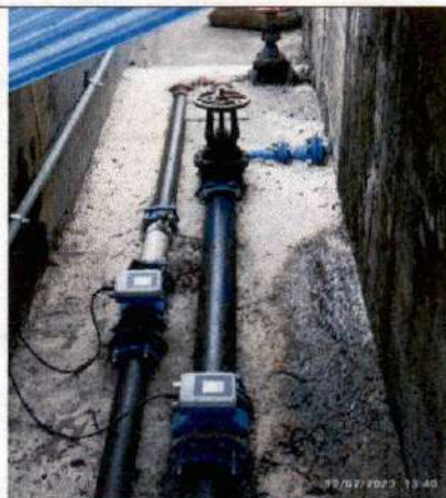
Fotografía 22. Accesorios, macromedidores y tuberías de salida del tanque Villa Vanegas- La Floresta
