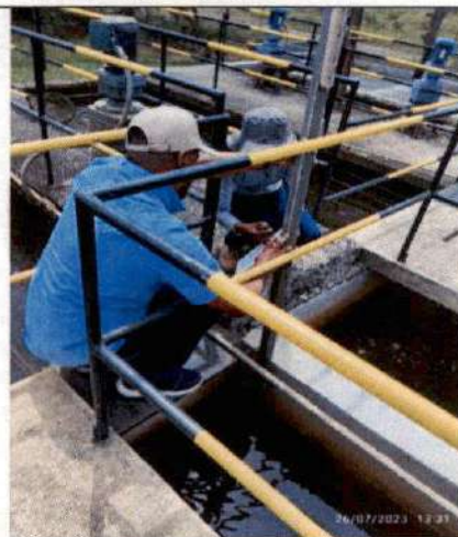
Fotografía 28. Toma de niveles en Floculadores PTAP Guacarí
