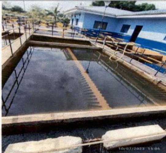
Fotografía 17. Linea 1 de sedimentación a optimizar en la PTAP de Guacarí. Verificación de medidas
