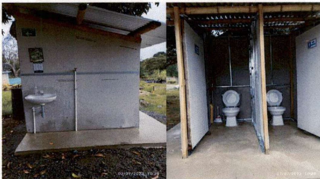
Ilustración 13 Orden y aseo en bodega, baños y oficinas
