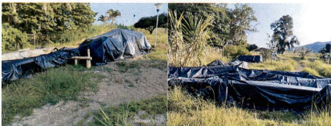
Ilustración 16 Cubrimiento y aislamiento de acero de refuerzo
