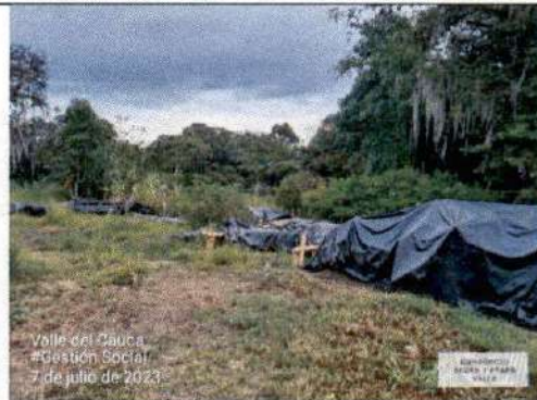
Fotografía 12. Se chequea que todo el acero se encuentre adecuadamente protegido para que no se deteriore con las condiciones climáticas de la zona.
