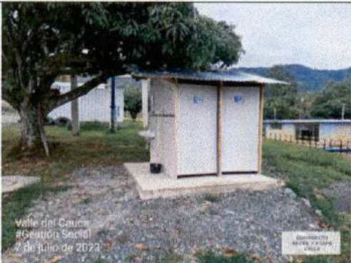
Fotografía 11. Se hace jornada de limpieza en las baterías sanitarias y se señalizan adecuadamente.
