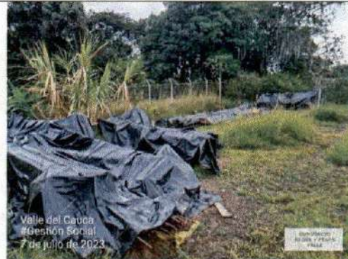
Fotografía 10. Se chequea que todo el acero se encuentre adecuadamente protegido para que no se deteriore con las condiciones climáticas de la zona.
