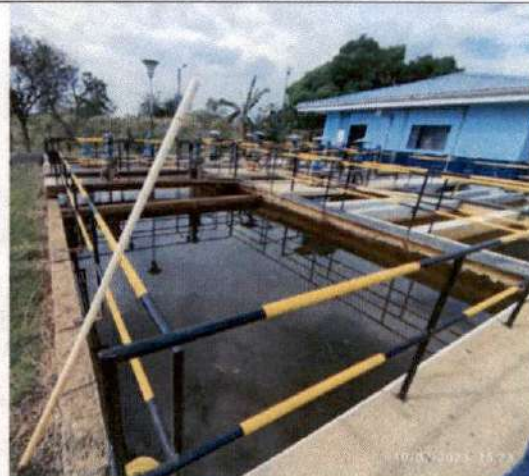
Fotografía 16. Linea 3 de floculación a optimizar en la PTAP de Guacarí. Verificación de medidas
