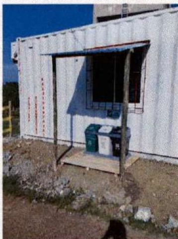
Ilustración 14 Punto ecológico obra
