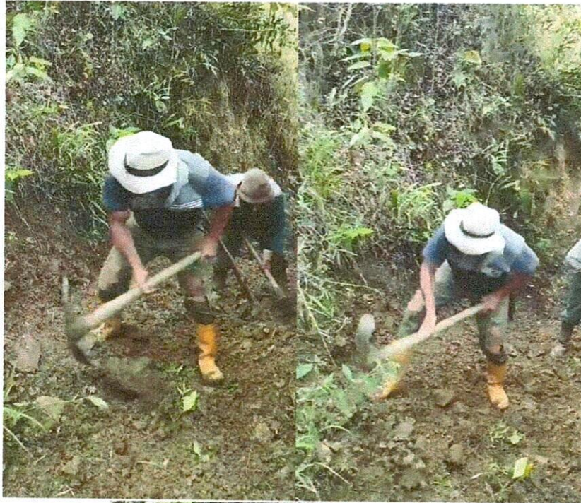
Camino Piedra Gorda Las Tarazonas Finca Acueducto
