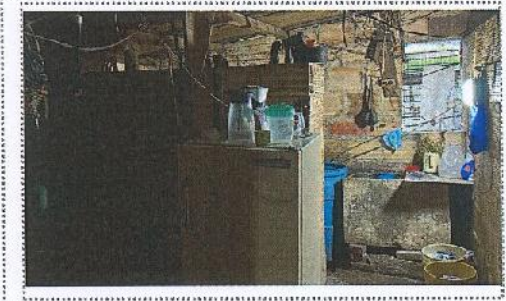
CUBIERTA - ZONA DE LAVADO
