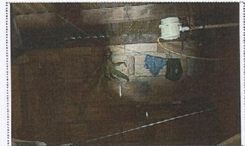
CUBIERTA ZONA DE BAÑO
