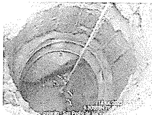
Figura 2: Bloque de roca en pared de pila
