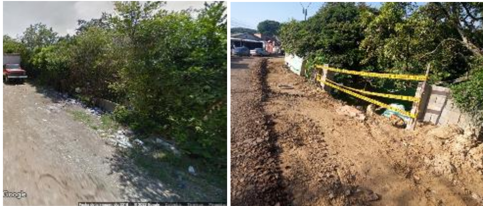
Ilustración 2 Estado antes y después de intervención cerramiento estación de bombeo
