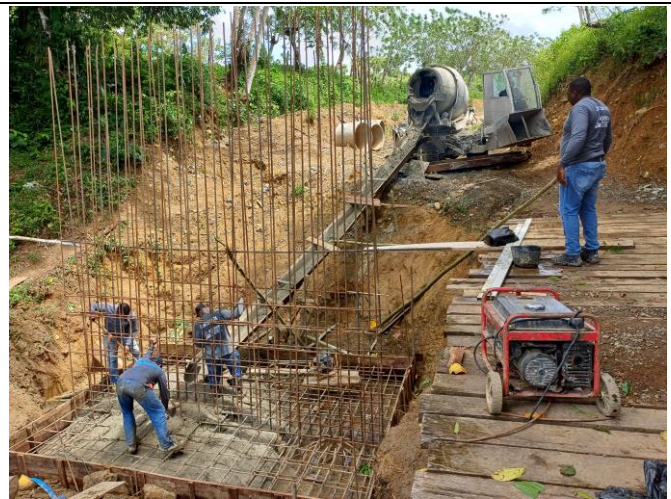
Foto No. 16. Instalación de concreto para zapata
