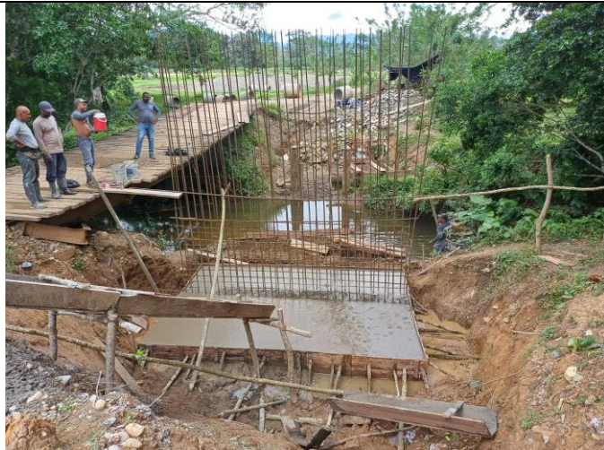
Foto No. 19. Zapata lado norte del puente sobre el rio capitán
