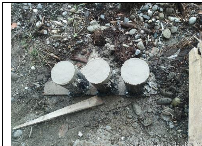
Foto No. 45. Toma de muestras de concreto.
