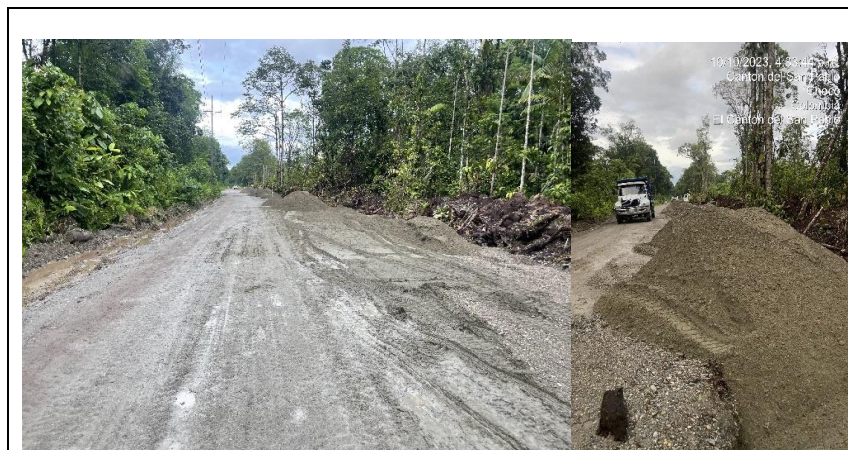
Foto No. 11. Lleno con material seleccionado y compactado del mismo.
