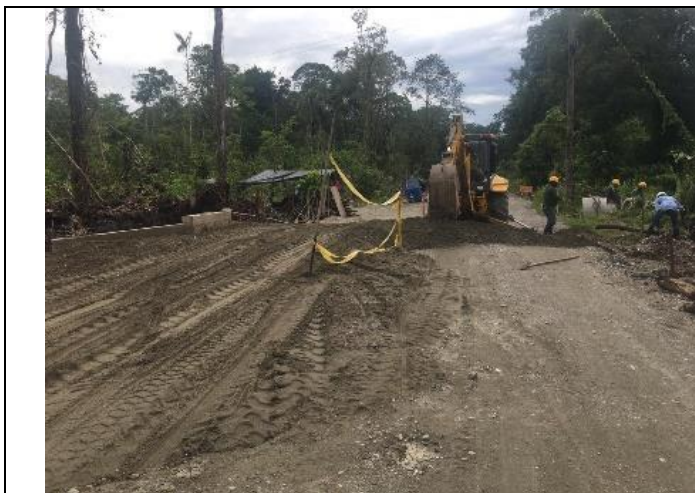
Foto No. 51. Construcción de Alcantarilla excavación mecánica.
