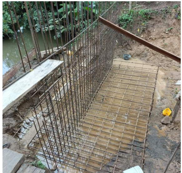
Foto No. 10. Instalación de acero para zapata
