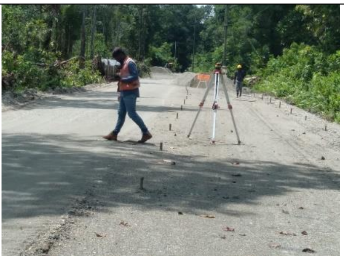
Foto No. 60 Instalación de la Sub-base granular clase A y nivelación topográfica.
