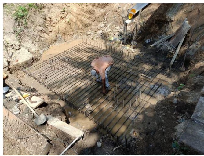
Foto No. 6. Instalación de acero
