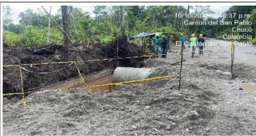
Foto No. 20. Construcción de Alcantarilla instalación de acero.
