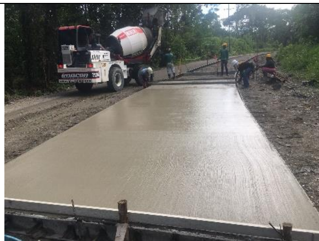
Foto No. 42. Pavimentos en concreto hidráulico MR -42.
