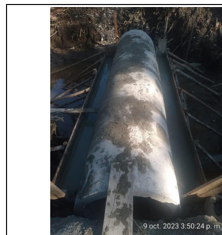
Foto No. 19. Construcción de Alcantarilla atraque de tubería.
