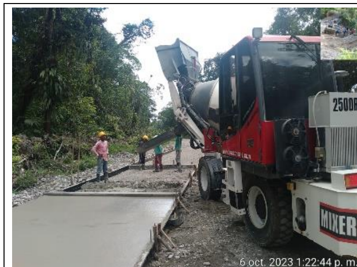
Foto No. 5. Pavimentos en concreto hidráulico MR -42.
