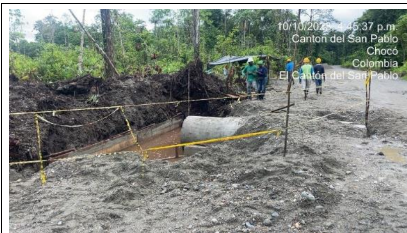
Foto No. 21. Construcción de Alcantarilla instalación de acero.
