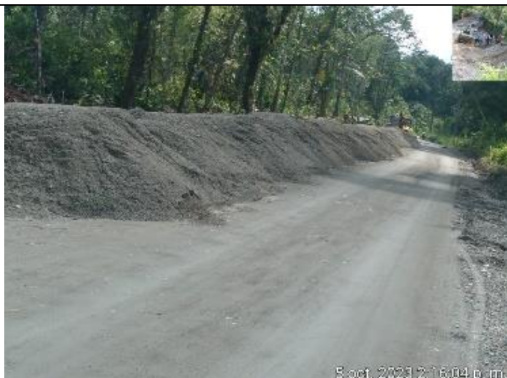
Foto No. 10. Acopio de material de cantera.
