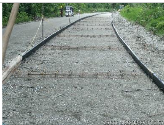
Foto No. 48. Formateado para pavimentos en concreto hidráulico e instalación de acero.
