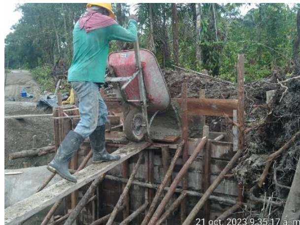
Foto No. 44. Construcción de Alcantarilla fundición de concreto para muro y aletas.
