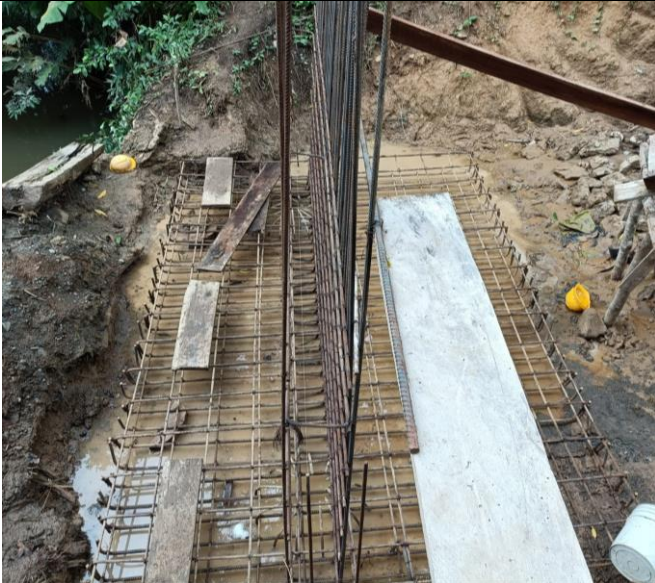
Foto No. 9. Instalación de acero para zapata
