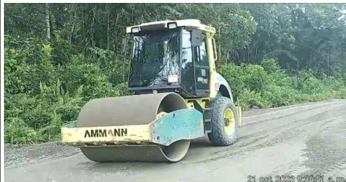
Foto No. 37. Instalación de la Sub-base granular clase A.
