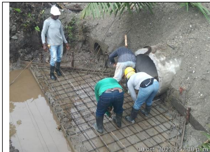
Foto No. 55. Construcción de Alcantarilla instalación de acero.
