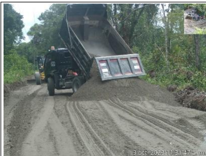
Foto No. 9. Lleno con material seleccionado y compactado del mismo.
