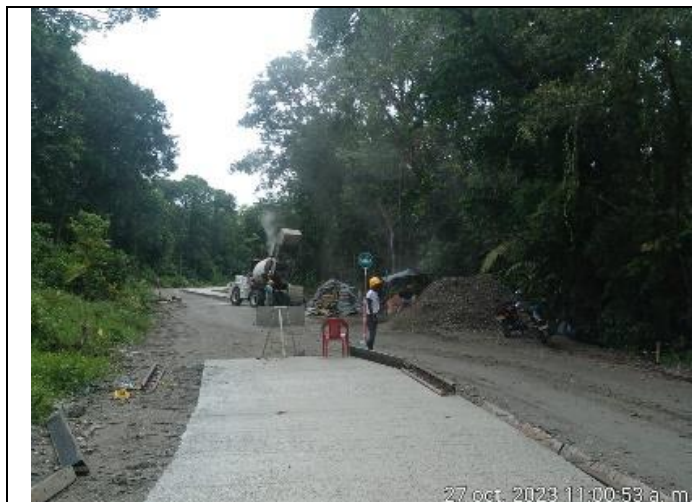
Foto No. 57. Pavimentos en concreto hidráulico MR -42..
