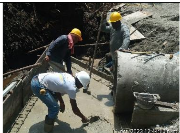
Foto No. 14. Construcción de Alcantarilla fundición de loza piso.
