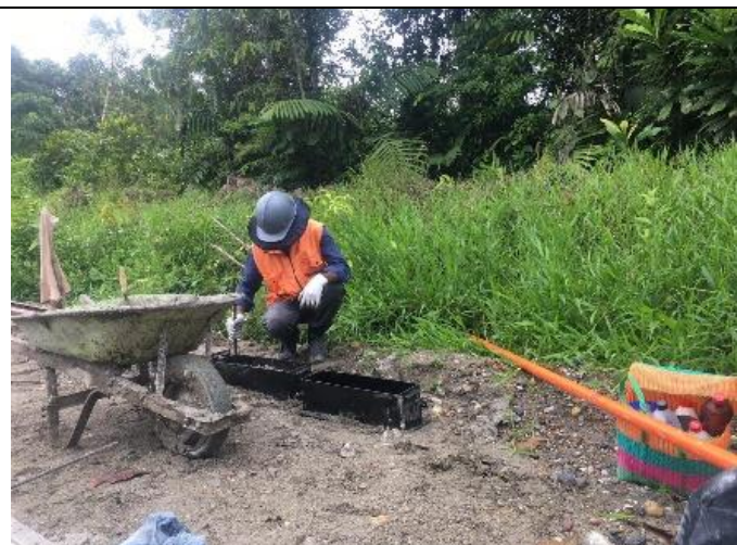
Foto No. 58 Toma de muestras de concreto hidráulico MR -42.
