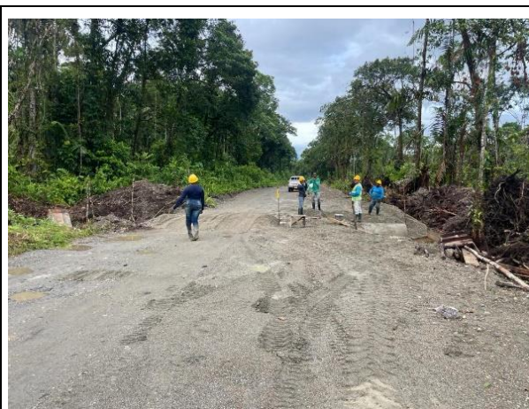
Foto No. 22. Construcción de Alcantarilla instalación de acero.
