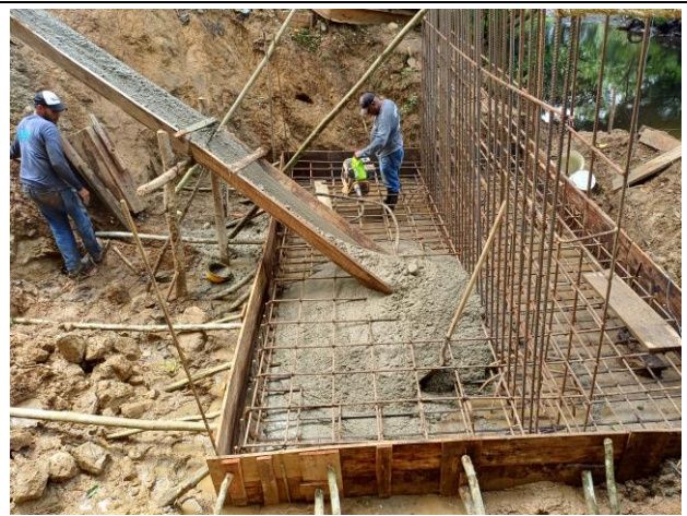
Foto No. 12. Concreto para zapata
