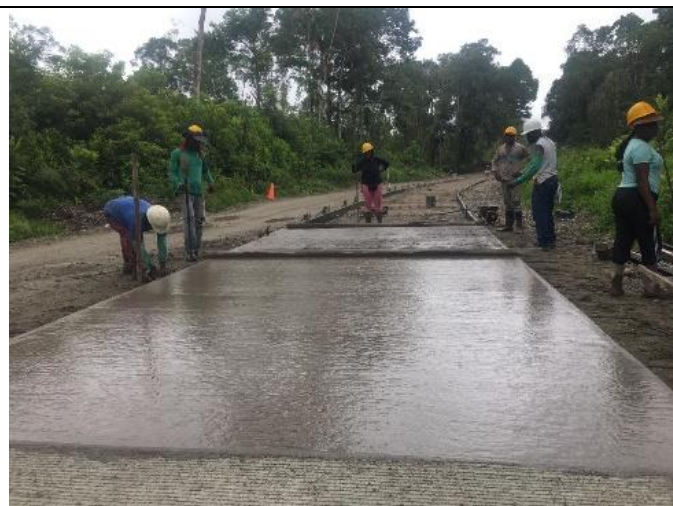
Foto No. 56. Pavimentos en concreto hidráulico MR -42.
