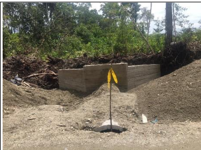
Foto No. 50. Construcción de Alcantarilla lleno compactado.
