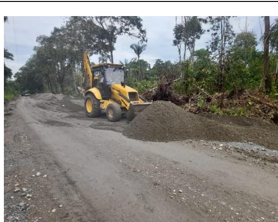
Foto No. 1 Cajeo y lleno compactado del mismo.
