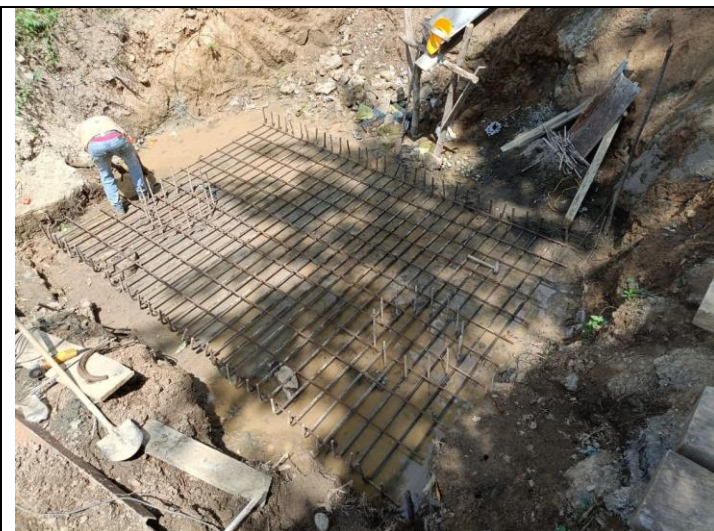
Foto No. 7. Instalación de acero parilla inferior de la zapata
