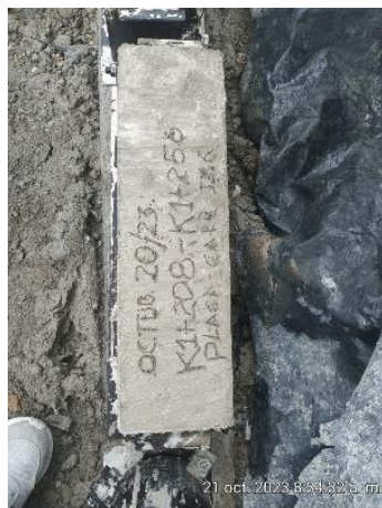
Foto No. 43. Toma de muestras de concreto hidráulico MR -42.
