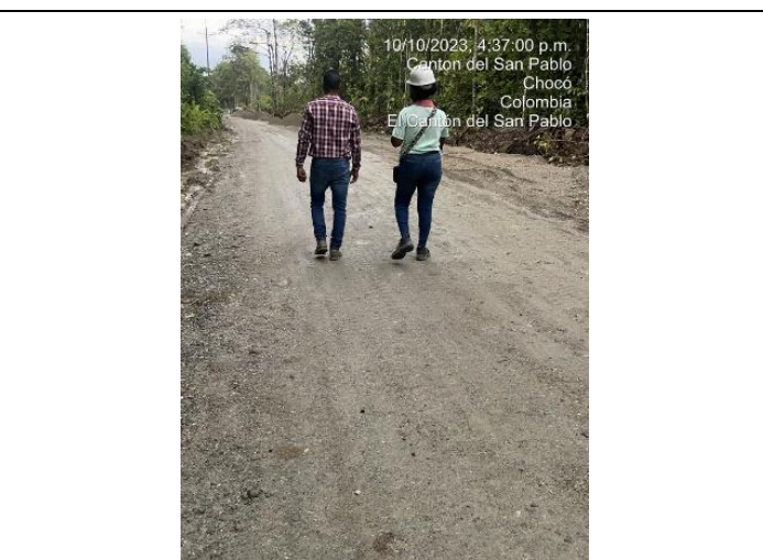
Foto No. 16. Instalación de la Sub-base granular clase A.
