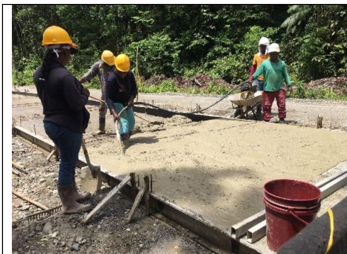
Foto No. 13. Pavimentos en concreto hidráulico MR –42.
