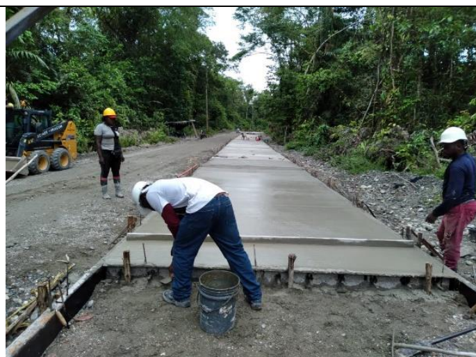
Foto No. 8. Pavimentos en concreto hidráulico MR -42.
