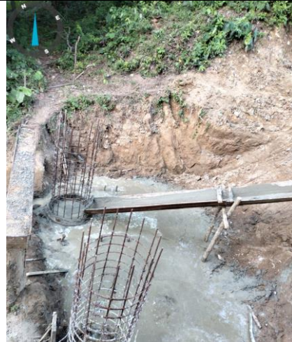
Foto No. 2. Concreto para pila de cimentación
