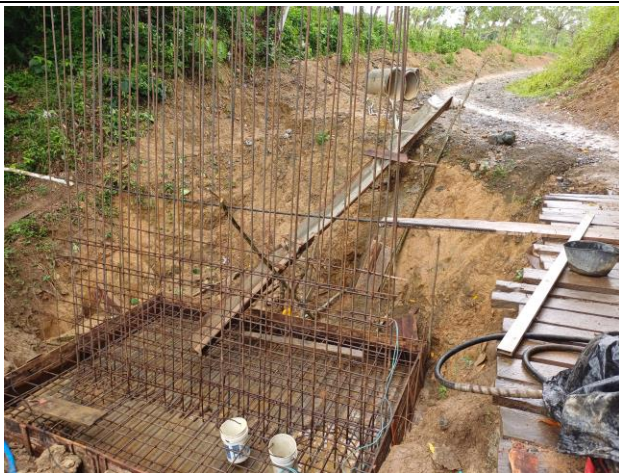
Foto No. 11. Limpieza de acero
