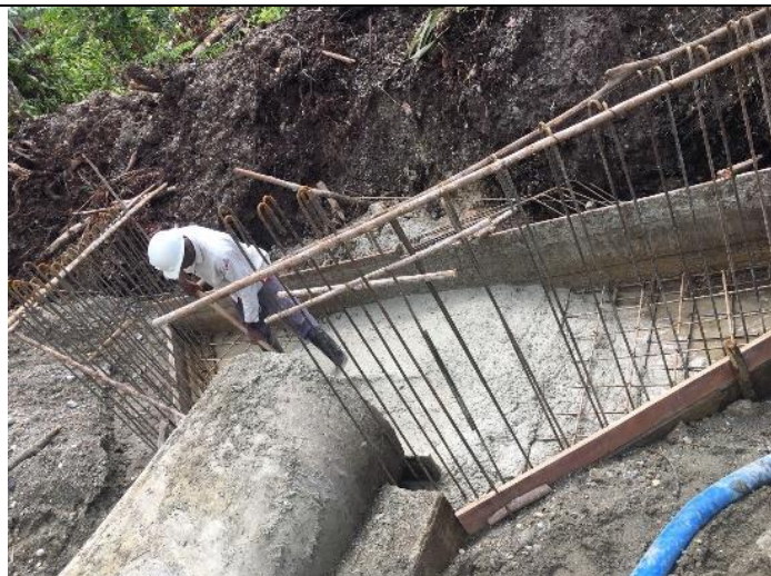
Foto No. 30. Construcción de alcantarilla.
