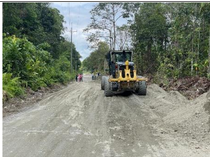
Foto No. 29. Lleno con material seleccionado y compactado del mismo e Instalación de la Sub-base granular clase A.
