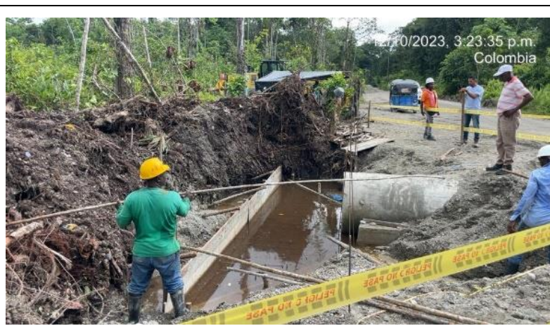
Foto No. 32. Construcción de alcantarilla.
