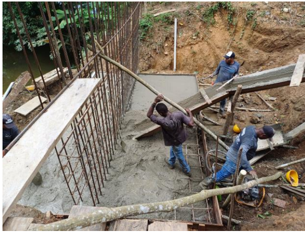
Foto No. 17. Instalación de concreto para zapata
