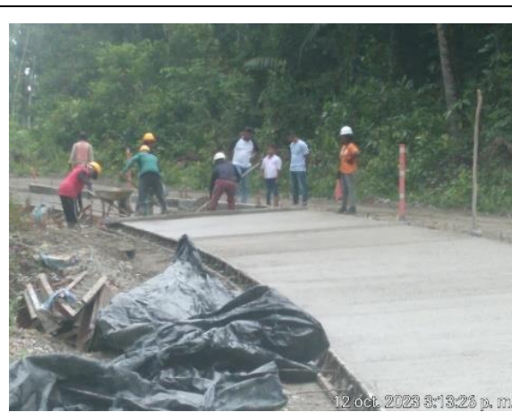
Foto No. 24. Pavimentos en concreto hidráulico MR -42.
