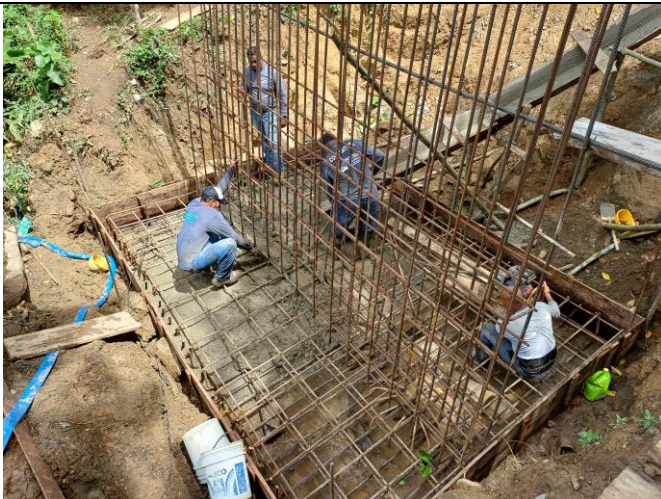
Foto No. 15. Vaciado de concreto para zapata
