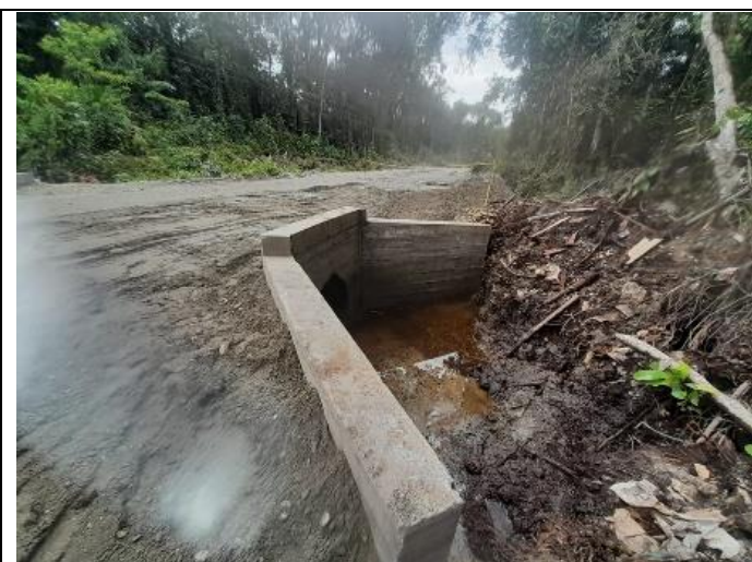
Foto No. 7 Lleno con material seleccionado y compactado del mismo.
