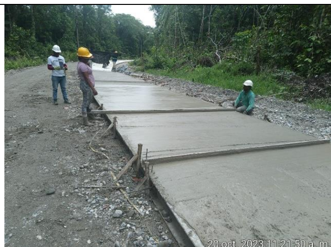
Foto No. 34. Pavimentos en concreto hidráulico MR –42.
