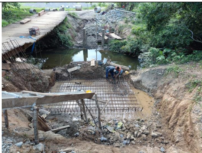
Foto No. 8. Instalación de acero para zapata
