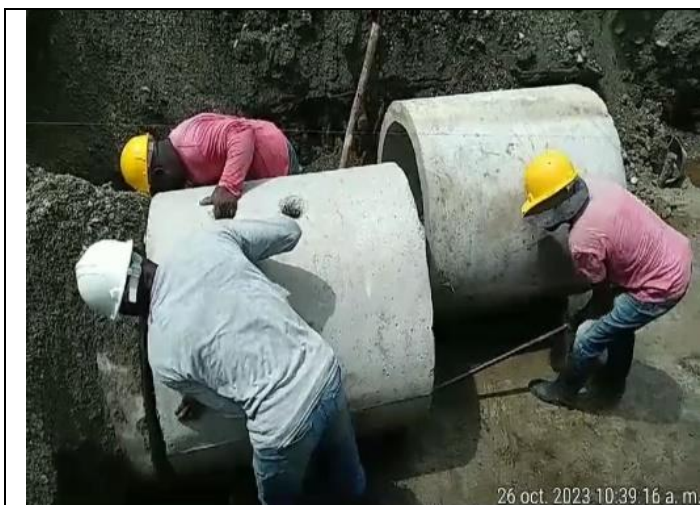
Foto No. 17. Construcción de Alcantarilla instalación de tubería.
