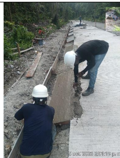
Foto No. 6 Pavimentos en concreto hidráulico MR -42.
