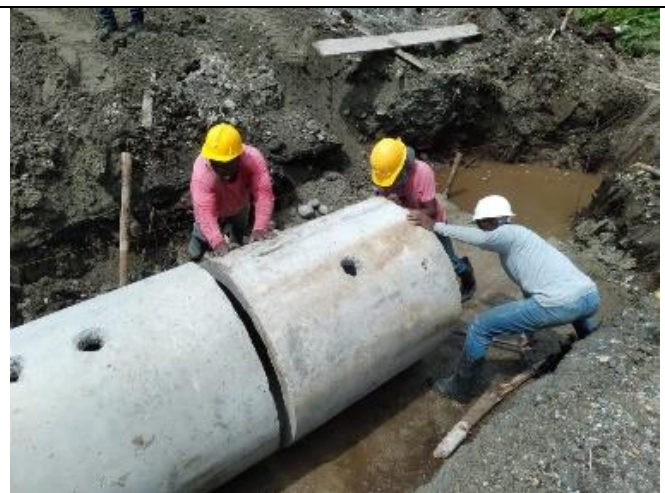
Foto No. 52. Construcción de Alcantarilla instalación de tubería.
