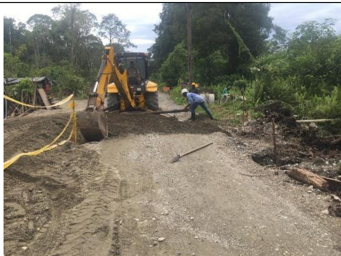
Foto No. 39. Construcción de Alcantarilla excavación mecánica.
