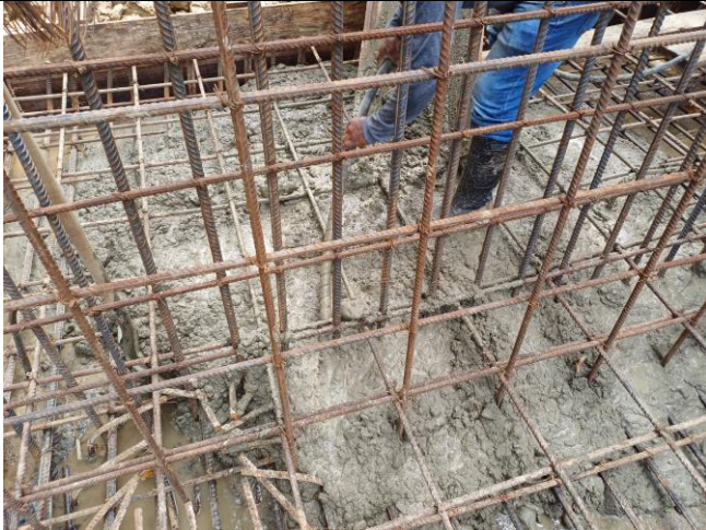
Foto No. 13. Vibrado del concreto
