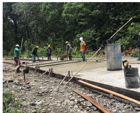
Foto No. 12. Pavimentos en concreto hidráulico MR -42.
