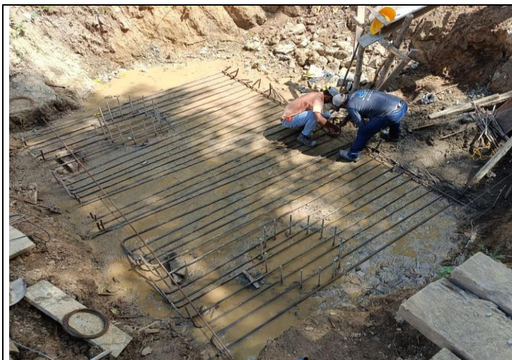
Foto No. 5. Instalación de acero
