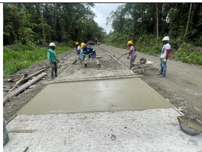
Foto No. 46. Pavimentos en concreto hidráulico MR -42.
