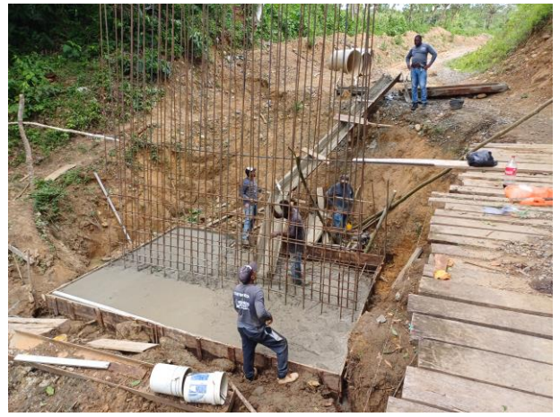
Foto No. 18. Instalación de concreto para zapata
