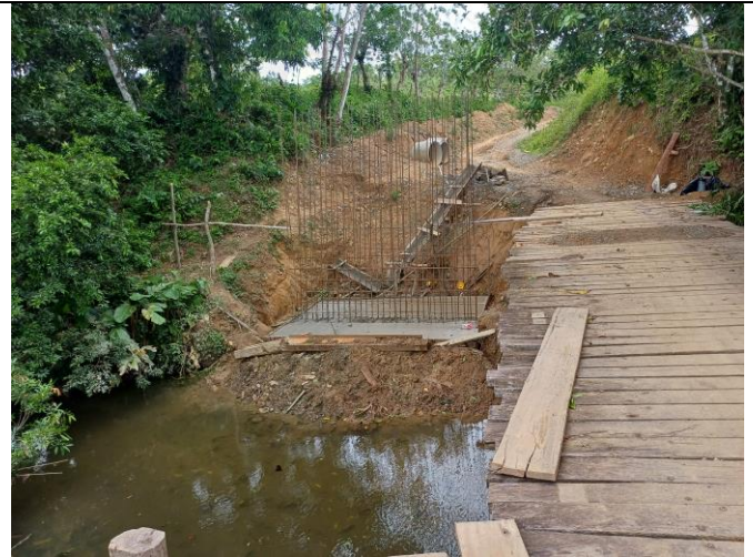
Foto No. 20. Zapata lado norte del puente capitán
