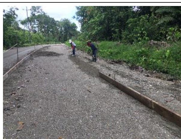
Foto No. 31. Formateado para pavimentos en concreto hidráulico.
