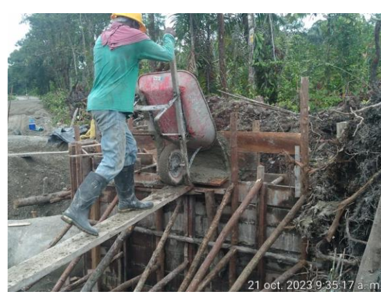
Foto No. 36. Construcción de alcantarilla.
