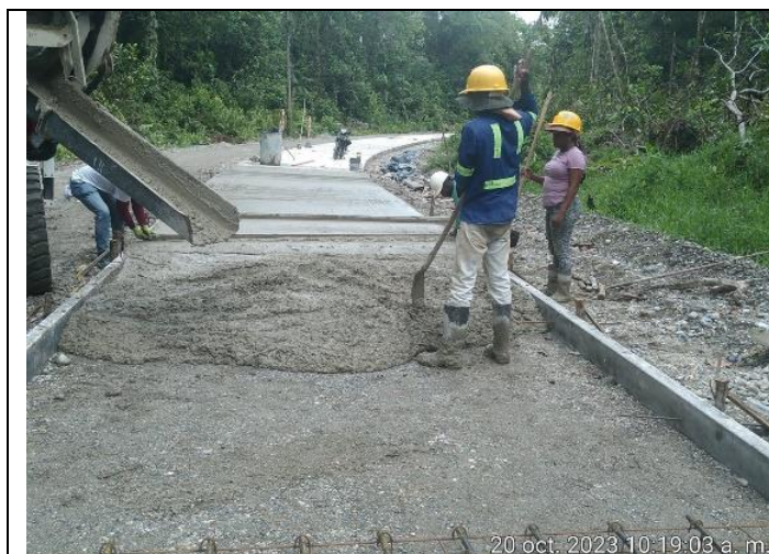
Foto No. 33. Pavimentos en concreto hidráulico MR –42.
