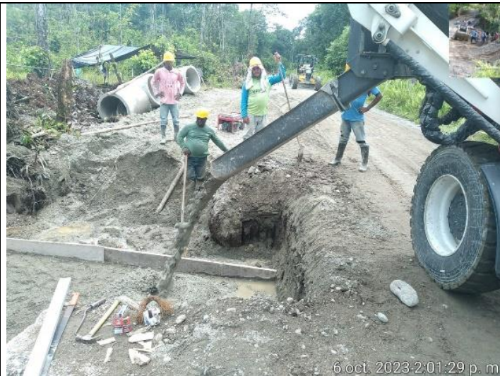
Foto No. 3 Construcción de Alcantarilla.
