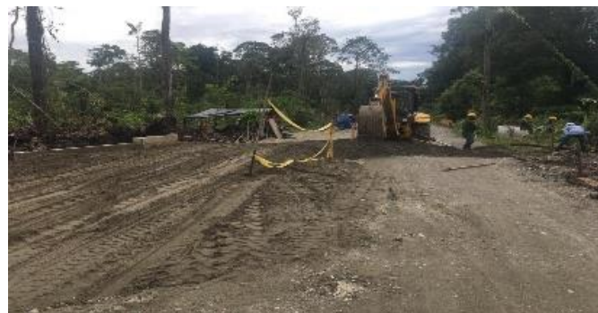
Foto No. 38. Construcción de Alcantarilla excavación mecánica.
