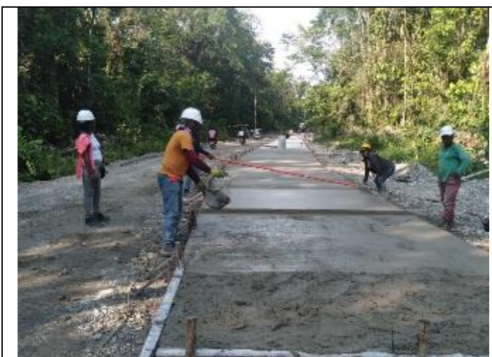
Foto No. 15. Pavimentos en concreto hidráulico MR –42.
