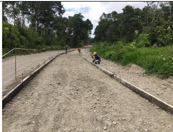
Foto No. 40. Formateado para pavimentos en concreto hidráulico.
