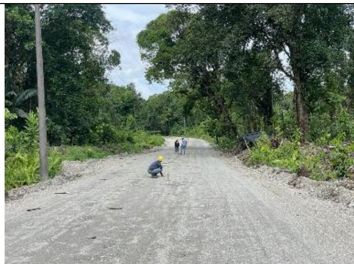
Foto No. 25. Instalación de la Sub-base granular clase A y nivelación topográfica.
