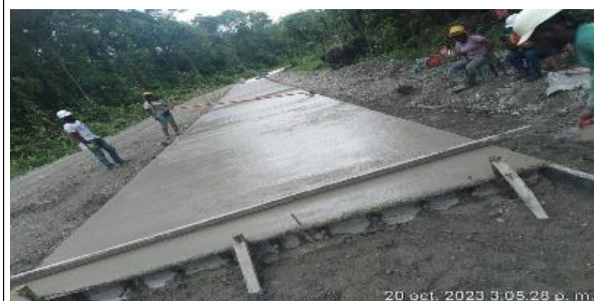
Foto No. 35. Pavimentos en concreto hidráulico MR –42.
