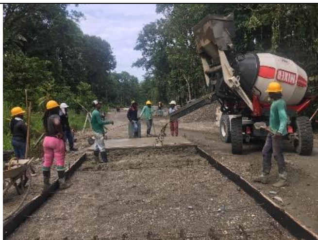
Foto No. 41 Pavimentos en concreto hidráulico MR -42.
