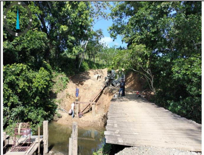
Foto No. 4. Instalación de concreto para pilas de cimentación
