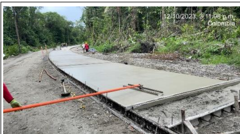
Foto No. 23. Pavimentos en concreto hidráulico MR -42.
