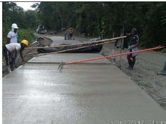
Foto No. 49. Pavimentos en concreto hidráulico MR -42.
