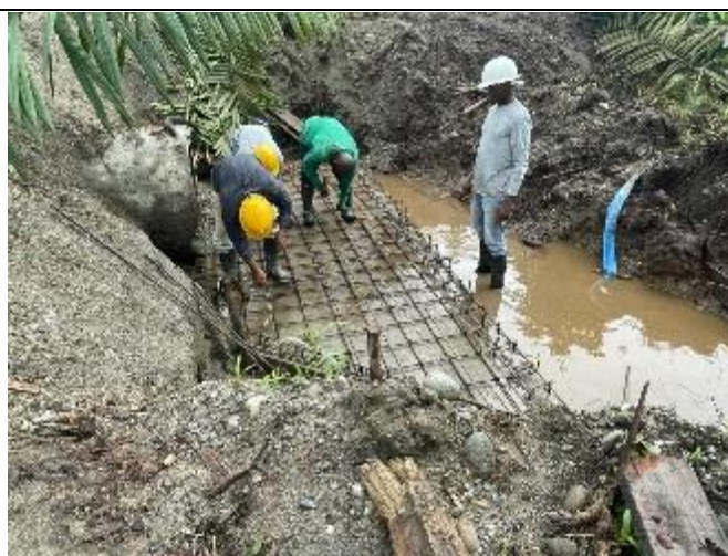
Foto No. 54. Construcción de Alcantarilla instalación de acero.
