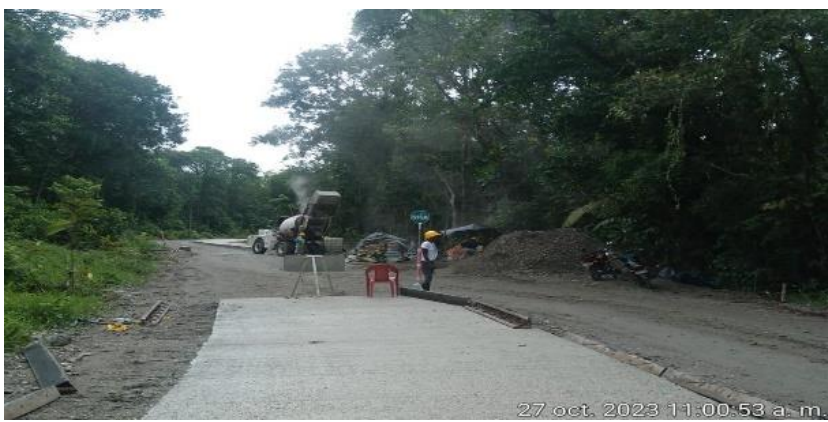
Foto No. 28. Pavimentos en concreto hidráulico MR -42.
