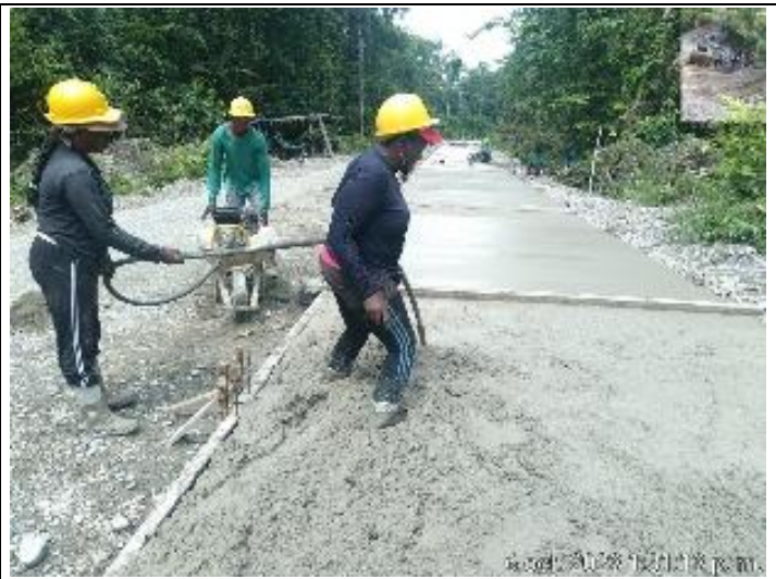
Foto No. 4. Pavimentos en concreto hidráulico MR -42.
