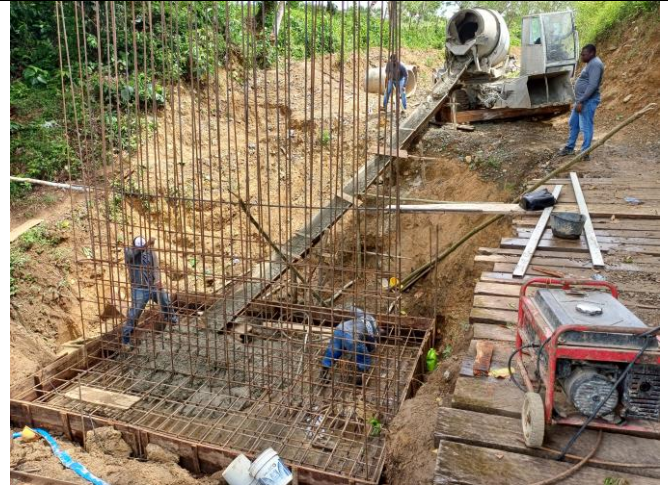
Foto No. 14. Instalación de concreto para zapata
