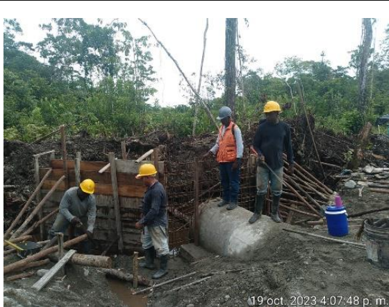
Foto No. 27. Construcción de alcantarilla instalación de formaletas.
