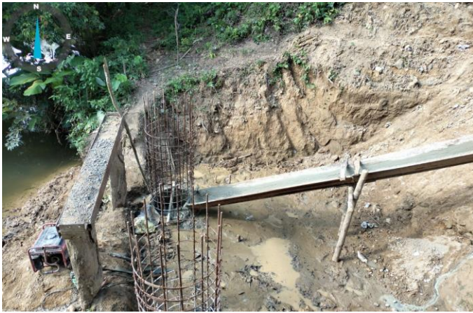
Foto No. 1. Concreto para pila de cimentación río capitán
