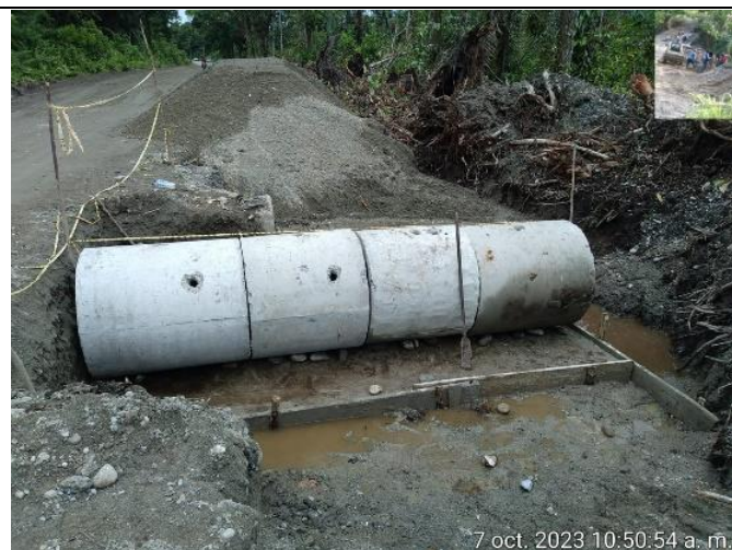
Foto No. 18. Construcción de Alcantarilla instalación de tubería.
