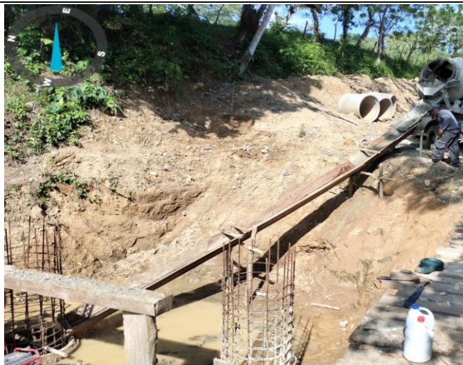
Foto No. 3. Concreto para pilas de cimentación
