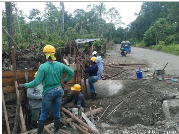
Foto No. 26. Construcción de alcantarilla instalación de formaletas.
