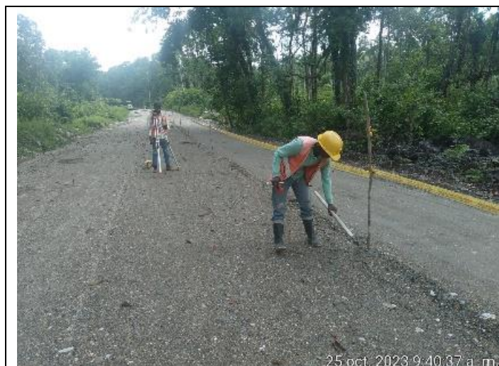
Foto No. 47. Instalación de la Sub-base granular clase A y nivelación topográfica.
