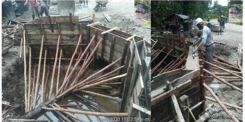
Foto No. 2 Construcción de Alcantarilla.
