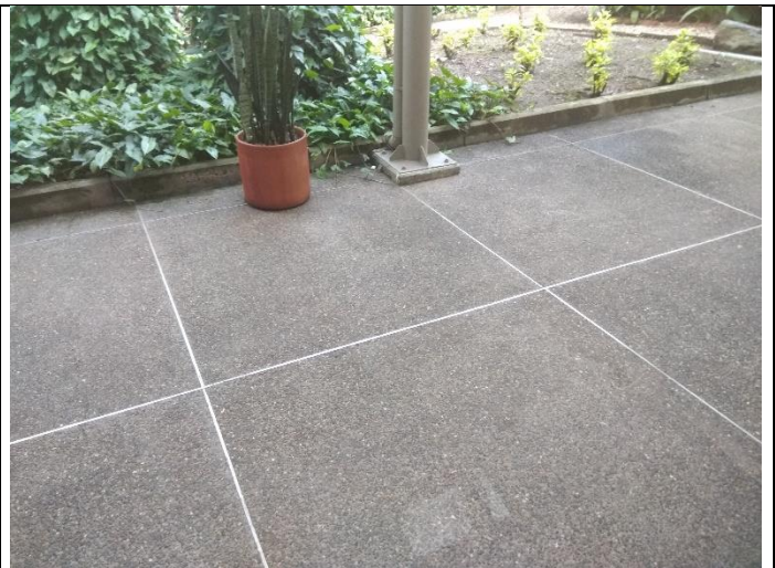
Foto No. 16 Vista general de los acabados de piso exteriores
