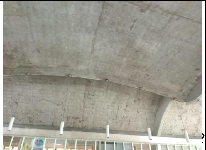
Foto No. 14 Vista general del acabado de la cubierta
