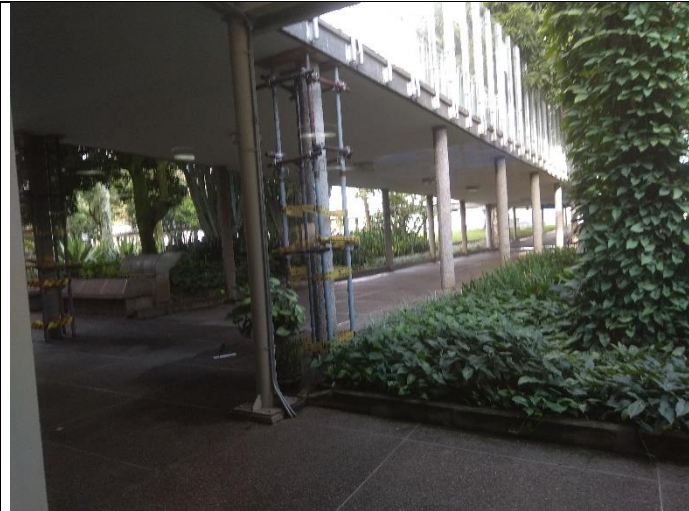
Foto No. 13 Vista general del corredor de servicios interior
