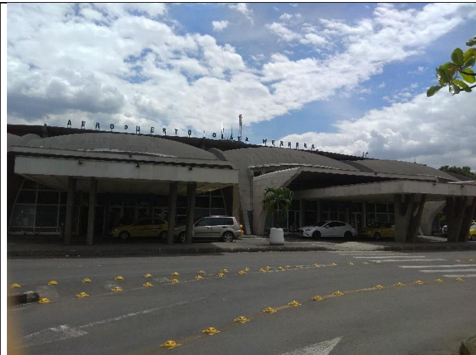
Foto No. 3 Vista de la fachada principal
