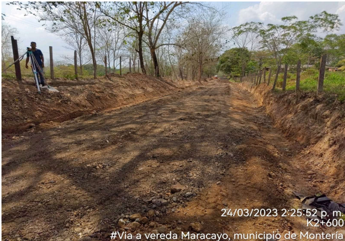
Se evidencia relleno con material de sub base en tramo N°02
