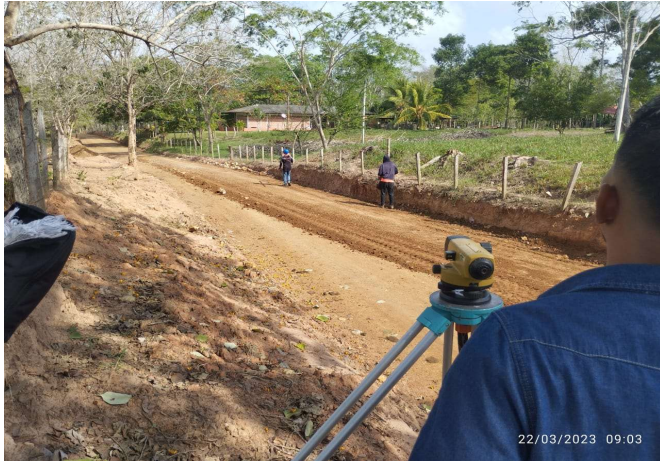
Se evidencia chequeo de niveles de relleno de sub base
