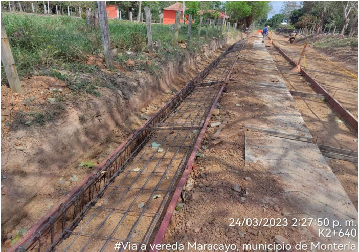
Se evidencia Instalacion de rieles y armado de acero de refuerzo.
