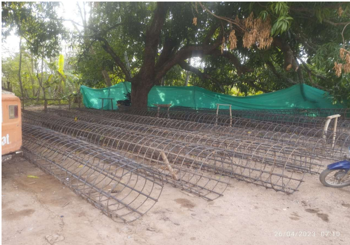
Se evidencia Armado de acero de refuerzo para pilotes del puente
