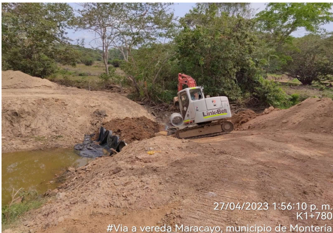
Se evidencia adecuacion de desvio para la construccion del puente
