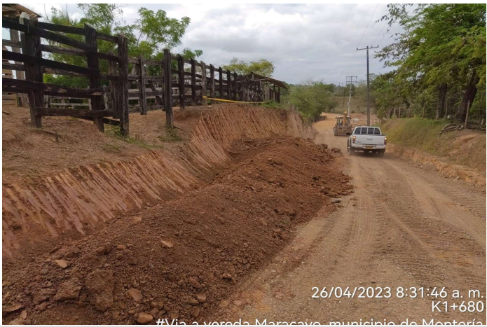
Se evidencia conformacion de taludes en tramo de via sobre la abscisa K1+680
