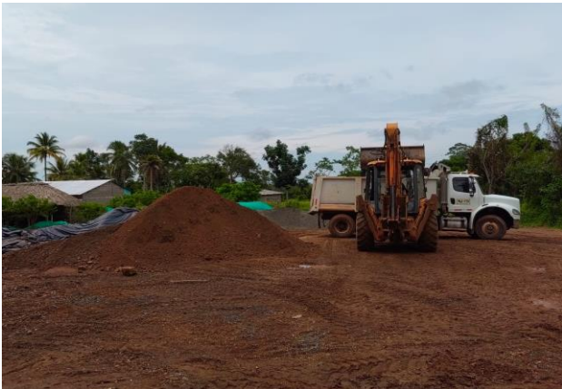
Se evidencia acarreo interno de material de sub base para relleno en tramo N°03
