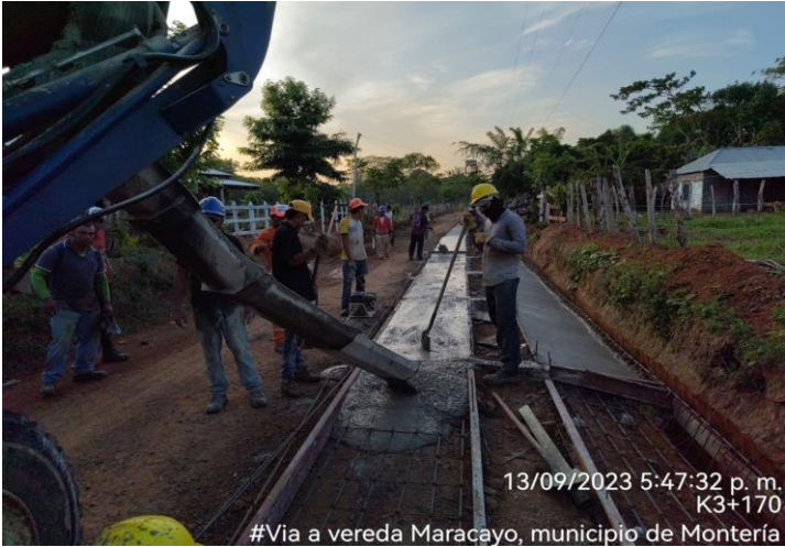
Se evidencia fundida de placa huella sobre el carril izq. En abscisa k3+170
