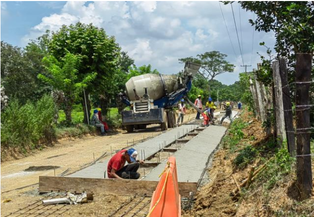
Se evidencia fundida de placa huella sobre el tramo N°03
