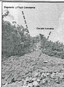
Fotografía 4: Derrumbe localizado en la Bocatoma Quebrada la Honda Fuente: EAAV ESP, 2023
