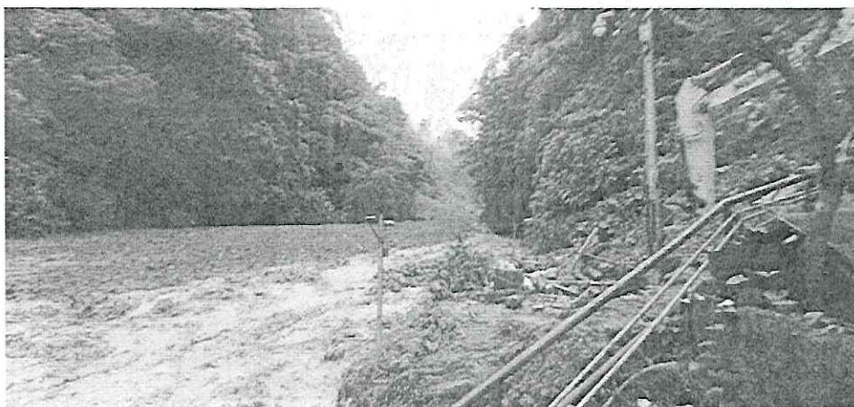
Taponamiento estructuras hidráulicas sector bocatoma quebrada la honda
