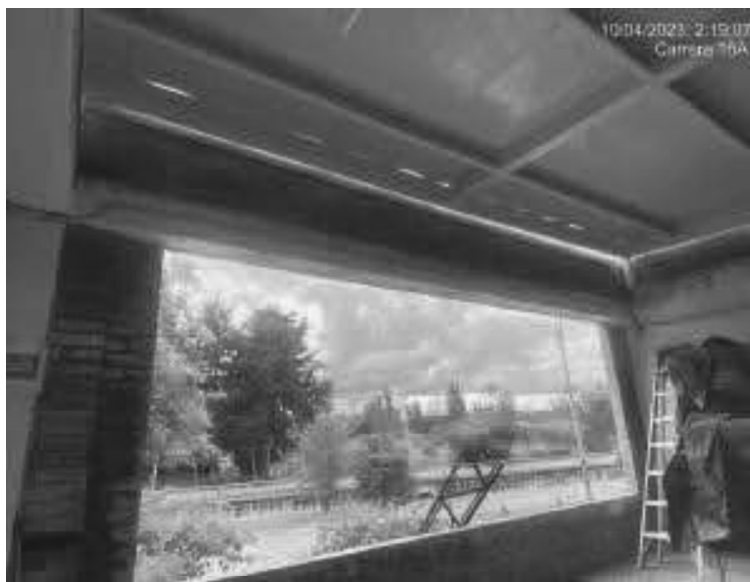
Pañete en el vano de las ventanas del segundo piso.
