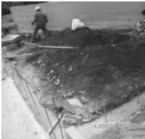
Vaciado de concreto para la viga de cimentación de la mampostería del acceso de estudiantes.
