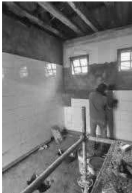
Instalación de Enchape en los piso y muros del baño del área administrativa.
