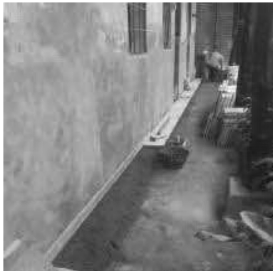
Instalación de piso en pasillo del área administrativa.
