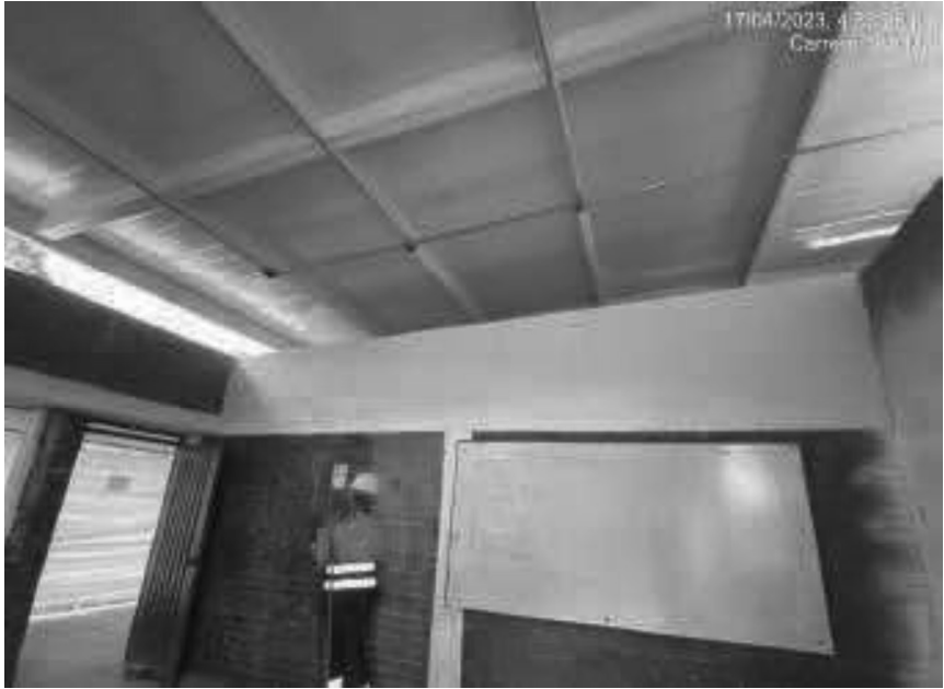
Instalación de tubería MT para salidas de iluminación.
