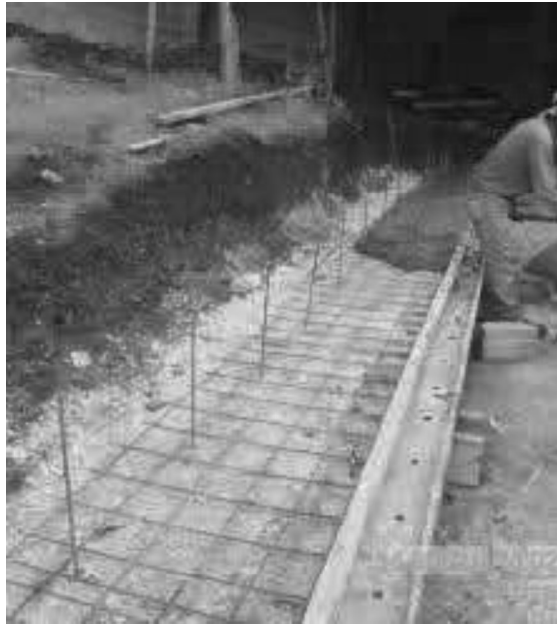
Instalación de malla electrosoldada y vaciado de concreto en la rampa de acceso de la zona de juegos
