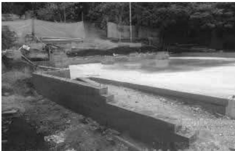
Muro en mampostería en el perímetro de la zona de juegos.
