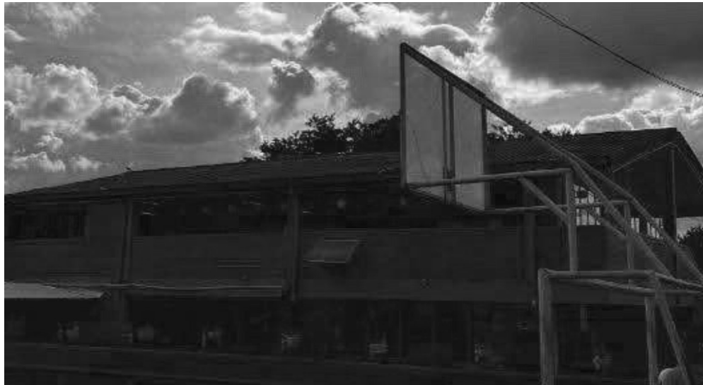
Estado actual de las cubiertas
