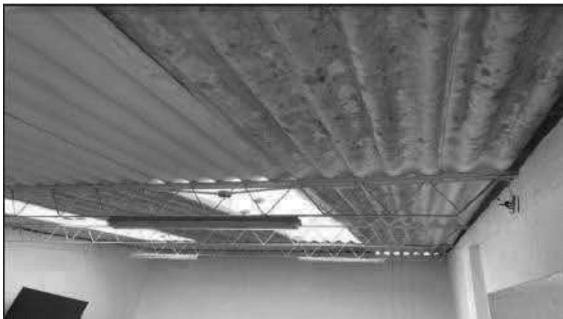
Estado actual de las cubiertas
