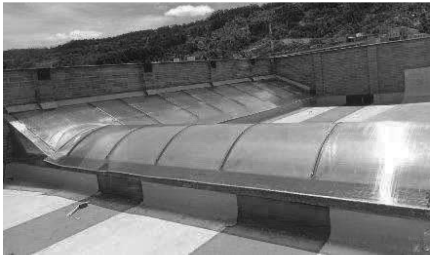
Instalacion del nuevo policarbonato en cubiertas
