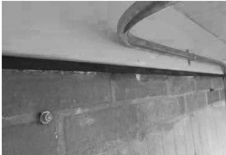
Remates con pañete entre muro y la estructura metálica de la cubierta.
