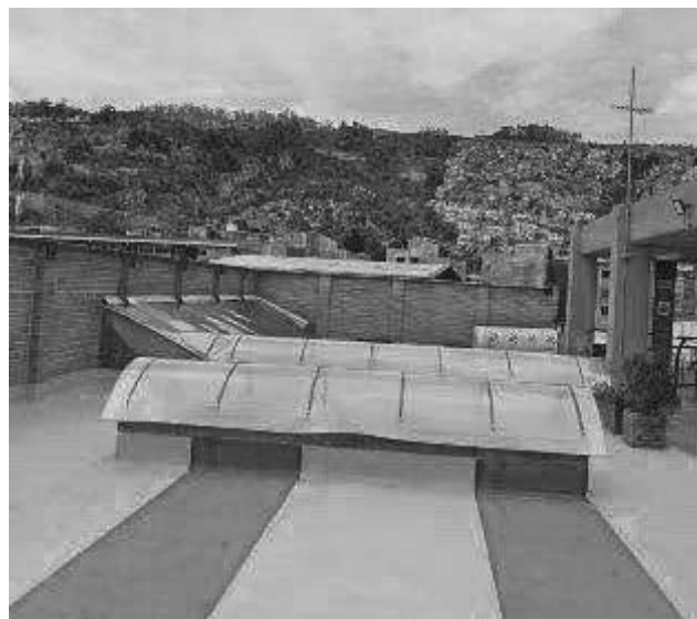
Impermeabilizacion de cubierta terrazas con poliurea.
