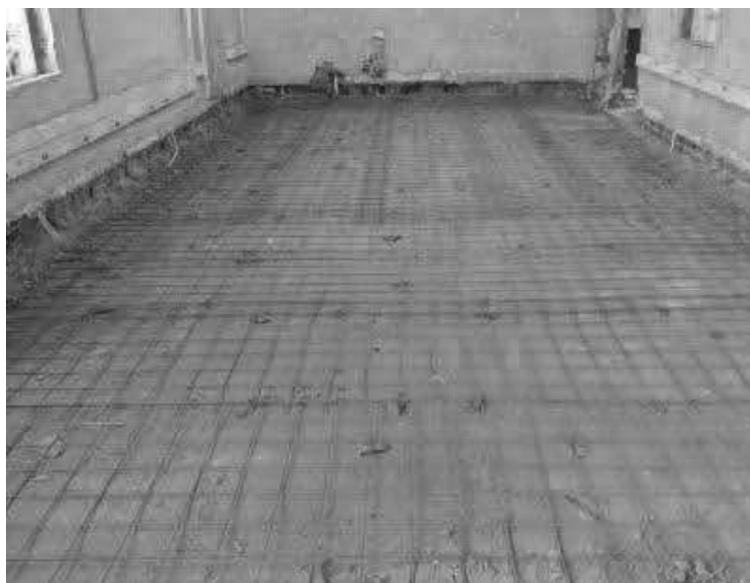
Instalación de la malla para la placa de piso del aula de informática.
