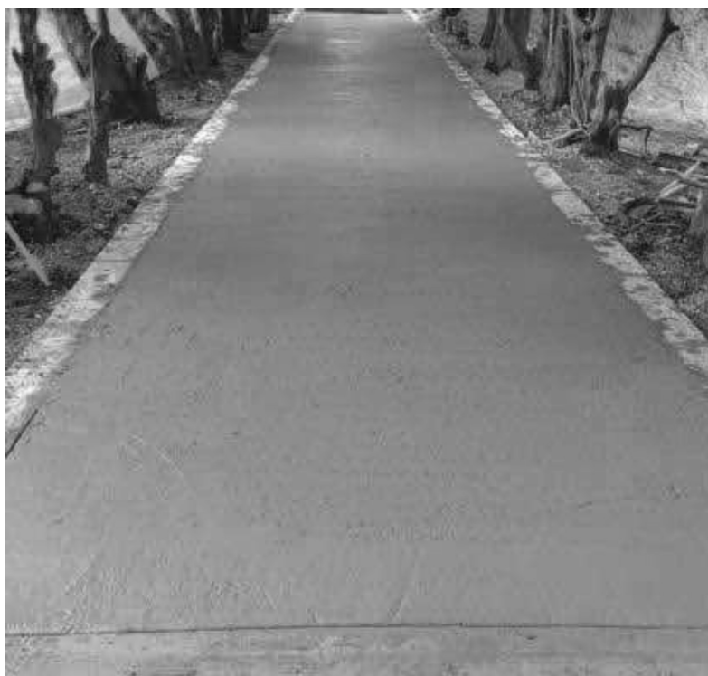
Vaciado en concreto del sendero peatonal que comunica las aulas.
