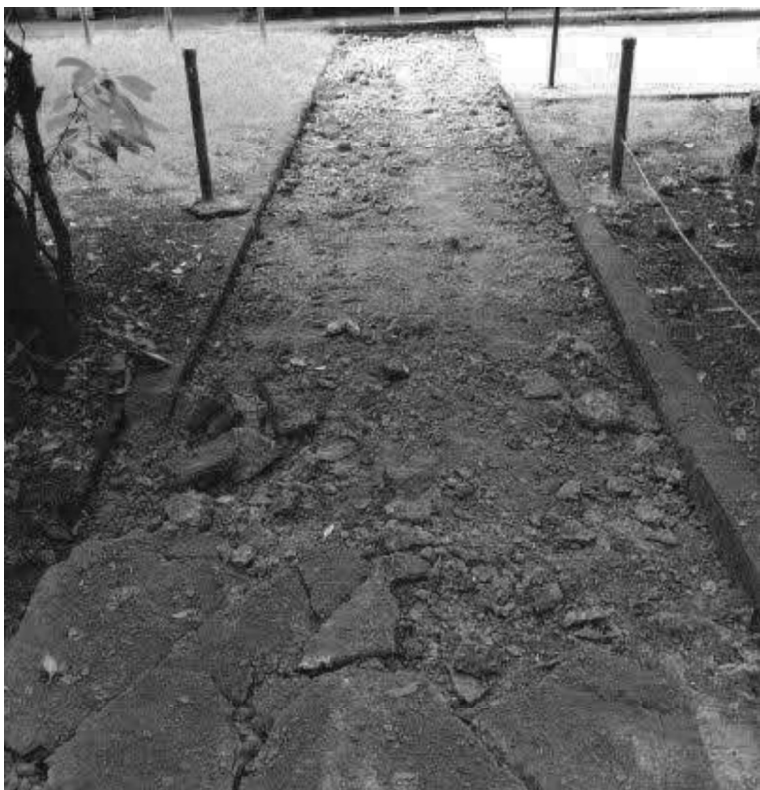
Demolición del sendero peatonal que va desde los salones a dile de Usaquéen.
