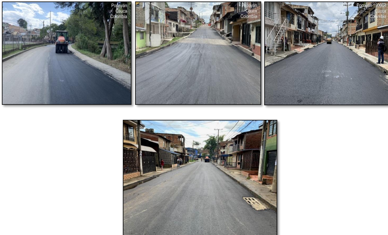
Ilustración 3 Fotografías No. 1, 2 y 3: Instalación y compactación de mezcla asfáltica, Calle 9A entre Carreras 23 y 28 Barrio Tomas Cipriano; Carrera 28 entre Calles 9A y 10 Barrio Tomas Cipriano; Carrera 27A entre Calles 8 y 9 Barrio Santa Helena y Calle 14 entre Carreras 23 y 25 del Barrio Chapinero.
