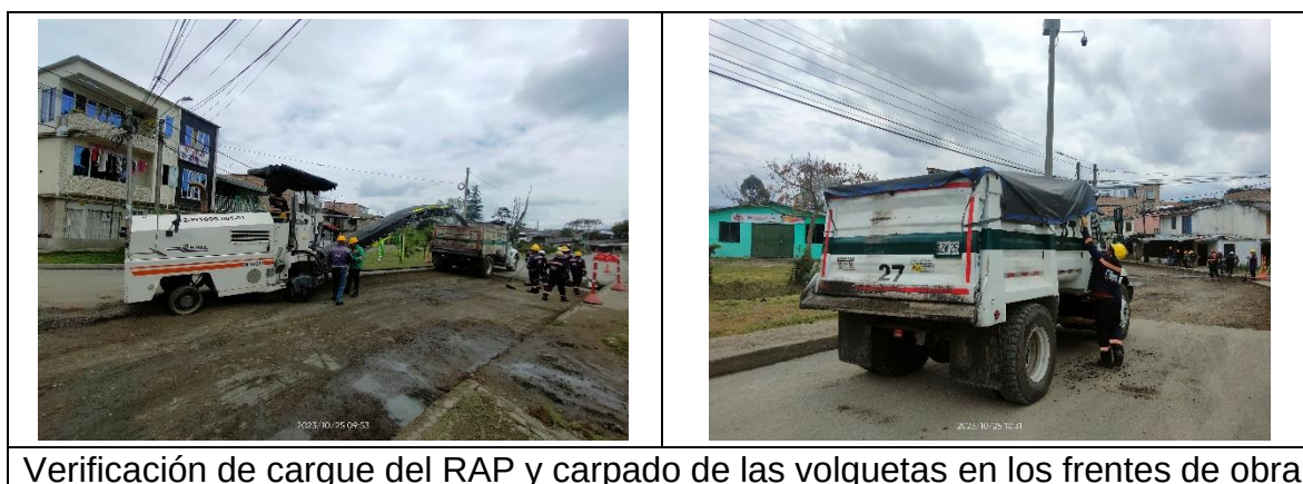
Foto 5. Cargue, transporte de Rap y carpado de las volquetas
