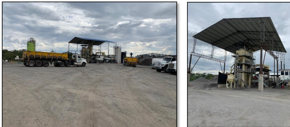
Ilustración 5 Fotografías No 3 y 4: Planta Popayán – Producción de Mezcla Asfáltica. K6 Variante Sur Popayán - Cali.
