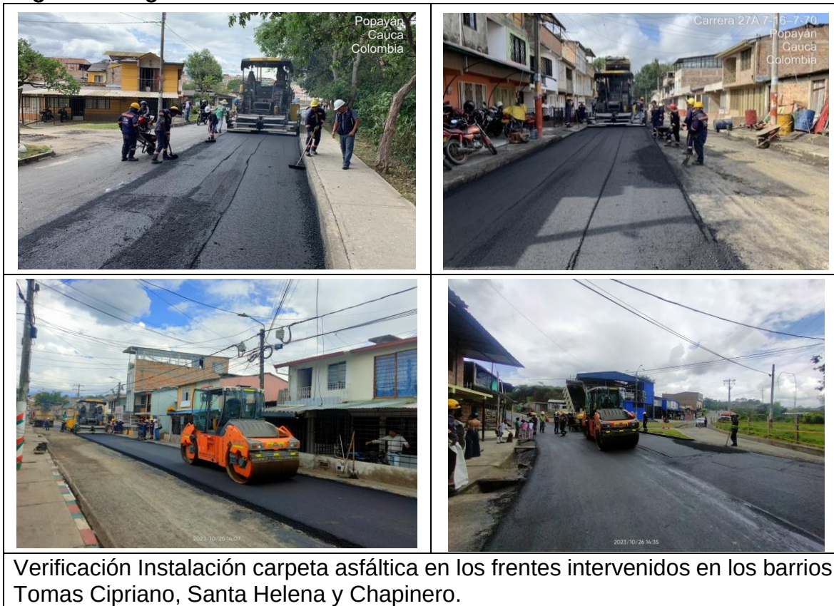
Foto 3. Instalación carpeta asfáltica
