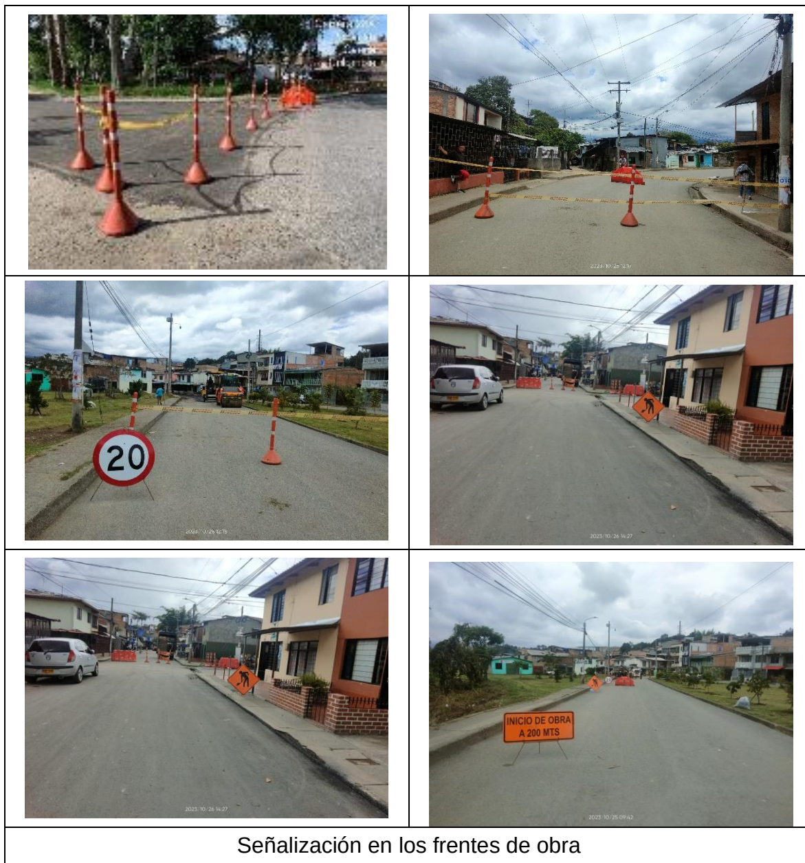
Foto 4. Instalación de Dispositivos y Canalización PMT
