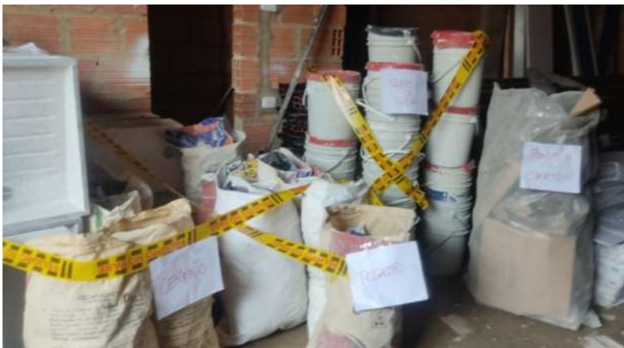
SEÑALIZACION DE RESIDUOS PELIGROSOS Y QUIMICOS DURANTE EL MES DE MARZO.
