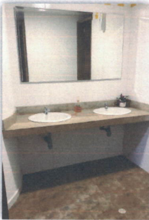
Batería de Baños
