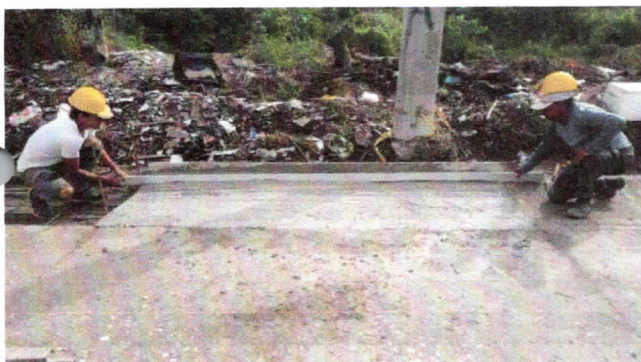
Imagen 3. Cuneta de Concreto Vaciada In Situ; no incluye la conformación de la superficie de apoyo
