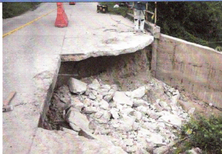
Imagen 2. Demolición de placa de pavimento en concreto e=0,15-0,20m
