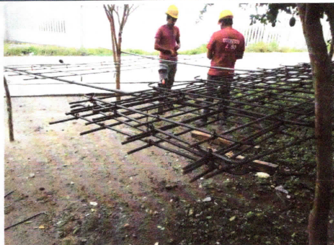
Imagen 2. ACERO DE REFUERZO F_y=420 Mpa de Refuerzo para losas irregulares \phi 1/2" . Incluye suministro, transporte, instalación, y demás actividades para su correcta colocación en obra
