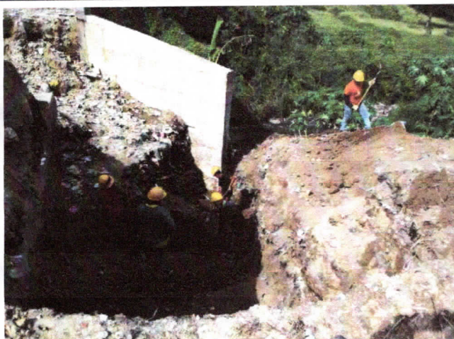
Imagen 1. Excavación manual en material común para conformación de estructura de pavimento según diseño. INV 210-13
