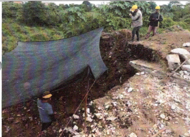
Imagen 3. Excavación manual en material común para conformación de estructura de pavimento según diseño. INV 210-13
