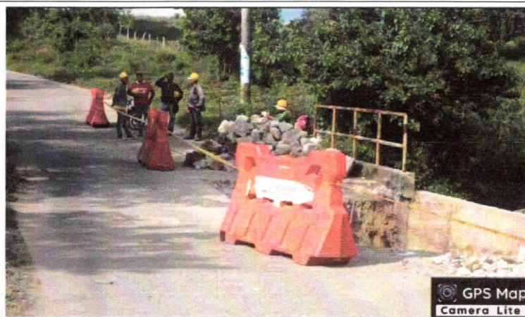
Imagen 4. Area de intervencion señalizada.
