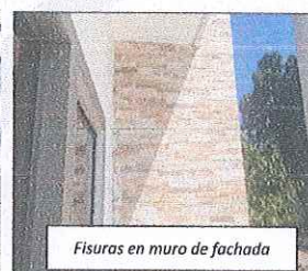
Fisuras en muro de fachada
