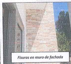
Fisuras en muro de fachada
