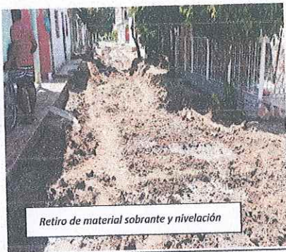
Retiro de material sobrante y nivelación
