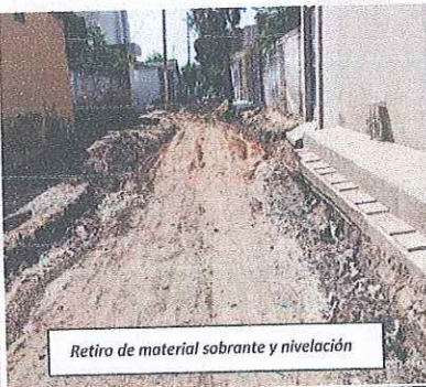
Retiro de material sobrante y nivelación
