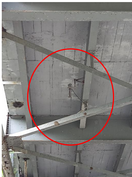
Fotografía 13. Cable de conexión del sensor de nivel estación Río Jerez.
