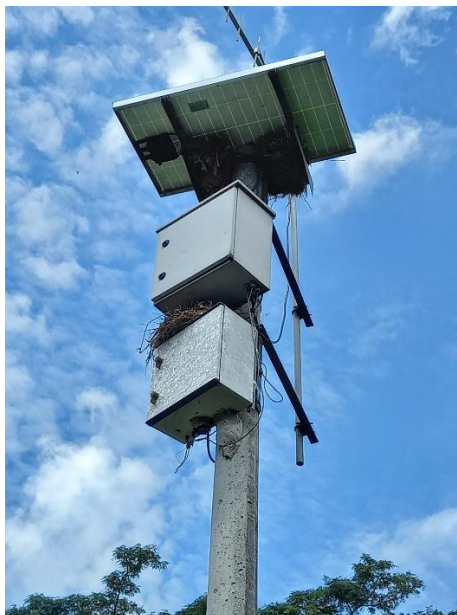
Fotografía 15. Paneles solares, batería y equipos electrónicos estación Río Tapias.
