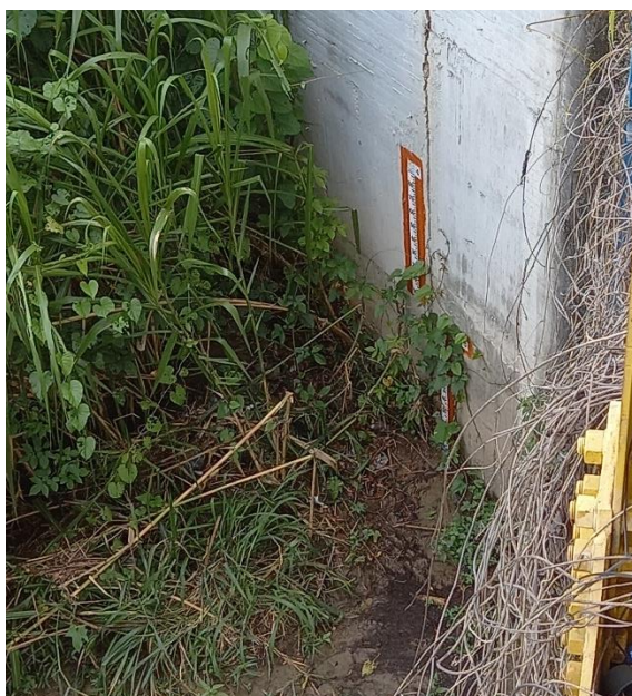
Fotografía 9. Reglilla de medición manual del nivel del río estación Río Cañas.
