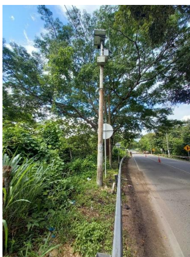
Fotografía 5. Vista general estación Río Cañas.
