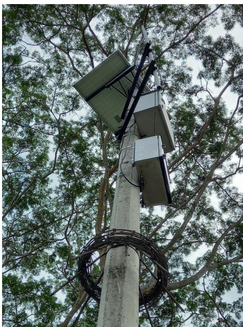
Fotografía 11. Paneles solares, batería y equipos electrónicos estación Río Jerez.
