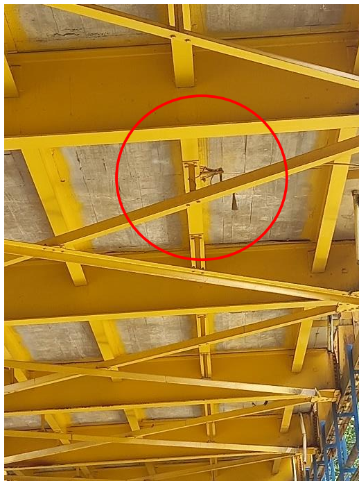
Fotografía 7. Sensor de medición de nivel de río estación Río Cañas.
