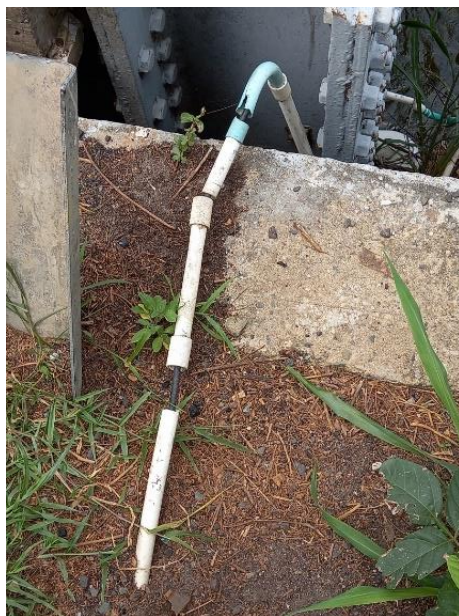
Fotografía 13. Cable de conexión del sensor de nivel estación Río Jerez.
