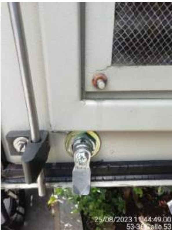
Instalación de chapas auxiliares
