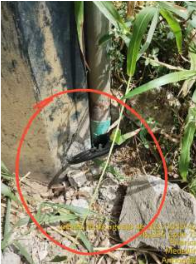
Atención y reporte de daños en acometida eléctrica
