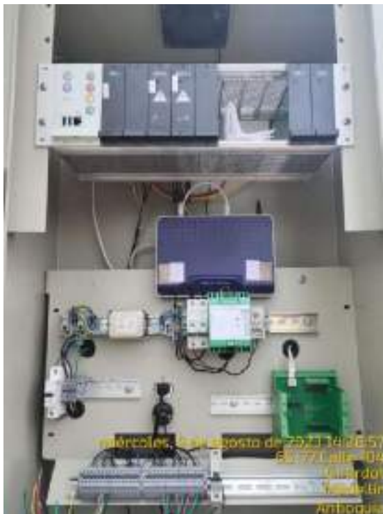
Instalación y configuración de LCs referencia FlowNode
