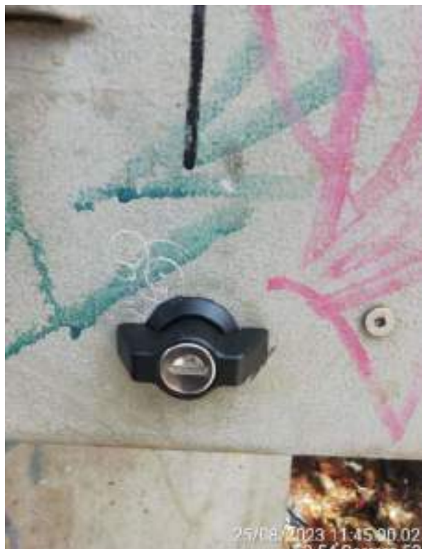
Instalación de chapas auxiliares
