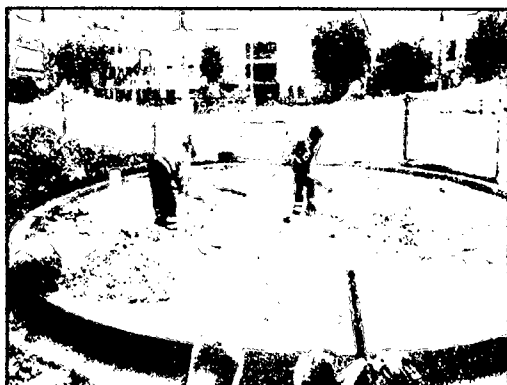
Relleno compactado en base granular
