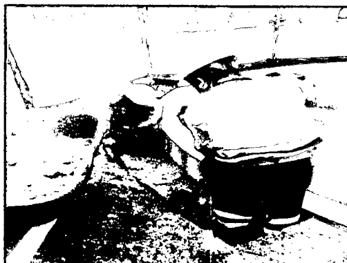
Instalación bordillo prefabricado A-80
