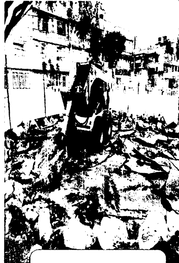
Demolición de pavimento asfáltico y bordillo
